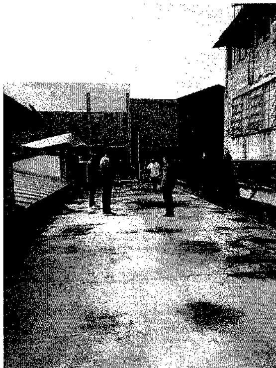
Brinde apoyo en la revisión de goteras.
