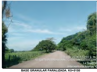
BASE GRANULAR PARALIZADA. K5+0150
