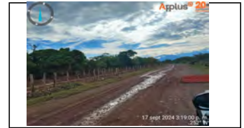
SUBBASE GRANULAR PARALIZADA. K6+0310
