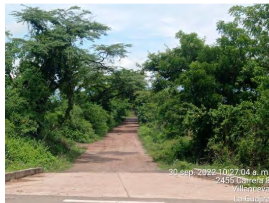
Fotografía 2 Estado actual de la vía. Contrato 104-2022
