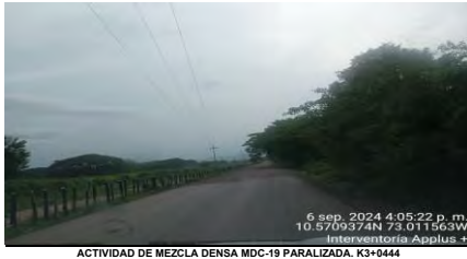
ACTIVIDAD DE MEZCLA DENSA MDC-19 PARALIZADA. K3+0444
