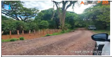
ACTIVIDADES DE TERRAPLENES PARALIZADAS K9+0150
