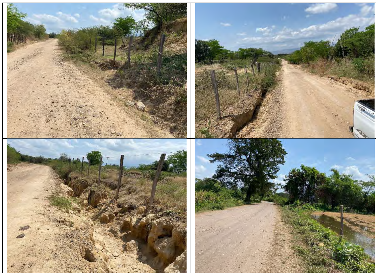
figura 2. Estado actual de la vía tramo 1.
