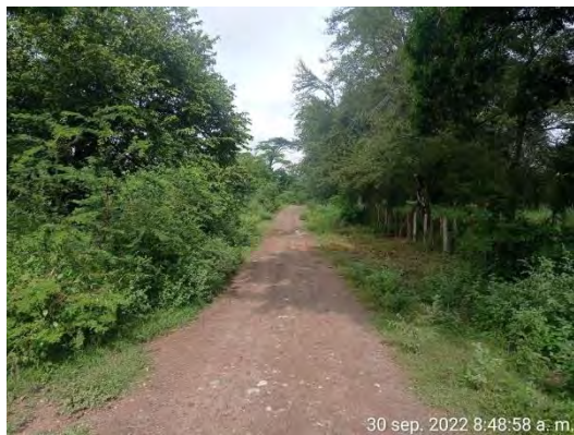
Fotografía 1 Estado actual de la vía. Contrato 104-2022
