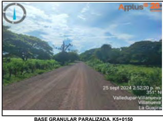
BASE GRANULAR PARALIZADA. K5+0150
