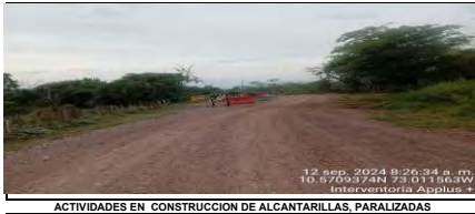
ACTIVIDADES EN CONSTRUCCION DE ALCANTARILLAS, PARALIZADAS
