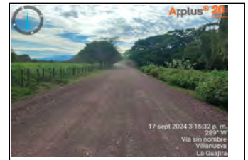
BASE GRANULAR PARALIZADA. K5+0150
