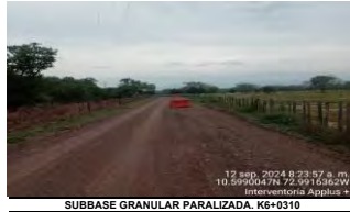
SUBBASE GRANULAR PARALIZADA. K6+0310
