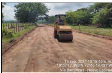
Actividad: Compactación de Terraplén, Tramo 1
