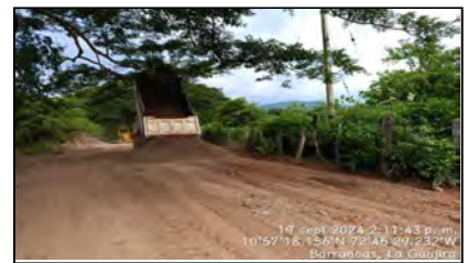
Actividad: Instalación de Material de Terraplén, Tramo 1
