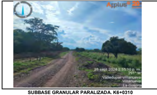
SUBBASE GRANULAR PARALIZADA. K6+0310
