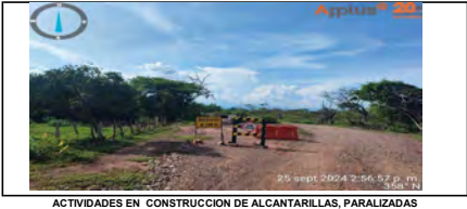
ACTIVIDADES EN CONSTRUCCION DE ALCANTARILLAS, PARALIZADAS
