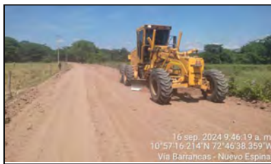
Actividad: Conformación de Material de Terraplén, Tramo 1
