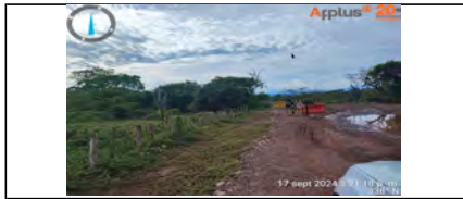
ACTIVIDADES EN CONSTRUCCION DE ALCANTARILLAS, PARALIZADAS
