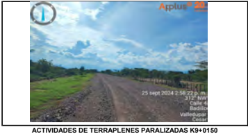
ACTIVIDADES DE TERRAPLENES PARALIZADAS K9+0150
