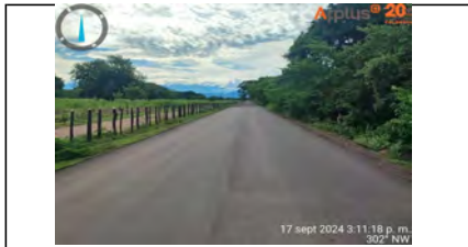
ACTIVIDAD DE MEZCLA DENSA MDC-19 PARALIZADA. K3+0444
