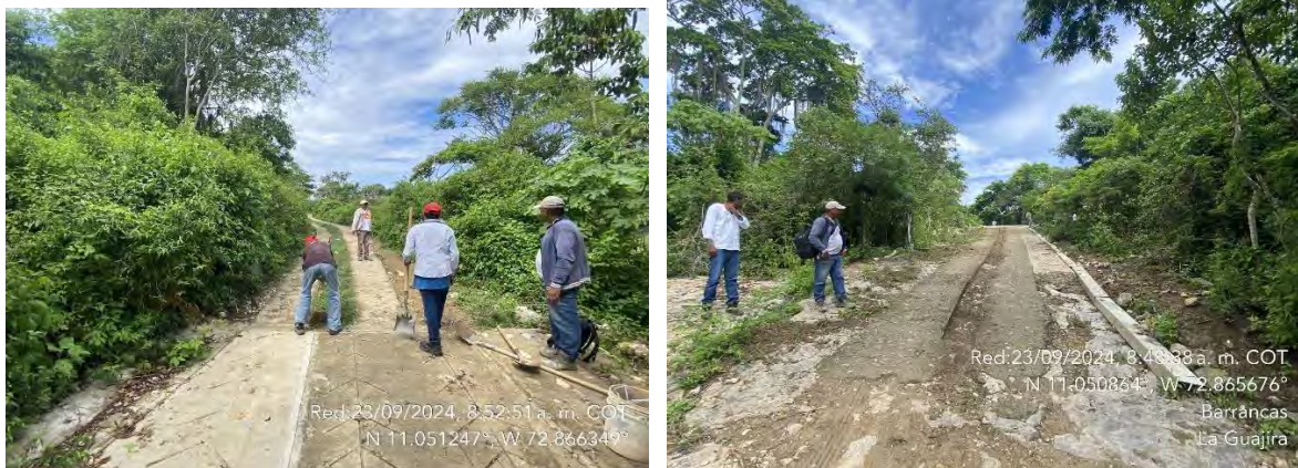
Registro fotográfico ejecución de protecciones en sitios críticos
