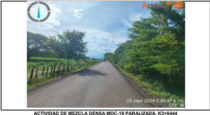
ACTIVIDAD DE MEZCLA DENSA MDC-19 PARALIZADA. K3+0444
