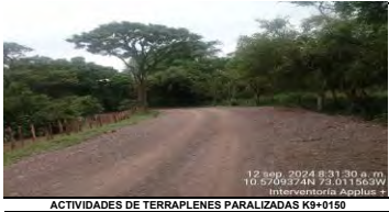
ACTIVIDADES DE TERRAPLENES PARALIZADAS K9+0150
