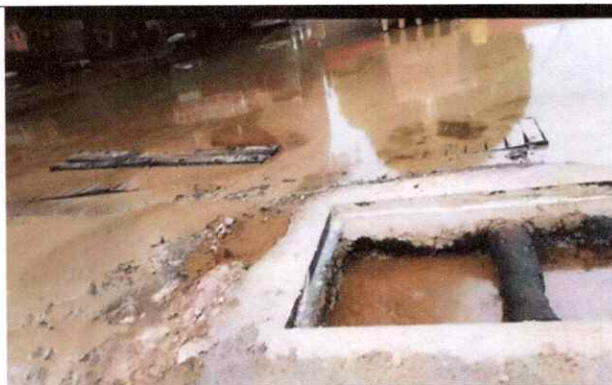
Reporte contaminación ambiental Transversal 2 calle 7
