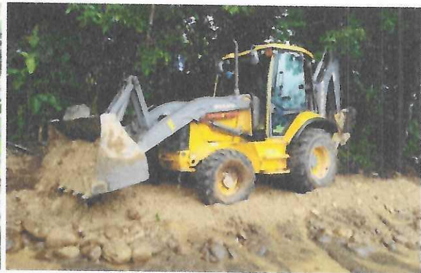
Figura 33: Tendido de material vía terciaria.
