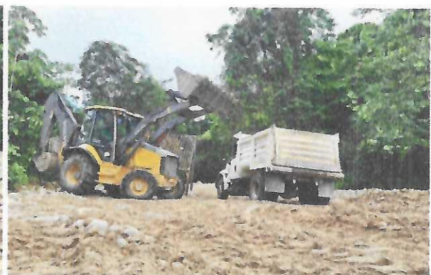
Figura 5: Cargue de material vía terciaria.
