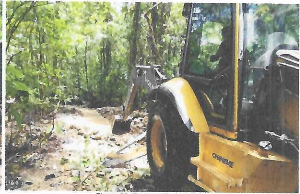
Figura 26. Escorrentía de aguas.
