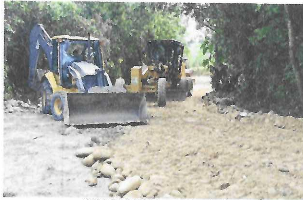
Figura 36: Tendido de material para la vía.
