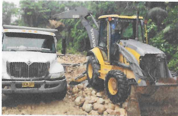
Figura 8: Cargue de material para la vía.
