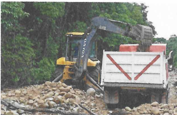
Figura 6: Cargue de material para la vía.
