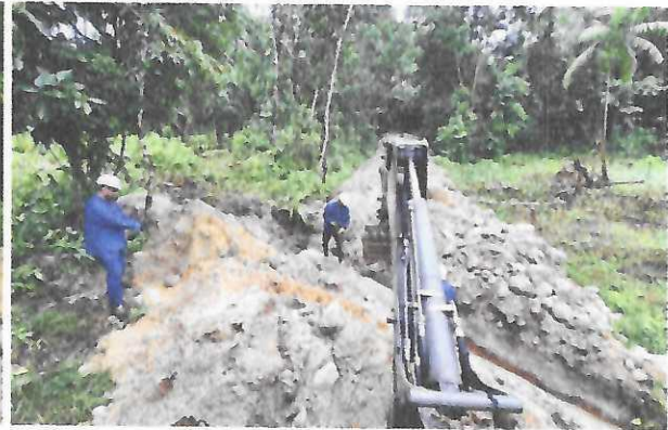
Figura 20: Ubicación de tubería de Alcantarillado
