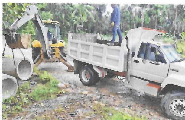
Figura 17: Cargue de tubería.
