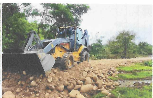
Figura 12: Tendido de material sobre vía.
