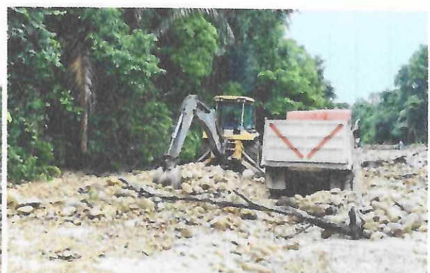
Figura 7: Cargue de material vía terciaria.
