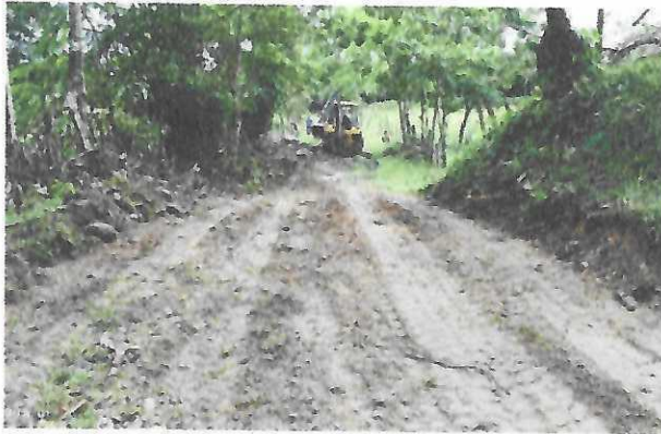
Figura 30: Vía de acceso para cargue de volquetas.
