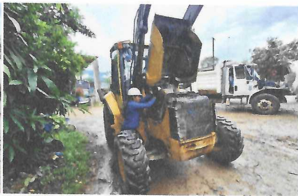
figura 44: Revisión de filtros.
