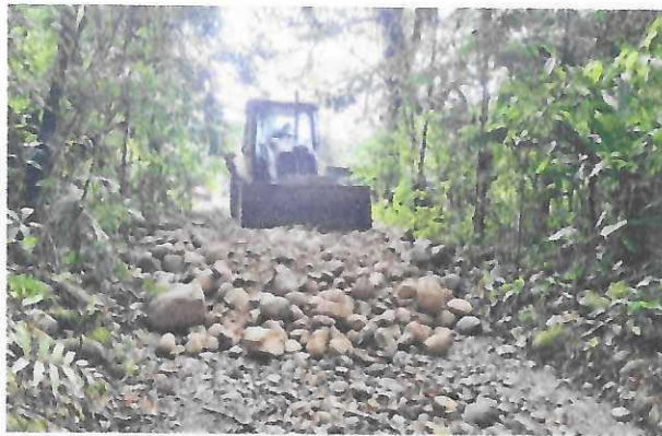
Figura 9: Tendido de material.
