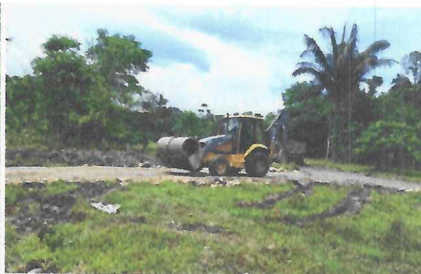
Figura 16: Cargue y transporte de tubería para alcantarillado.
