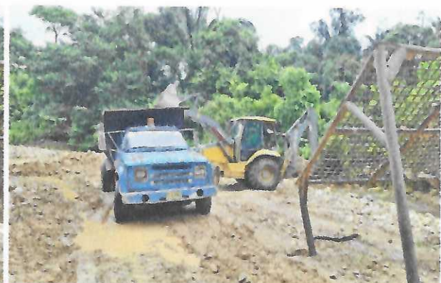
Figura 3: Cargue de material vía terciaria.
