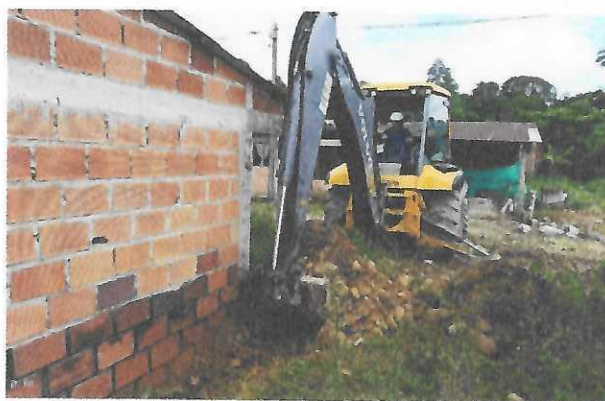
Figura 49: Realización de cuneta.
