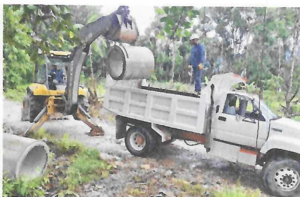
Figura 18: Cargue de material vía terciaria.
