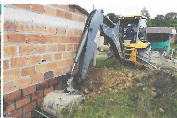
Figura 48: Excavación para drenaje de Aguas.
