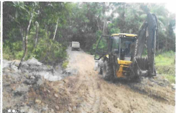
Figura 22: Transporte de tubería.
