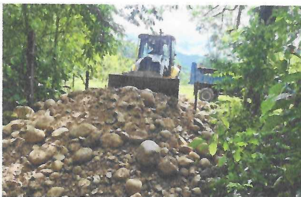
Figura 11: Tendido de material para vía de acceso.
