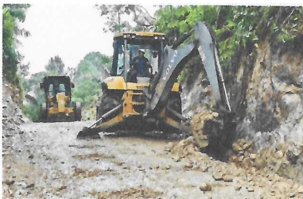
Figura 23: Excavación para cunetas.
