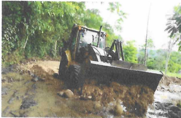
Figura 32: Tendido de material para la vía.
