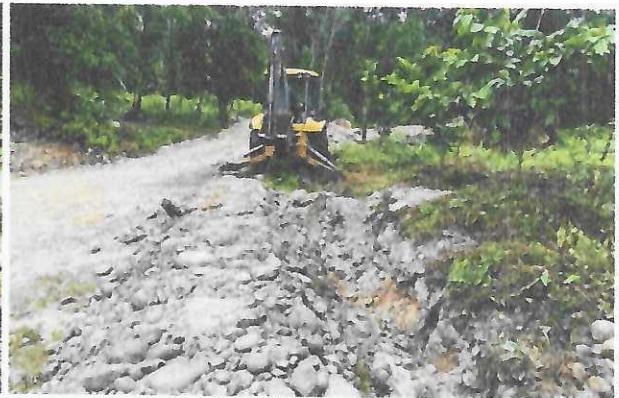
Figura 28. Realización de cunetas.
