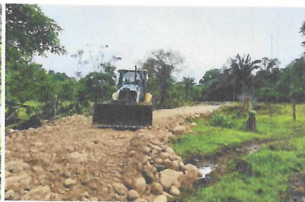
Figura 14: Tendido de material.
