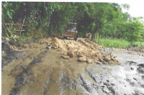
Figura 34: Tendido de material para la vía.
