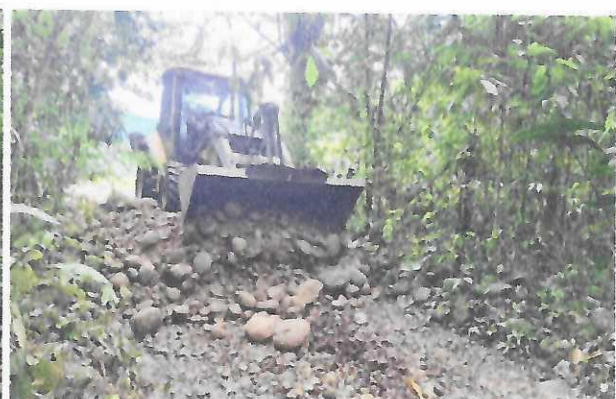
Figura 10: Tendido de material vía terciaria.
