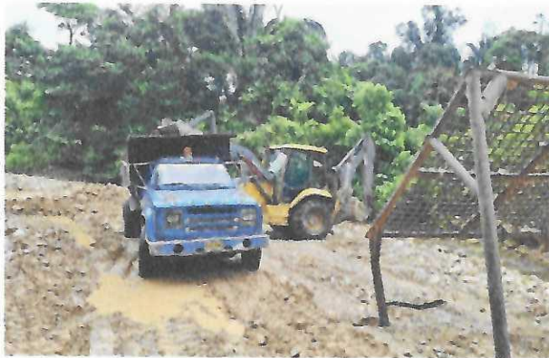
Figura 2: Cargue de material para la vía.
