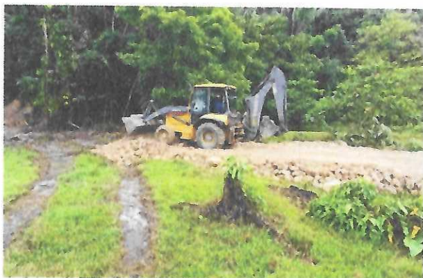
Figura 13: Tendido de material.
