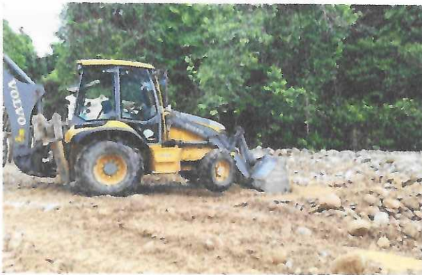
Figura 4: Cargue de material para la vía.
