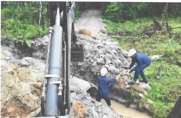
Figura 21: Descargue de tubería.
