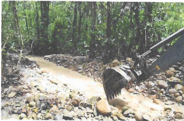
Figura 25. Cuneta para drenaje de Aguas.
