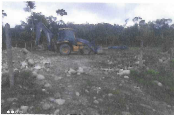
Figura 50: Replanteo de lote.
