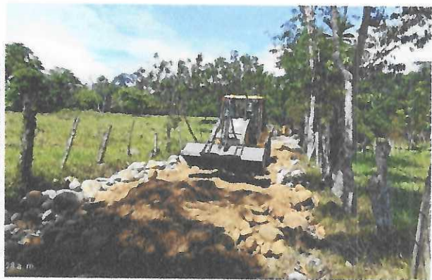
Figura 35: Tendido de material vía terciaria.
