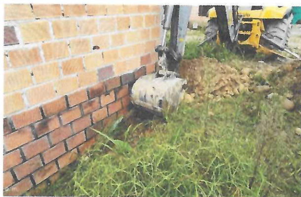
Figura 47: Cuneta para drenaje de aguas lluvias.
