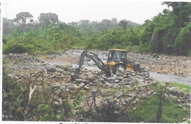
Figura 31: Vía de acceso para volquetas.
