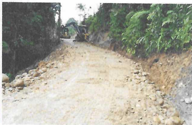
Figura 24: Realización de cunetas sobre la vía.
