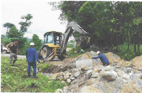
Figura 19: Instalación de tubería para alcantarillado.
