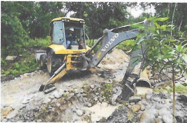
Figura 27. Drenaje de aguas.
