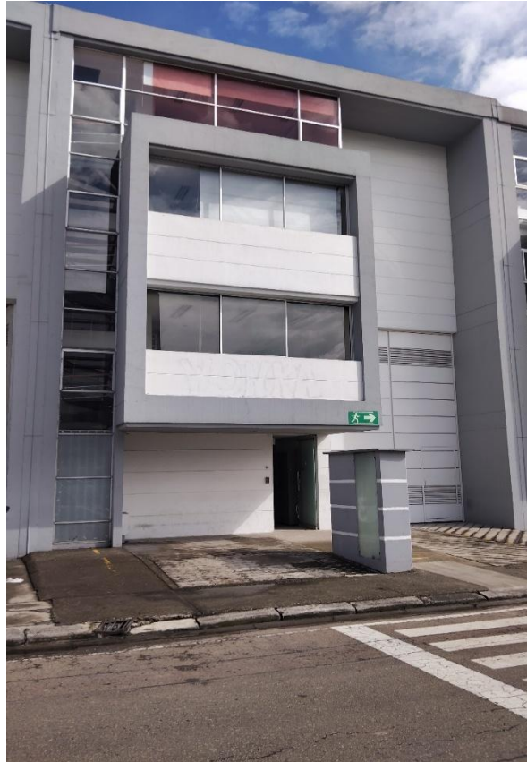
Imagen 2. Fachada Bodega I
