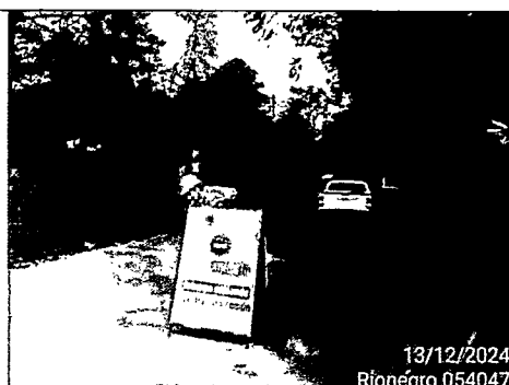
Instalación de Valla informativa en obra
