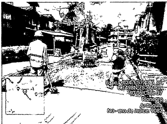
Foto 15. Aplicación de base granular barrio obrero
