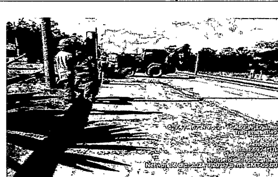
Foto 8. Imprimación y aplicación de mezcla asfáltica MDC-19 sector vía vieja marinilla
