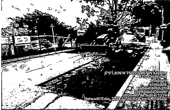
Foto 5. Levantamiento del pavimento existente fisurado sector la UCO
