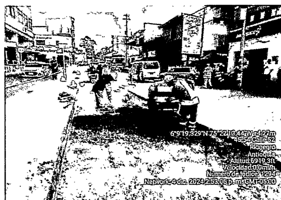
Foto 16. Aplicación de base granular sector la pola
