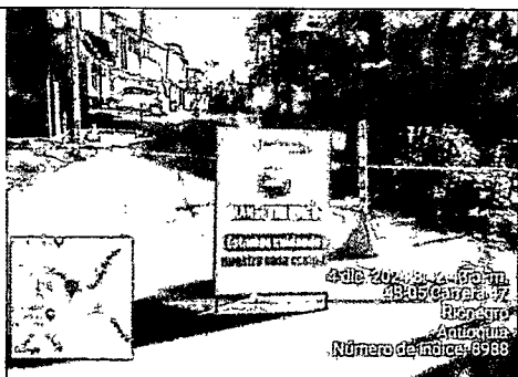
Valla informativa en obra
