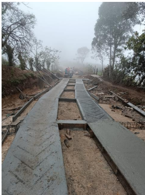
Fotos 40 – 41 CONSTRUCCION PLACA HUELLA TRAMO 1
