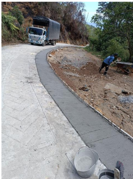
Fotos 42 – 43 CONSTRUCCION PLACA HUELLA TRAMO 1
