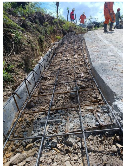
Fotos 36 – 37 CONSTRUCCION PLACA HUELLA TRAMO 1
