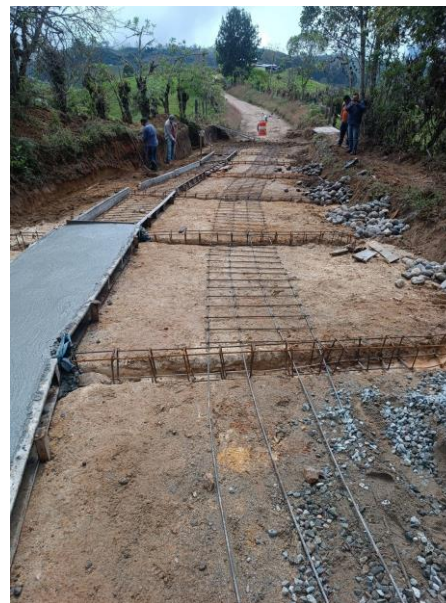
Fotos 32 – 33 CONSTRUCCION PLACA HUELLA TRAMO 1
