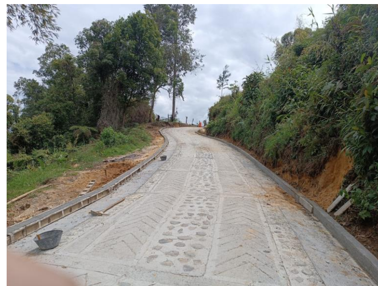
Fotos 42 – 43 CONSTRUCCION PLACA HUELLA TRAMO 1
