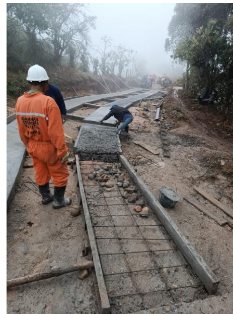
Fotos 34 – 35 CONSTRUCCION PLACA HUELLA TRAMO 1
