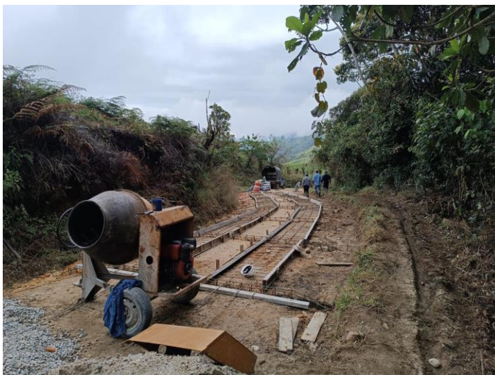
Fotos 34 – 35 CONSTRUCCION PLACA HUELLA TRAMO 1
