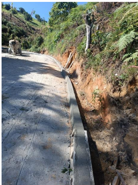
Fotos 46 – 47 CONSTRUCCION PLACA HUELLA TRAMO 1
