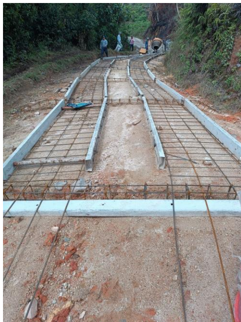
Fotos 30 – 31 CONSTRUCCION PLACA HUELLA TRAMO 1
