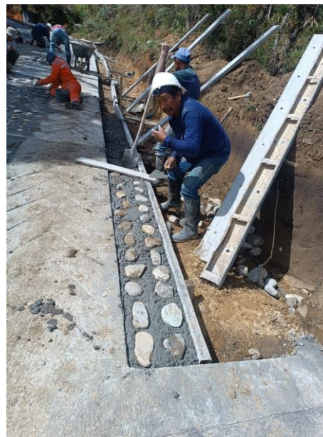
Fotos 38 – 39 CONSTRUCCION PLACA HUELLA TRAMO 1
