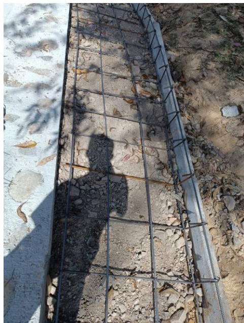
Fotos 36 – 37 CONSTRUCCION PLACA HUELLA TRAMO 1
