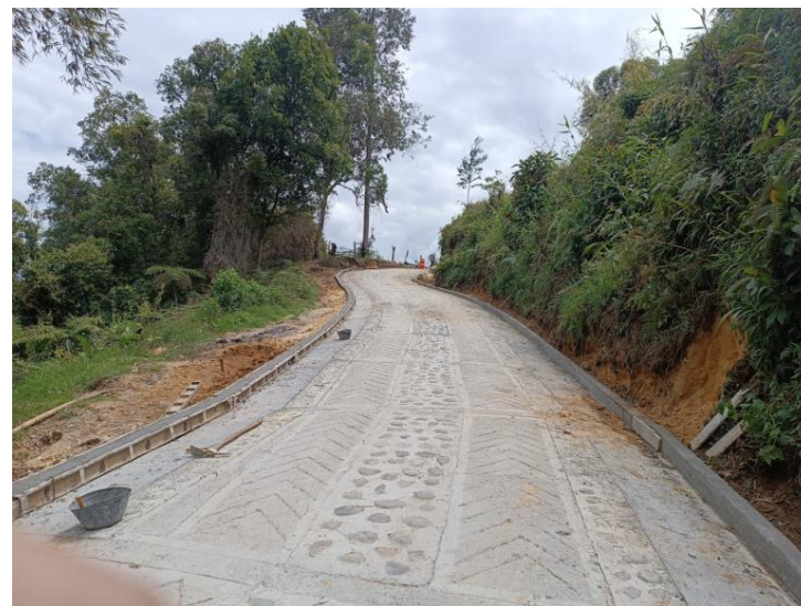
Fotos 48 – 49 CONSTRUCCION PLACA HUELLA TRAMO 1
