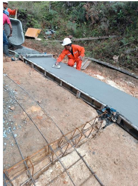
Fotos 40 – 41 CONSTRUCCION PLACA HUELLA TRAMO 1
