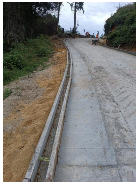
Fotos 44 – 45 CONSTRUCCION PLACA HUELLA TRAMO 1
