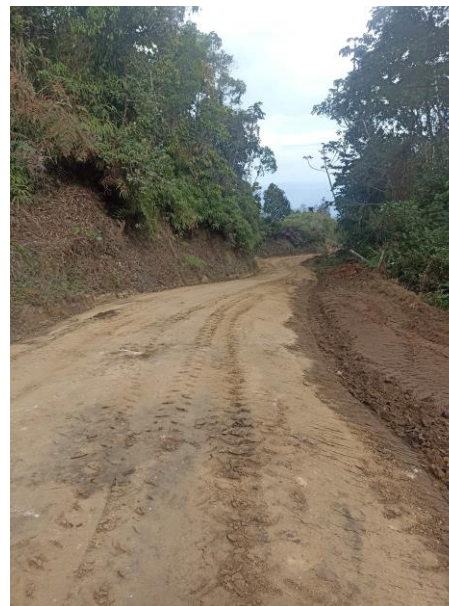
Fotos 25 – 26 CONSTRUCCION PLACA HUELLA TRAMO 1
