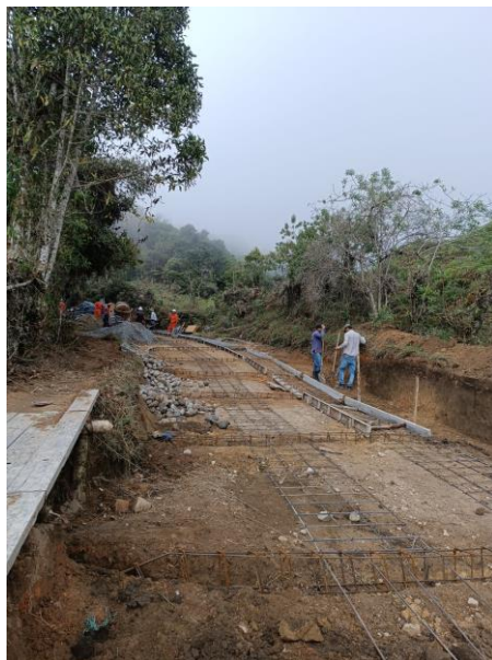
Fotos 32 – 33 CONSTRUCCION PLACA HUELLA TRAMO 1
