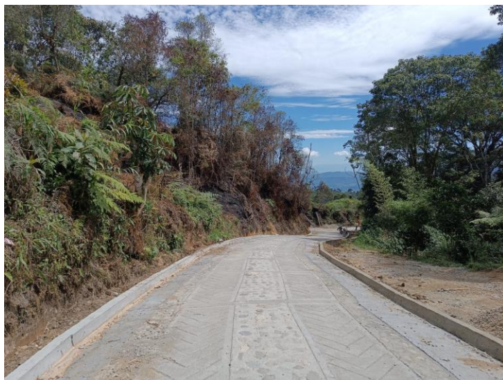
Fotos 48 – 49 CONSTRUCCION PLACA HUELLA TRAMO 1
