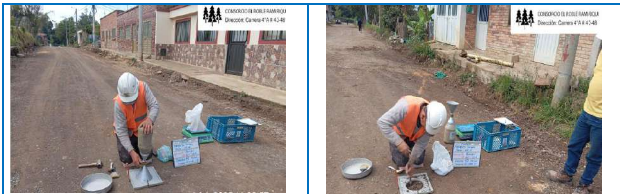
Foto # 1 Toma de Densidades al material de afirmado y subbase
