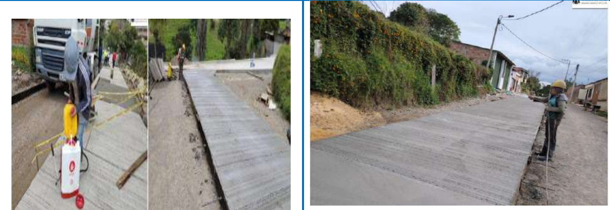
Foto # 3 Curado de concreto por medio de Antisol y agua durante el tiempo de fraguado del concreto MR 5
