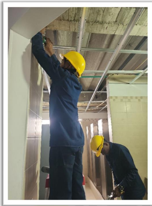
Imagen 13 y 14: Instalación Cielo Raso Pvc 7 Mm.
