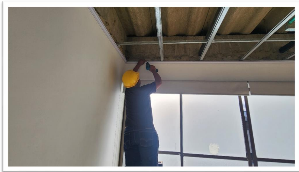
Imagen 16: Instalación Cielo Raso Pvc 7 Mm.
