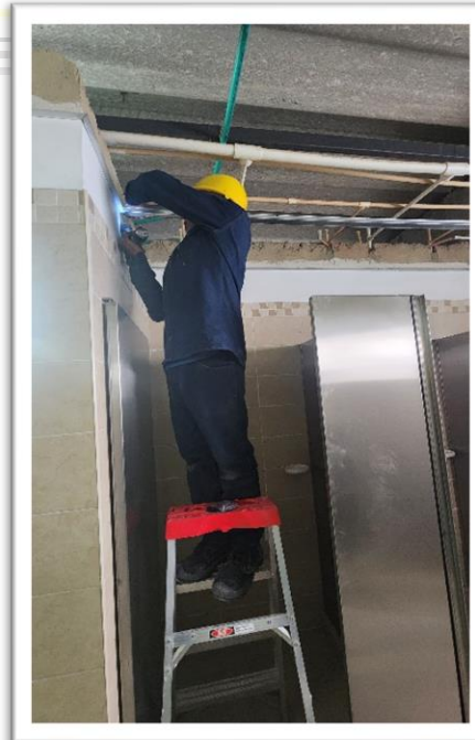
Imagen 11 y 12: Instalación Cielo Raso Pvc 7 Mm.
