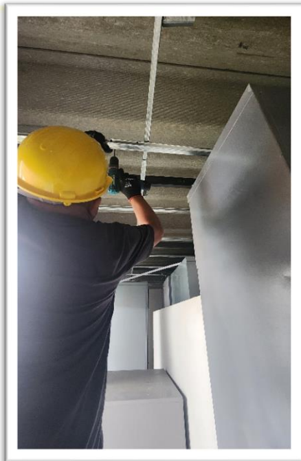
Imagen 11 y 12: Instalación Cielo Raso Pvc 7 Mm.
