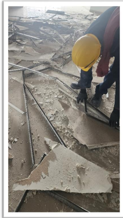
Imagen 9 y 10: Desmonte De Cielorraso. Incluye Desmonte De Estructura.
