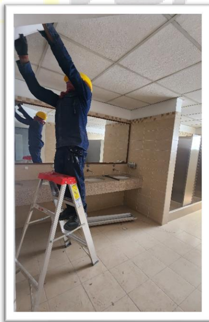
Imagen 7 y 8: Desmonte De Cielorraso. Incluye Desmonte De Estructura.
