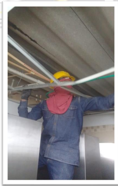
Imagen 7 y 8: Desmonte De Cielorraso. Incluye Desmonte De Estructura.
