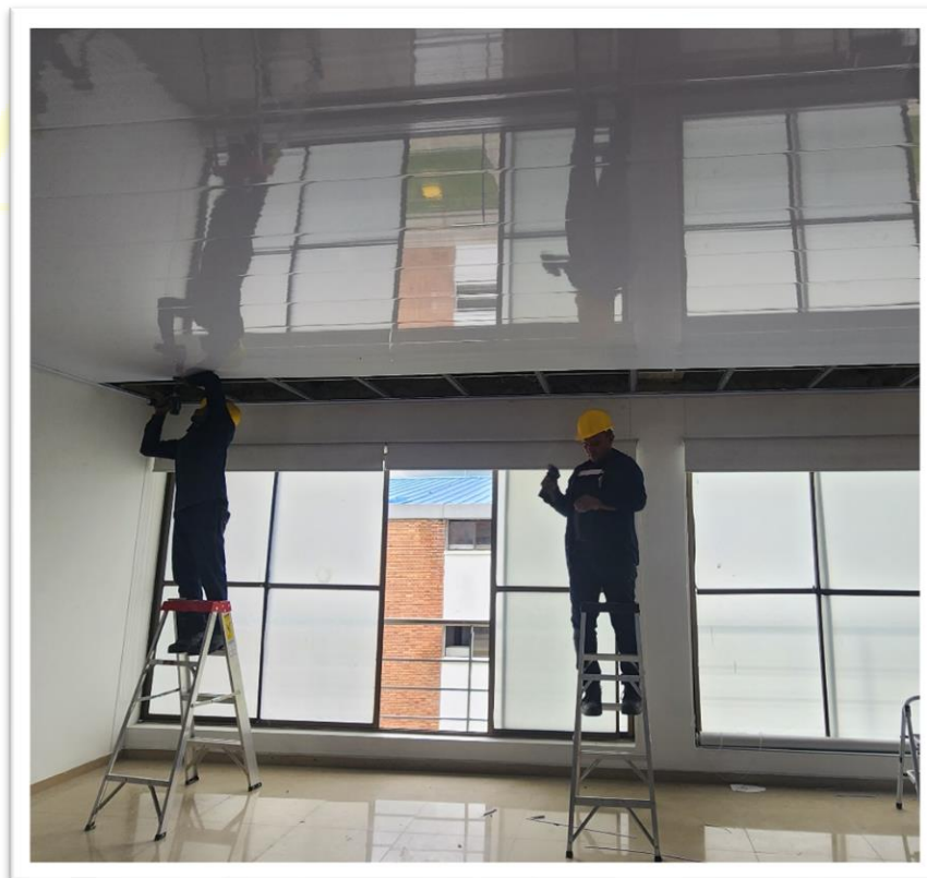
Imagen 17: Instalación Cielo Raso Pvc 7 Mm.
