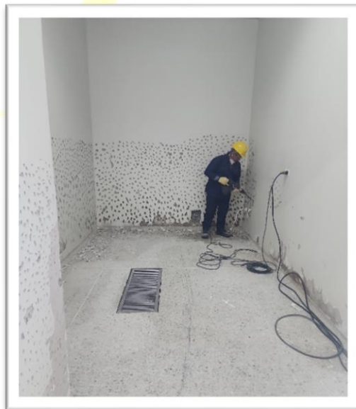
Imagen 3 y 4: Picado De Superficie De Muro. Adecuación De Zona Para Enchape.
