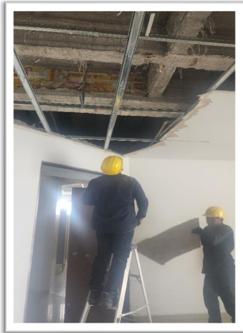
Imagen 5 y 6: Desmonte De Cielorraso. Incluye Desmonte De Estructura.
