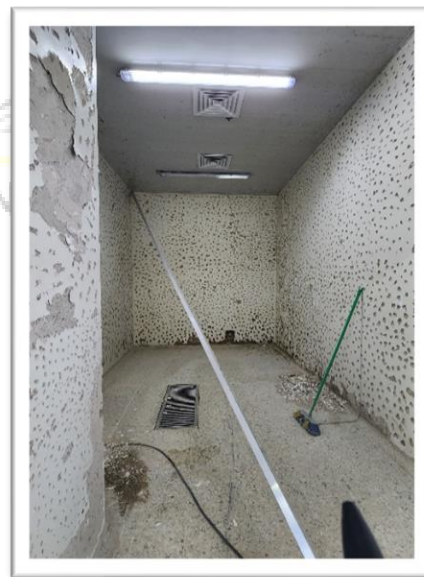
Imagen 3 y 4: Picado De Superficie De Muro. Adecuación De Zona Para Enchape.
