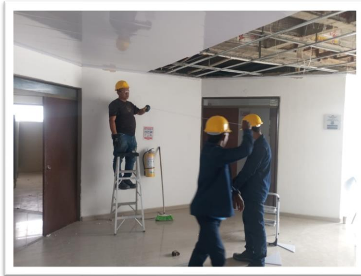
Imagen 18: Instalación Cielo Raso Pvc 7 Mm.
