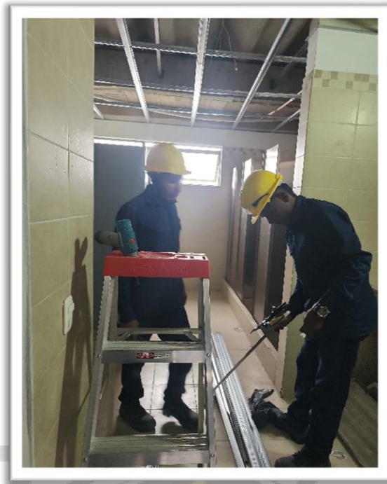
Imagen 13 y 14: Instalación Cielo Raso Pvc 7 Mm.
