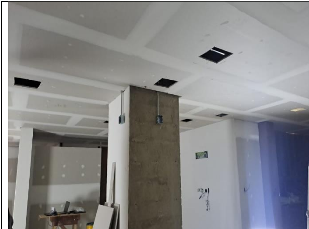
1. apertura cajas inspección
