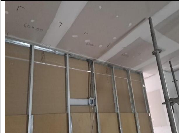
19. marcación de cajas inspección2
