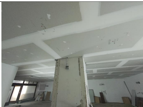
18. marcación de cajas inspección
