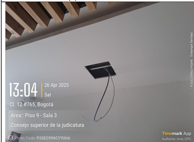
7. instalación de Infraestructura de datos (11)
