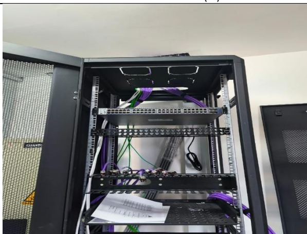
20. Instalación de equipos en rack3
