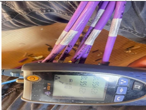
32. prueba y marquillado de puntos (6)
