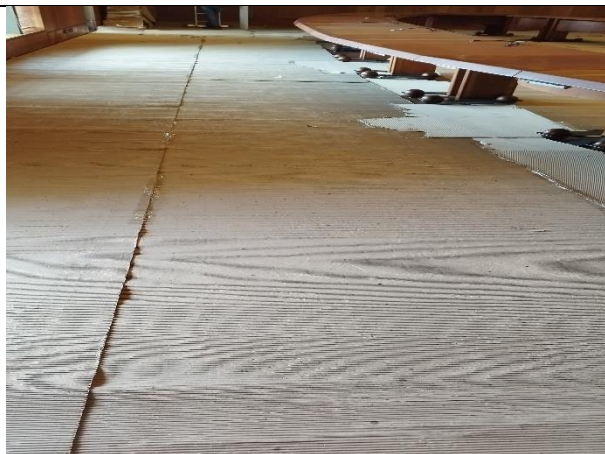
23. Protección piso CS
