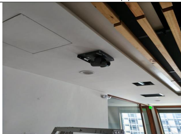
15. Instalación de cámaras (5)
