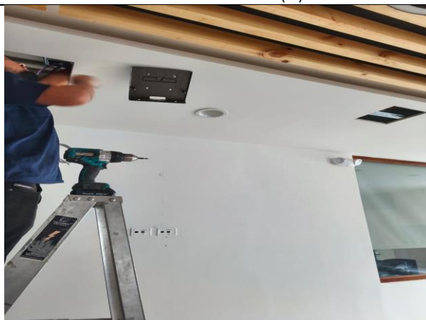
16. Instalación de cámaras (6)
