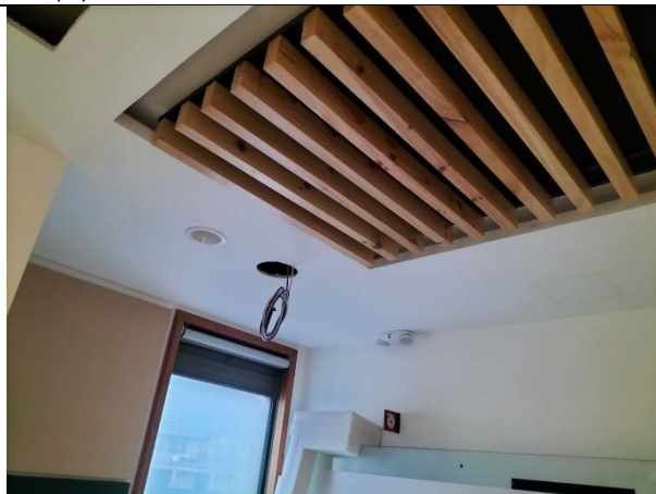
12. instalación de Infraestructura de datos (4)
