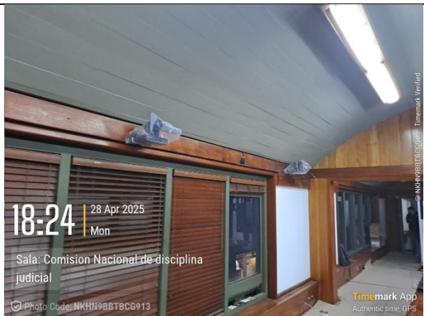
2. instalación de cámaras
