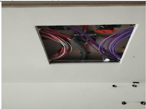
4. instalación acometida eléctrica para pantalla 163 (4)
