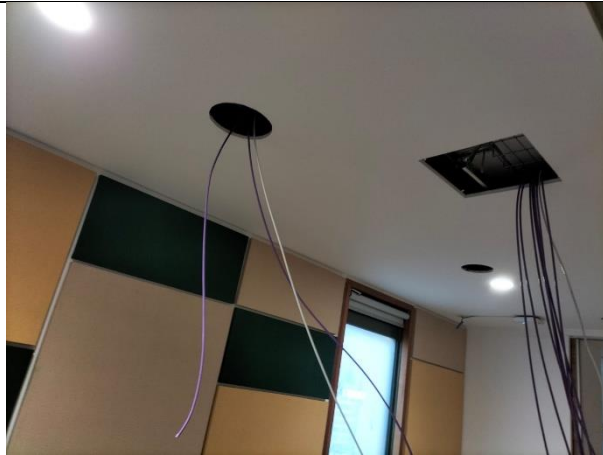
10. instalación de Infraestructura de datos (2)
