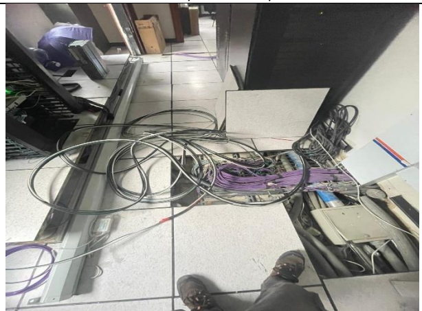
14. Instalación acometida eléctrica pantalla 5x3 (3)
