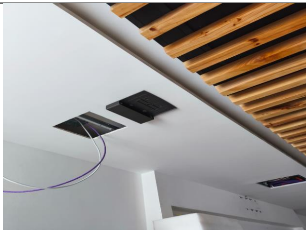
17. Instalación de cámaras (7)
