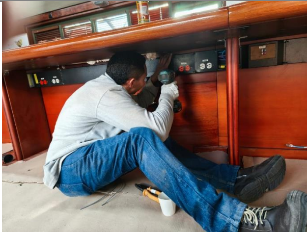
9. cierre de canaletas (2)
