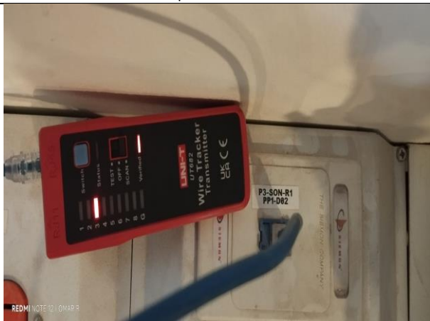
28. verificación puntos de red CS2
