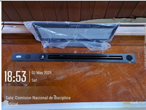
12. instalación de pantallas retractiles y nameplate2
