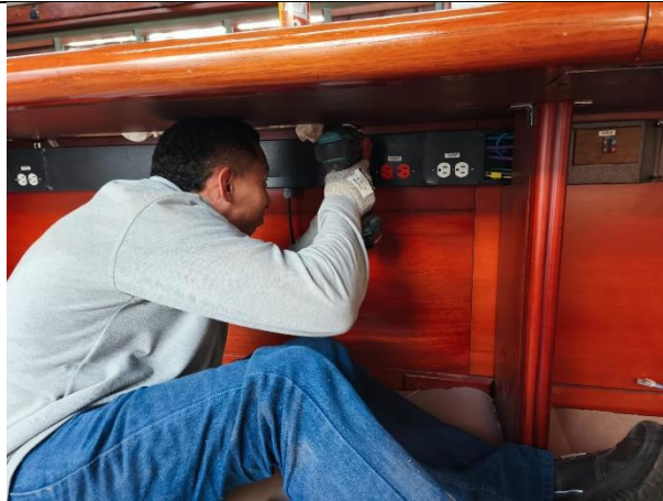
10. cierre de canaletas
