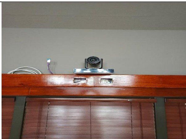
10. instalación de cámaras-
