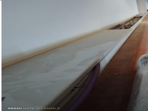
12. Desmonte de tapas canaletas
