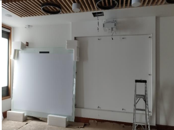
2. desmonte vidrio de proyección_1
