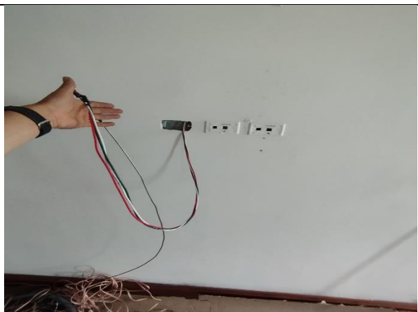
2. instalación acometida eléctrica para pantalla 163 (2)
