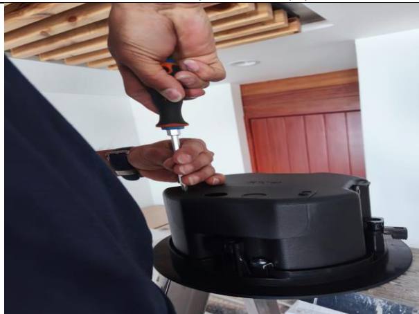
25. Instalación de parlantes (6)
