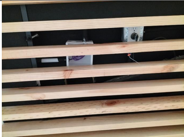
6. instalación de Infraestructura de datos (10)
