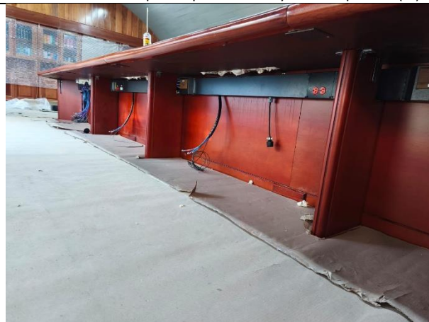
8. cableado para pantallas y nameplate
