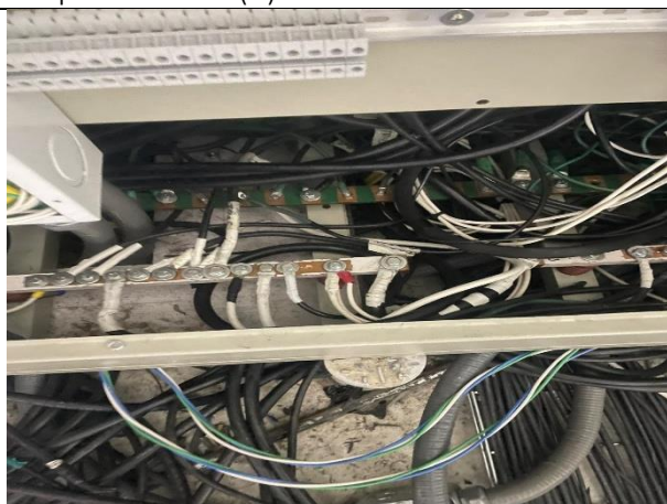
17. Instalación acometida eléctrica pantalla 5x3 (6)
