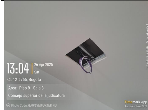
15. instalación de Infraestructura de datos (7)
