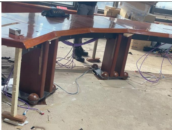
8. Instalación de canaleta (2)
