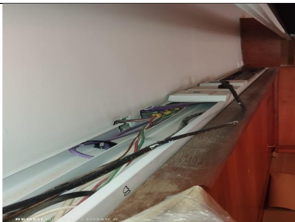
10. Verificación de rutas e infraestructura
