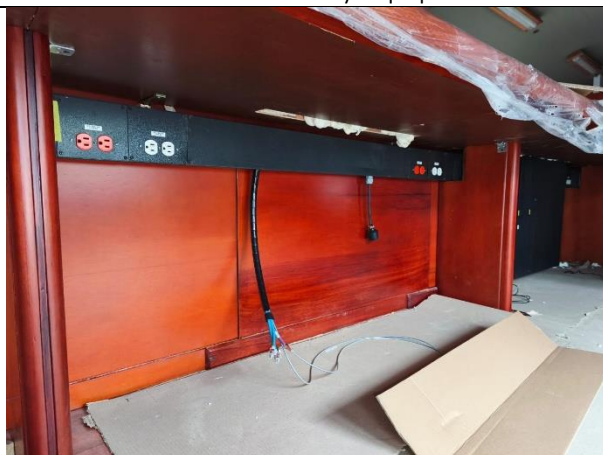
18. termino actividad de puntos, control, eléctricos y comunicación
