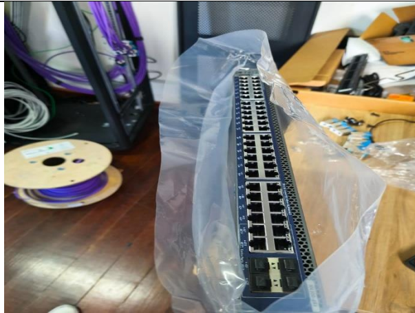
30. instalación equipos en rack2
