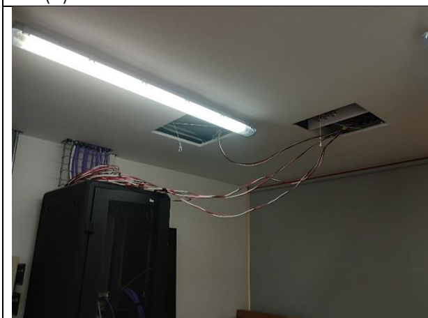
19. instalación de Infraestructura eléctrica (2)
