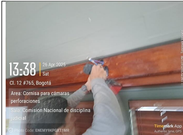
7. Perforaciones para Cámara
