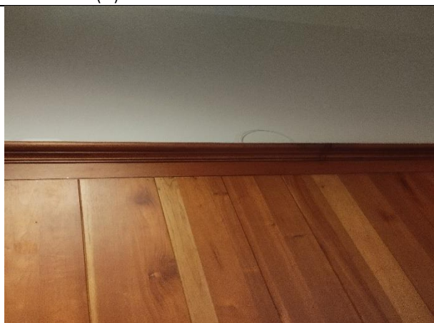
11. cableado para cámara (ubicación Cámara)
