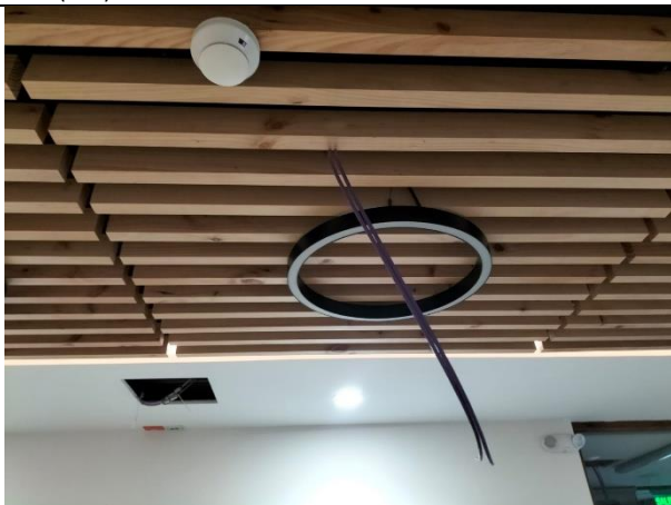
11. instalación de Infraestructura de datos (3)
