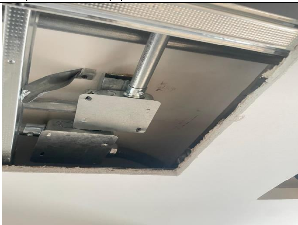
9. instalación acometida eléctrica para pantalla 163 (9)
