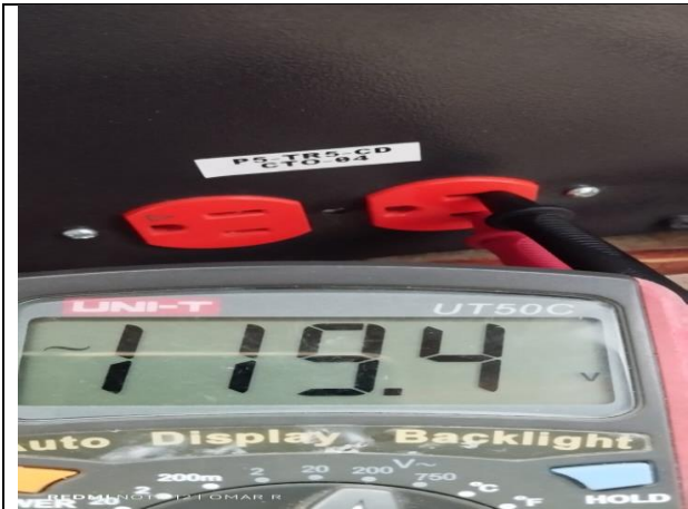
7. Verificación puntos eléctricos
