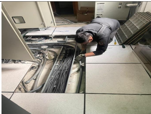
15. Instalación acometida eléctrica pantalla 5x3 (4)
