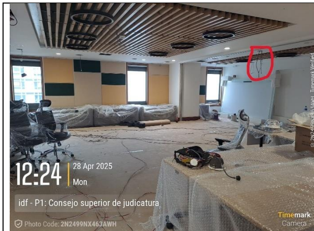
21. Instalación de Infraestructura
