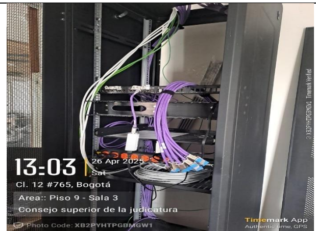
22. Marquillado y ponchado en rack
