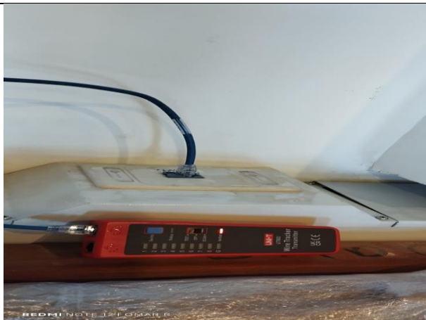
26. verificación puntos de red CS
