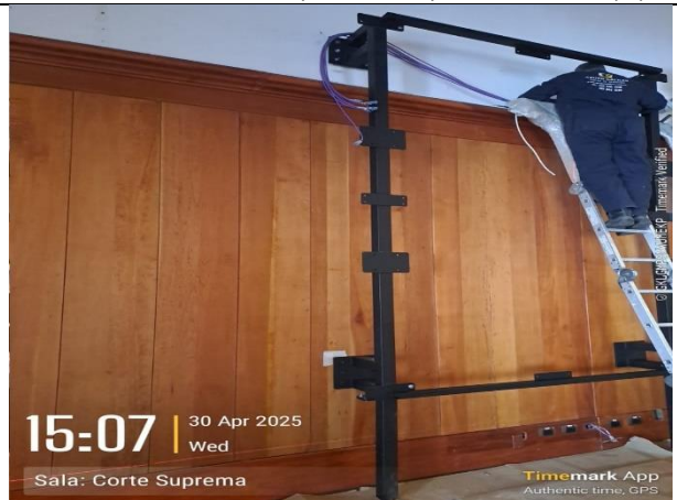
12. instalación soporte de pantalla 5x3
