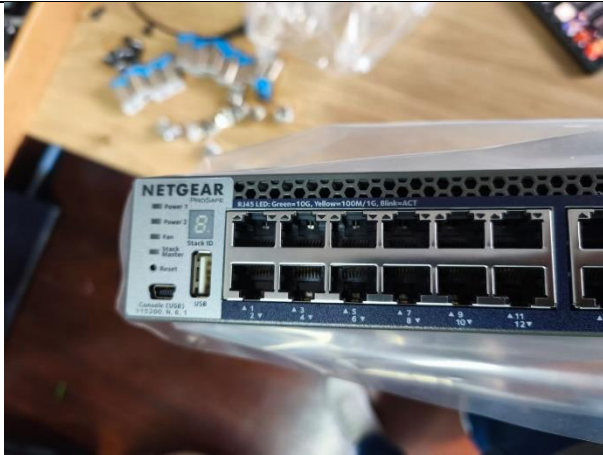
29. instalación equipos en rack
