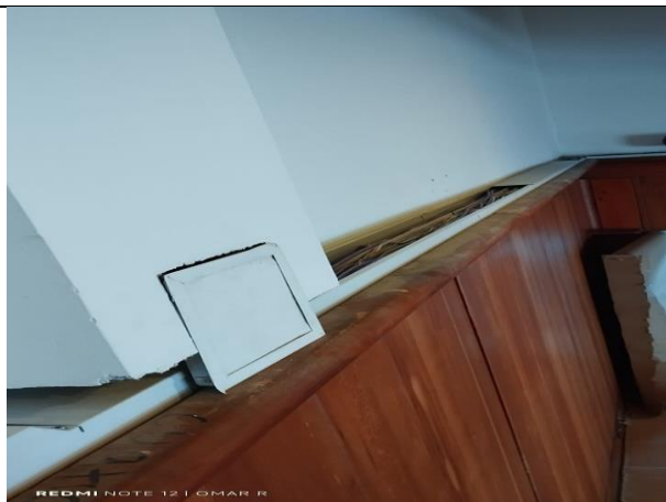
5. desmonte tapas canaletas CS
