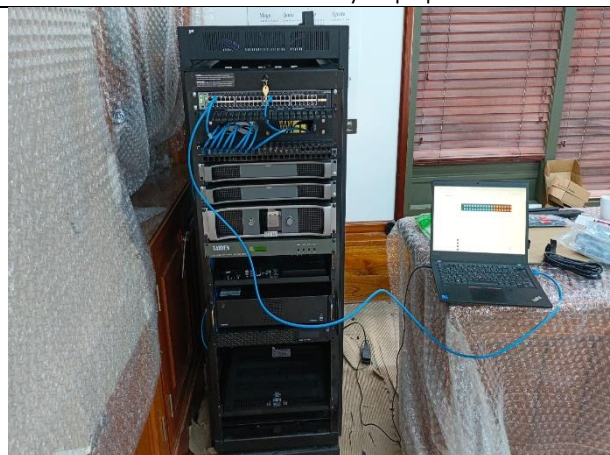
17. instalación de rack y equipos en rack3
