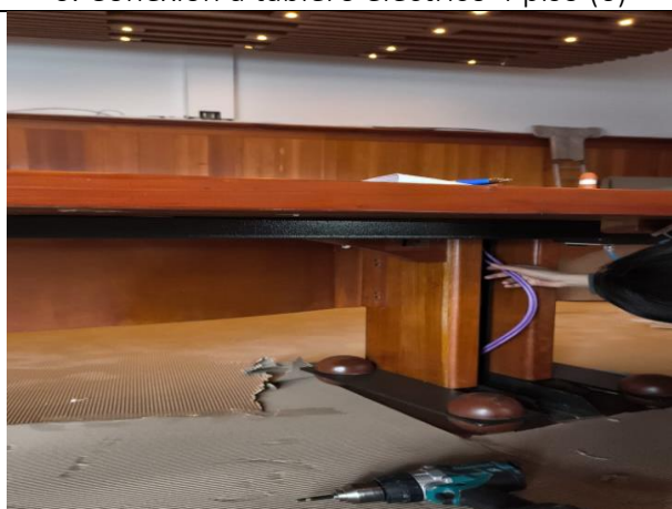
8. desmonte de troqueles
