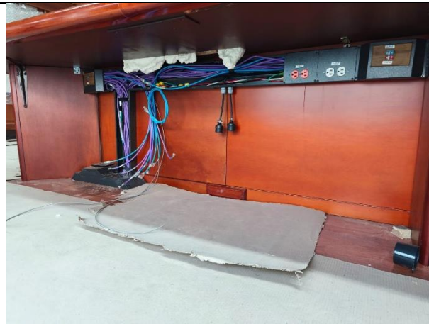
4. cableado para pantallas y nameplate (3)
