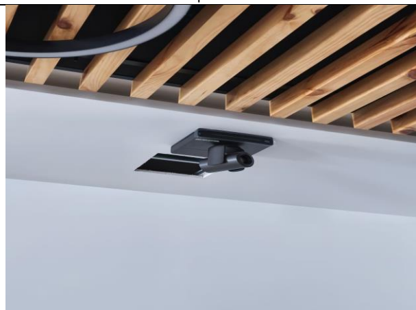
13. Instalación de cámaras (3)
