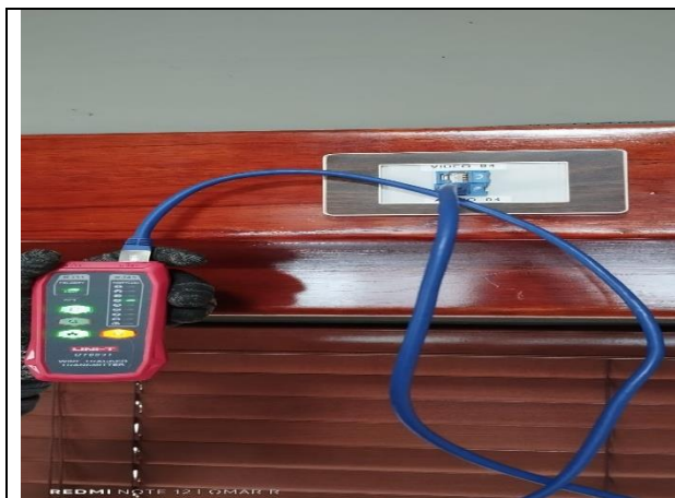
1. Identificación de puntos de red en muros
