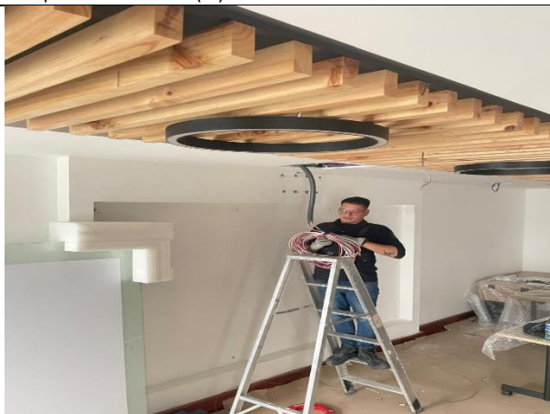
10. instalación acometida eléctrica para pantalla 163
