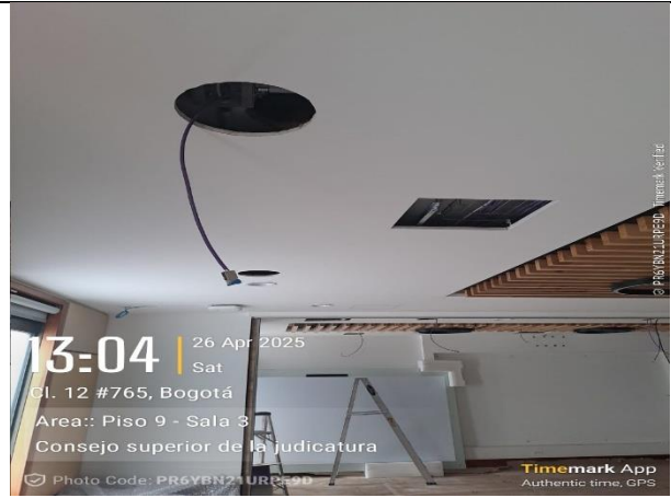
16. instalación de Infraestructura de datos (8)
