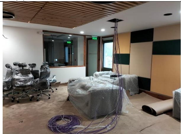
18. instalación de Infraestructura de datos
