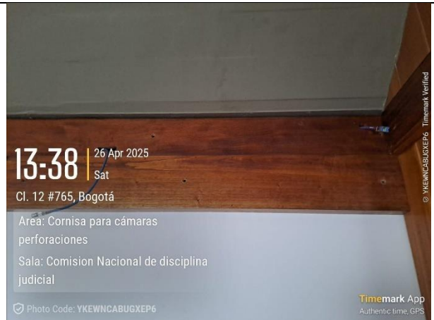
8. Perforaciones para Cámara
