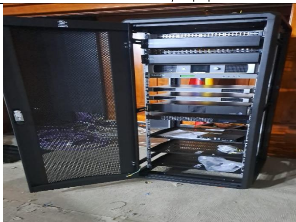
17. instalación equipos en rack1
