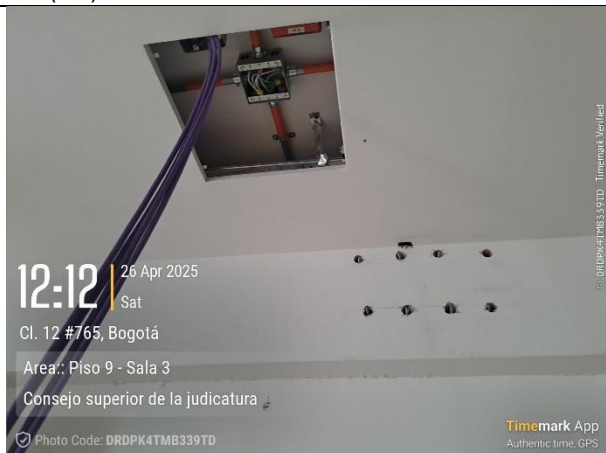
8. instalación de Infraestructura de datos (12)
