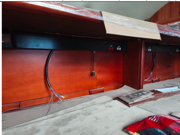
7. cableado para pantallas y nameplate (6)
