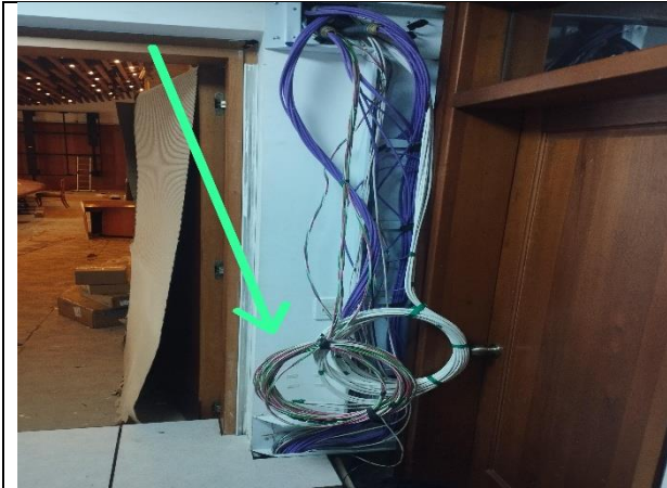
27. Tendido de circuitos eléctricos nuevos2
