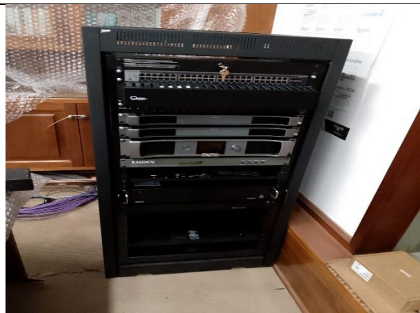
15. instalación de rack y equipos en rack
