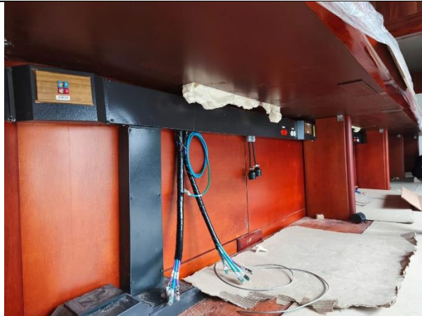
5. cableado para pantallas y nameplate (4)
