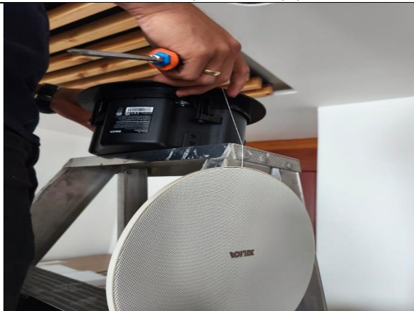
26. Instalación de parlantes (7)
