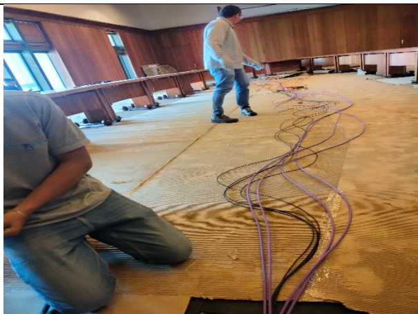
24. retiró de cableado
