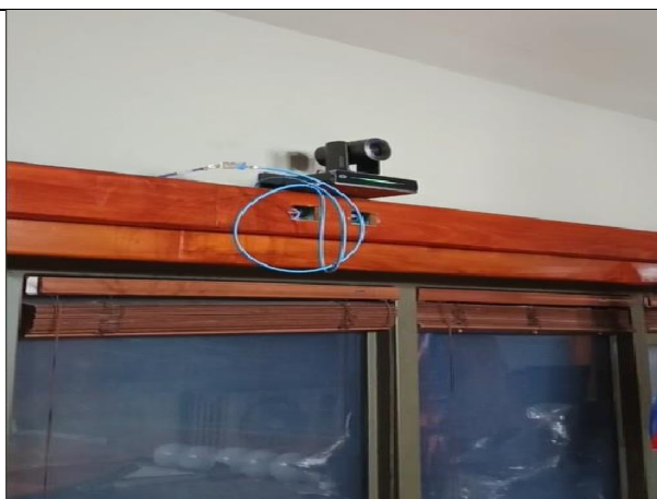
20. instalación y conexión cámaras 2
