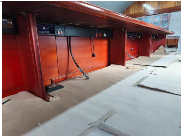
3. cableado para pantallas y nameplate (2)
