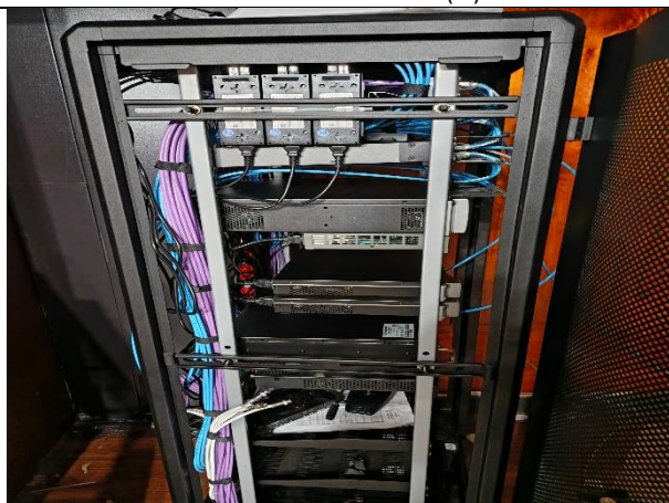
15. Instalación de rack y equipos en rack
