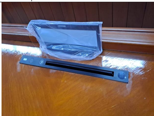
14. instalación de pantallas retractiles2
