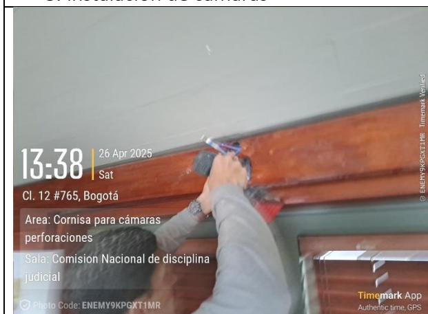
5. Perforaciones para Cámara
