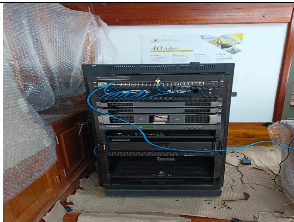
16. instalación de rack y equipos en rack2
