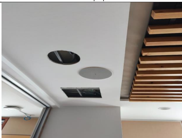
22. Instalación de parlantes (3)
