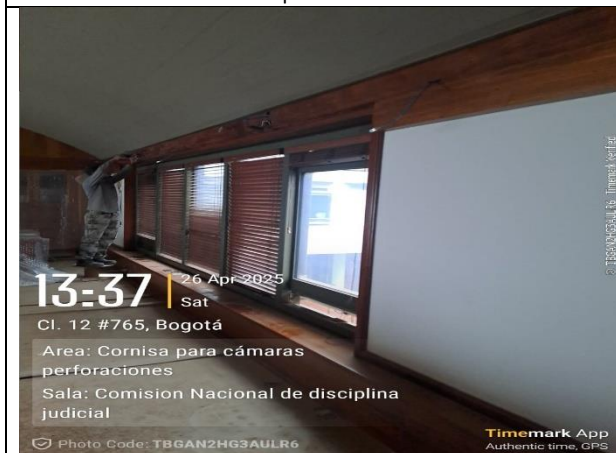
9. Perforaciones para Cámara
