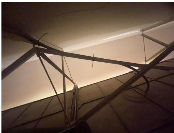
14. cableado en techo (3)
