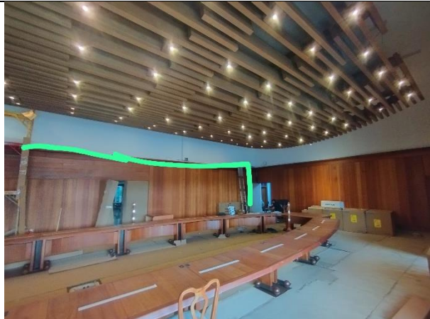
28. Tendido de circuitos eléctricos nuevos3
