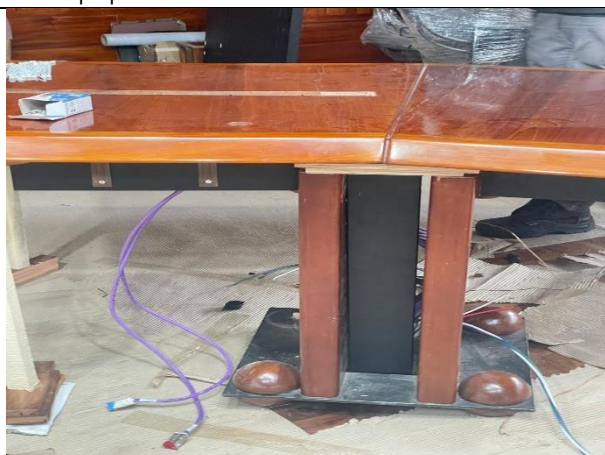
9. Instalación de canaleta (3)
