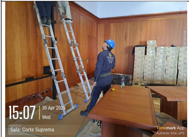
11. instalación soporte de pantalla 5x3 (3)
