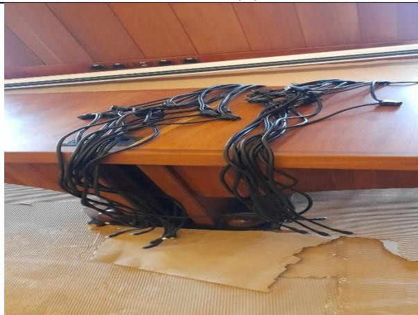
18. desmonte de cables de micrófonos anteriores
