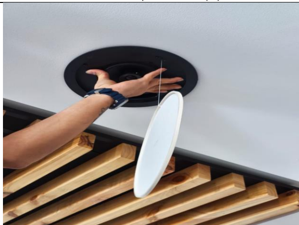
27. Instalación de parlantes
