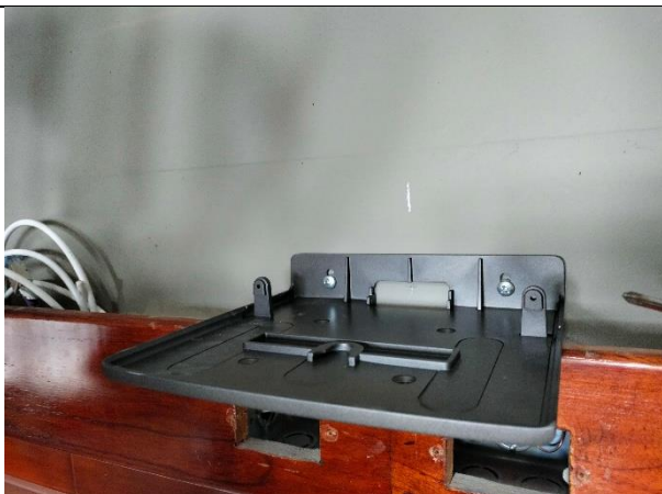
9. instalación de cámaras
