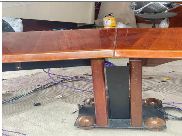
13. Instalación de canaleta (7)
