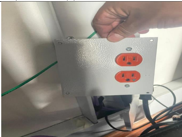
7. instalación acometida eléctrica para pantalla 163 (7)
