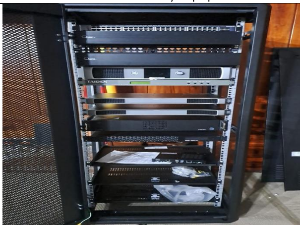
18. instalación equipos en rack2
