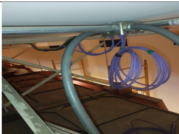
27. instalación cableado audio 1
