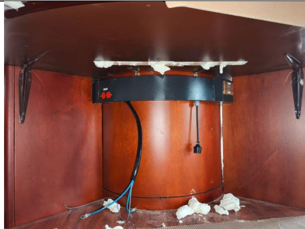
6. cableado para pantallas y nameplate (5)
