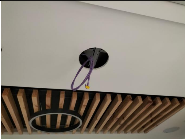
9. instalación de Infraestructura de datos (13)
