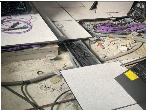
16. Instalación acometida eléctrica pantalla 5x3 (5)
