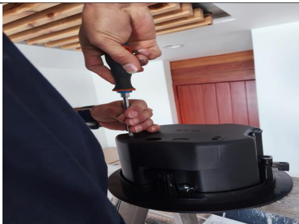
24. Instalación de parlantes (5)
