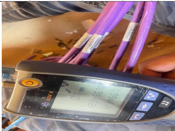
31. prueba y marquillado de puntos (5)
