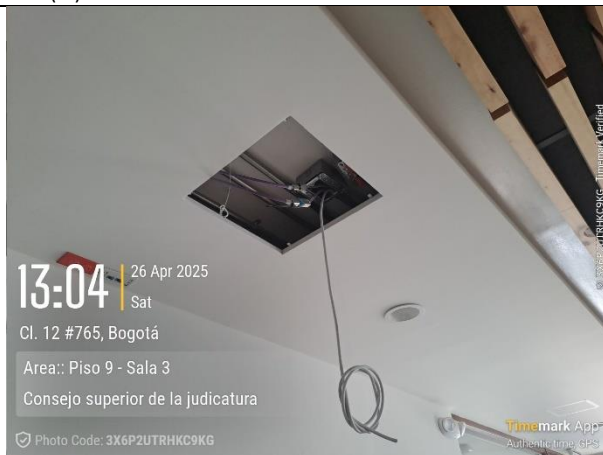
14. instalación de Infraestructura de datos (6)
