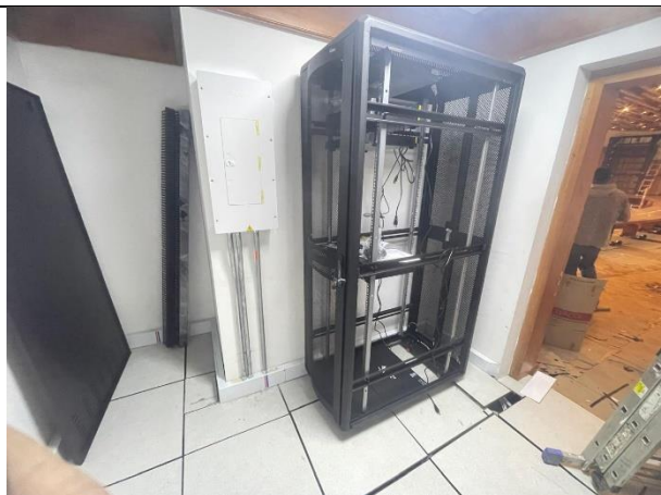
25. Instalación tablero eléctrico
