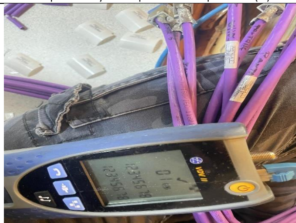
35. prueba y marquillado de puntos
