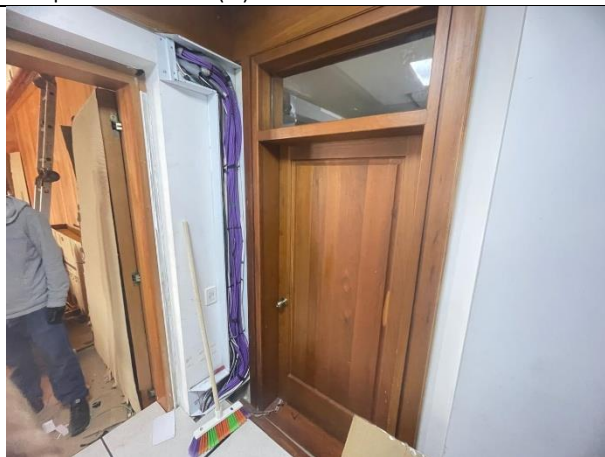
19. instalación acometida eléctrica pantalla 5x3
