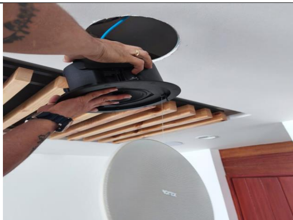
23. Instalación de parlantes (4)
