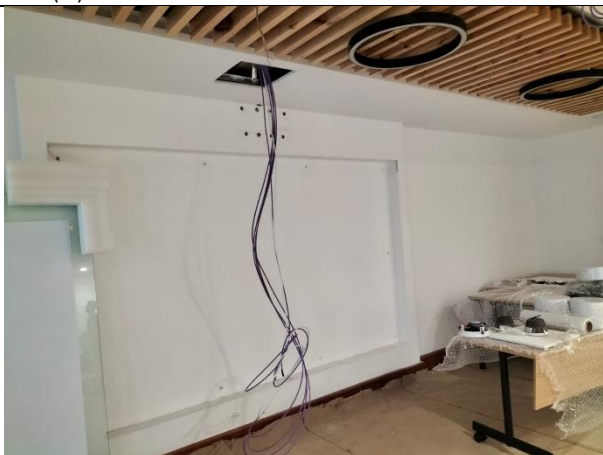
13. instalación de Infraestructura de datos (5)
