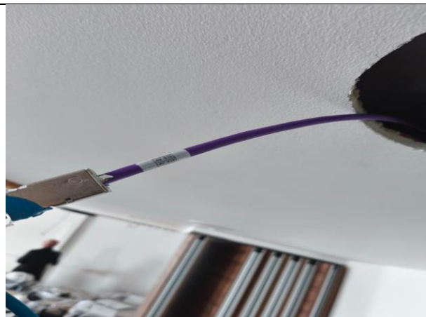
11. instalación de parlantes en sala
