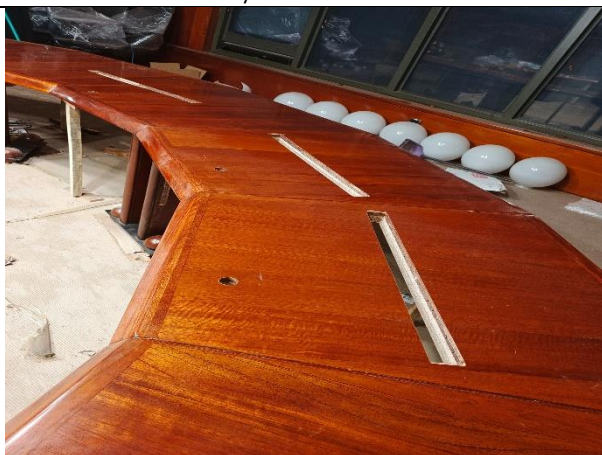
22. perforación de mesas para equipos
