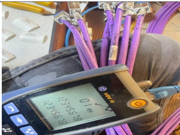
28. prueba y marquillado de puntos (2)
