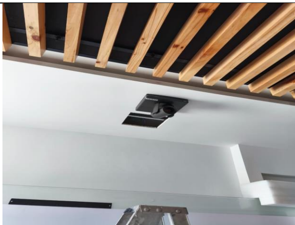
18. Instalación de cámaras (8)
