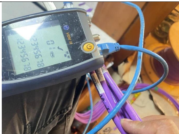
34. prueba y marquillado de puntos (8)
