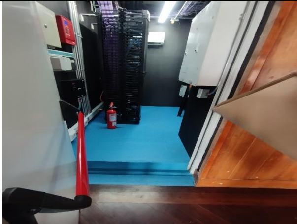
5. instalación acometida eléctrica para pantalla 163 (5)
