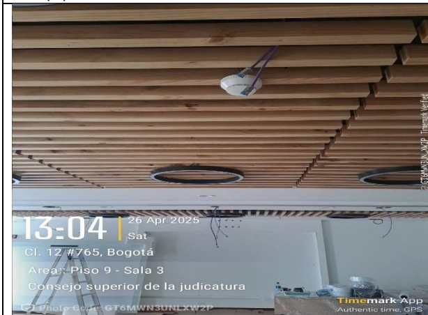
17. instalación de Infraestructura de datos (9)
