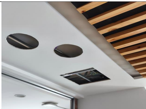
21. Instalación de parlantes (2)
