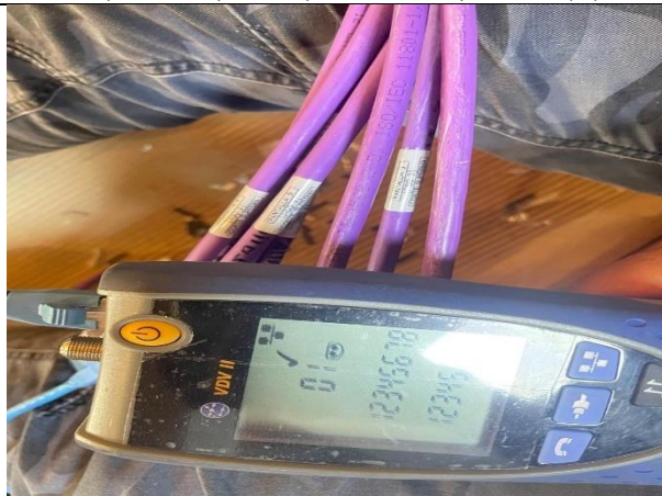
30. prueba y marquillado de puntos (4)
