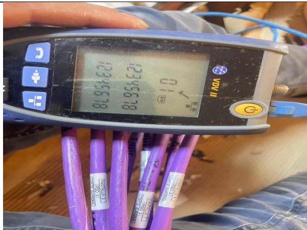
29. prueba y marquillado de puntos (3)
