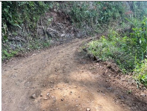
PR 06+900 Estado de la vía
