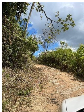
PR 10+100 Estado de la vía
