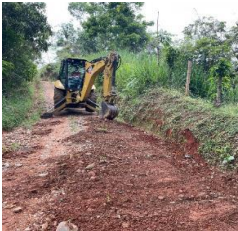
Excavación para conformacion de la via
