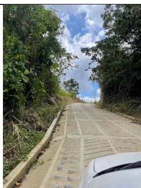
PR 12+000 Tramo de placa huella
