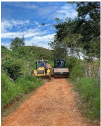
Excavación y compactación para conformacion de la via
