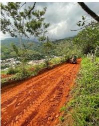
Excavación para conformacion de la via
