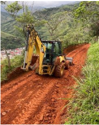
Excavación para conformacion de la via
