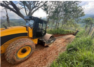
Excavación y compactación para conformacion de la via
