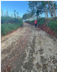
Excavación y compactación para conformacion de la via
