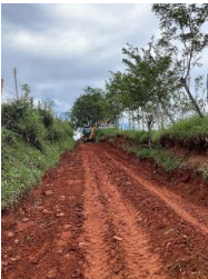
Excavación para conformacion de la via
