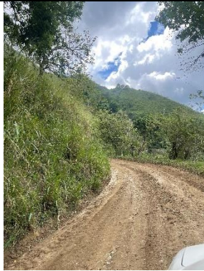
PR 05+850 Estado de la vía
