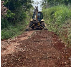
Excavación para conformacion de la via
