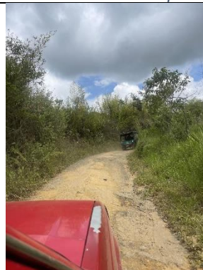
PR 00+700 Estado de la vía
