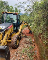
Excavación para conformacion de la via
