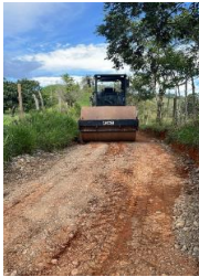
Excavación y compactación para conformacion de la via
