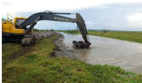
LIMPIEZA CAÑO PORVENIR K2+460 A K2+400
