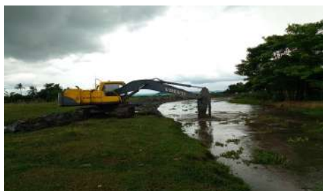
LIMPIEZA CAÑO PORVENIR K1+450 A K1+400
