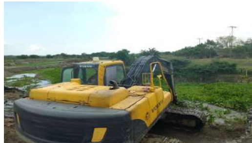
LIMPIEZA CAÑO VILLA ROSA K0+940 A K1+000
