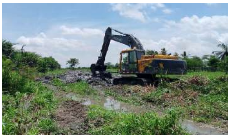
LIMPIEZA CAÑO PORVENIR K2+400 A K2+340
