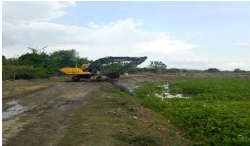
LIMPIEZA CAÑO VILLA ROSA K0+880 A K0+940
