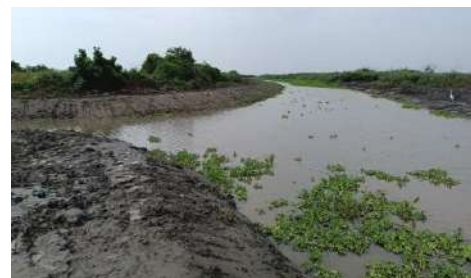
LIMPIEZA DE CAÑO VILLA ROSA
