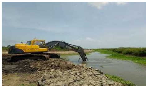
LIMPIEZA CAÑO VILLA ROSA K1+130 A K1+220
