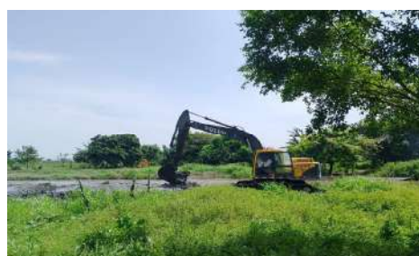
LIMPIEZA CAÑO PORVENIR K1+900 A K1+820
