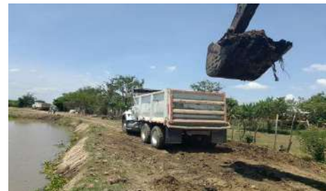
RETIRO DE MATERIAL DE SEDIMENTOS
