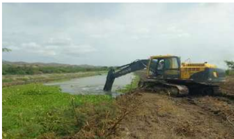
LIMPIEZA CAÑO VILLA ROSA K1+220 A K1+280
