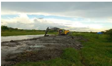
LIMPIEZA CAÑO PORVENIR K2+520 A K2+460
