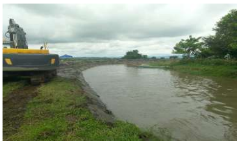
LIMPIEZA CAÑO PORVENIR K1+620 A K1+550
