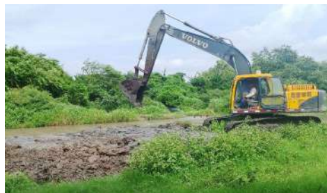
LIMPIEZA CAÑO PORVENIR K2+200 A K2+100
