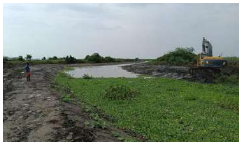
LIMPIEZA CAÑO VILLA ROSA K1+280 A K1+340
