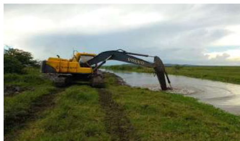
LIMPIEZA CAÑO PORVENIR K2+600 A K2+520
