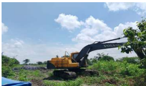
LIMPIEZA CAÑO PORVENIR K2+280 A K2+200
