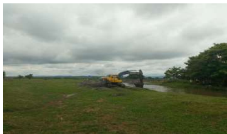
LIMPIEZA CAÑO PORVENIR K1+680 A K1+620
