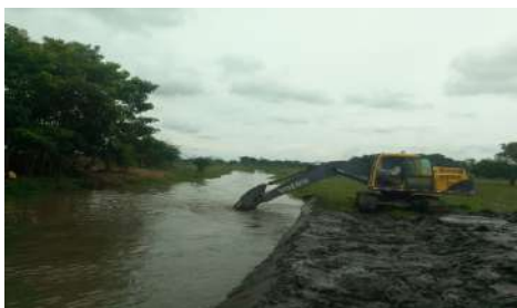
LIMPIEZA CAÑO PORVENIR K1+550 A K1+450
