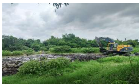
LIMPIEZA CAÑO PORVENIR K1+960 A K1+900
