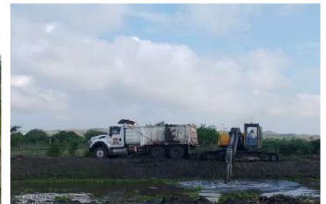
LIMPIEZA CAÑO VILLA ROSA K1+000 A K1+060
