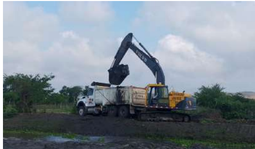
LIMPIEZA CAÑO VILLA ROSA K1+060 A K1+100
