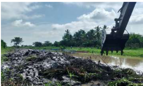
LIMPIEZA CAÑO PORVENIR K2+340 A K2+280
