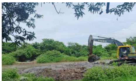
LIMPIEZA CAÑO PORVENIR K2+100 A K2+020
