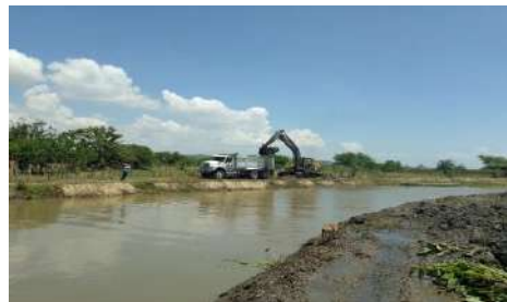
RETIRO DE MATERIAL DE SEDIMENTOS
