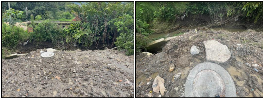
Fotografía 12. Sector Hospital - Requerimiento 5
