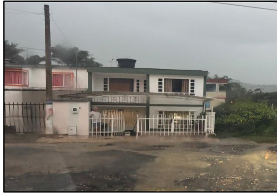
Fotografía 8. Sector La Carolina - Requerimiento 1
