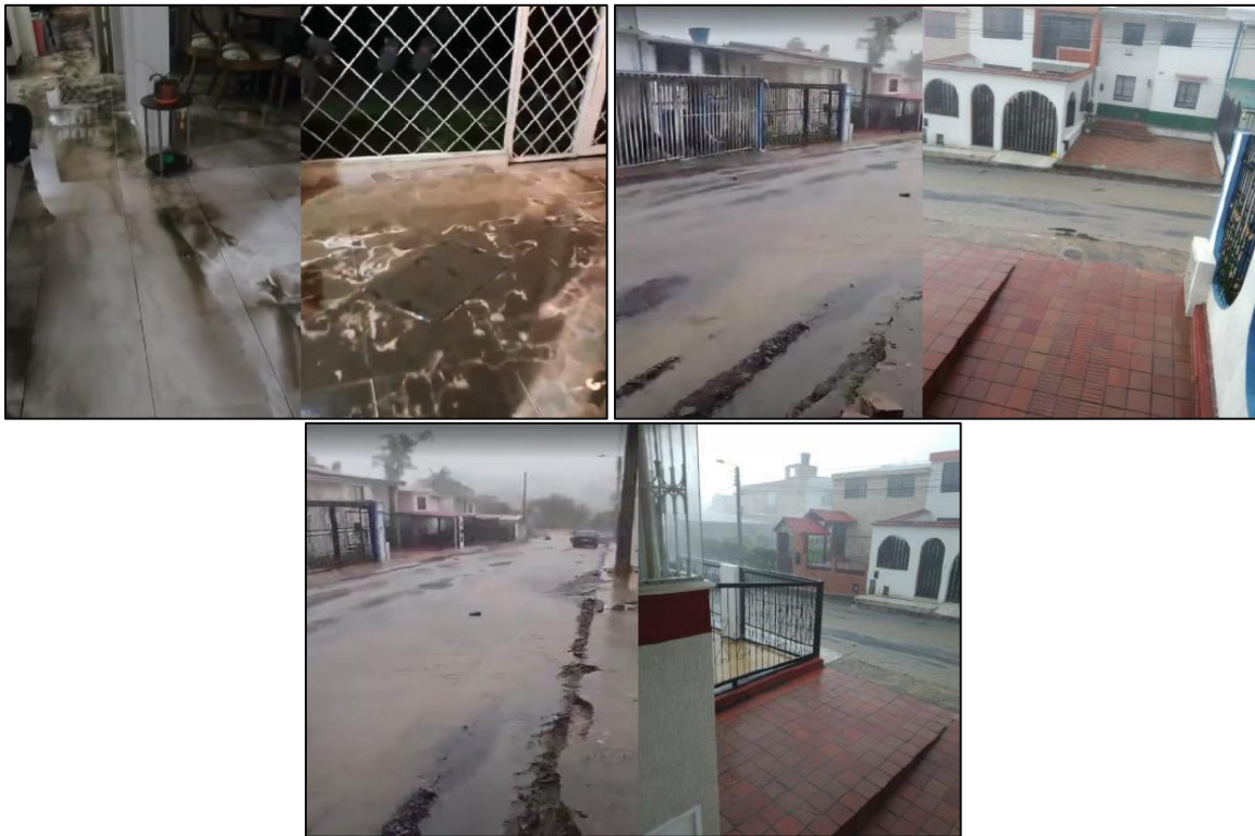
Fotografía 10. Sector La Carolina - Requerimiento 2
