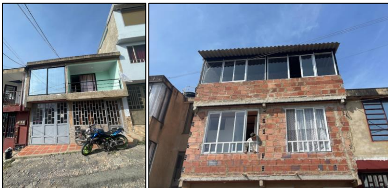
Fotografía 7. Viviendas Sector Hospital
