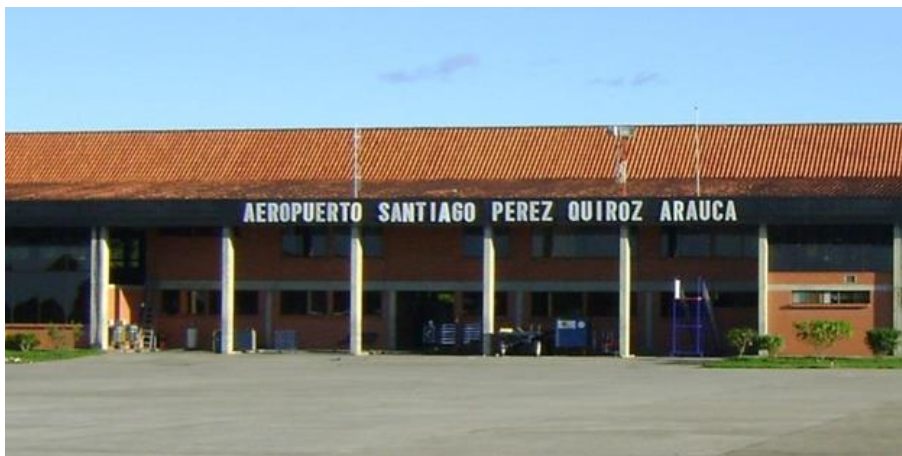
Imagen 3.3. Terminal del Aeropuerto SKUC.
