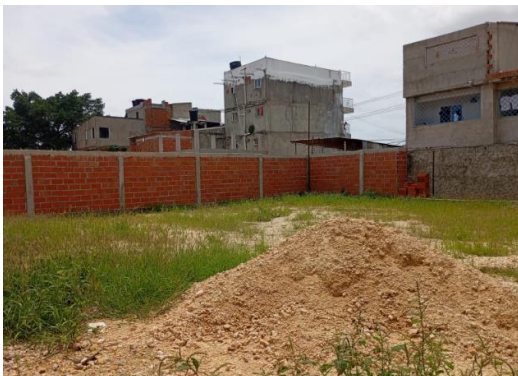
PREDIO DONDE SE CONSTRUYE MURO PERIEMETRAL BARRO VILLA ESTRELLA.
