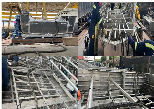
Foto No. 63 a 66 – bote 3 espejo, refuerzos de fondo, forro cuadernas y vagras
