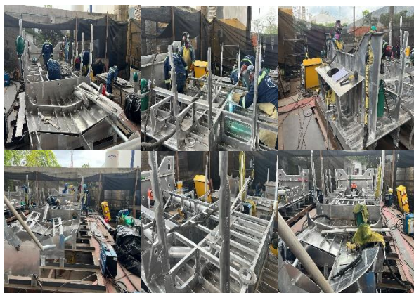
Foto No. 41 a 46 – bote 3 refuerzos, cuadernas vagras tuberías
