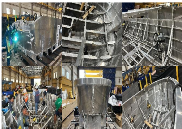
Foto No. 57 a 62 – bote 2 espejo, refuerzos de fondo, forro cuadernas y vagras
