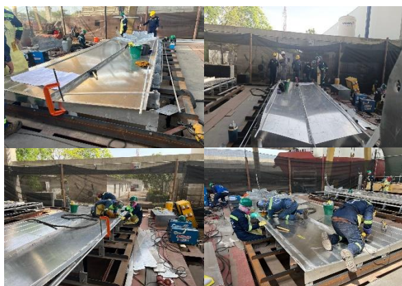
Foto No. 17 a 20 – bote 3 láminas de fondo quilla y barras
