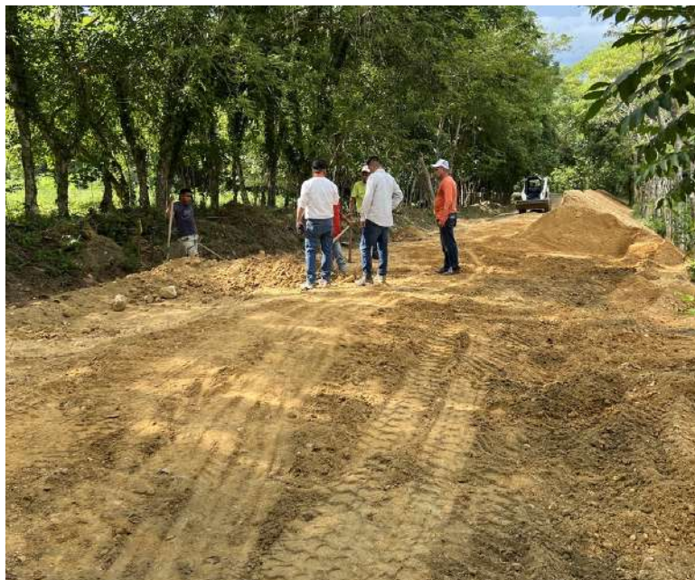
Visita de inspección de material de subbase.
