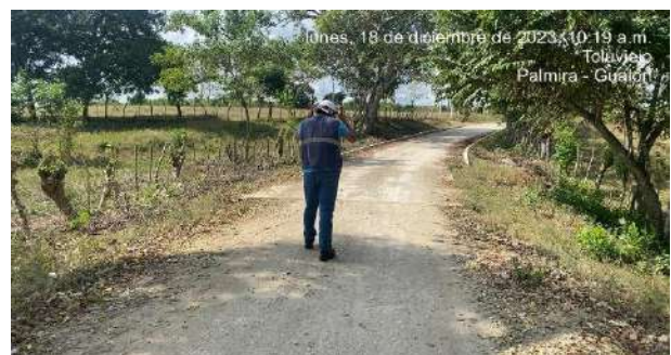
Recorrido de obra Palmira- Gualón
