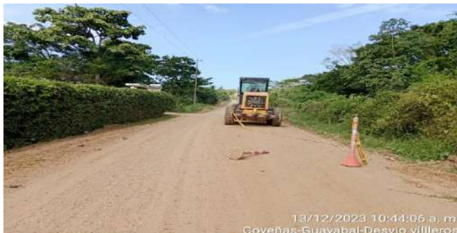
Recorrido esta de obra Coveñas, tramo vía Parcelas de Algarrobo
