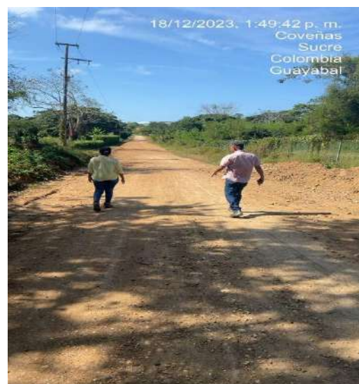
Recorrido de obra Coveñas-Guayabal
