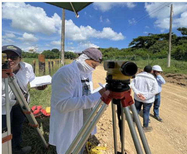
Chequeo Subbase via Guayabal – Coveñas.
