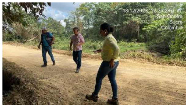
Recorrido de obra San Onofre
