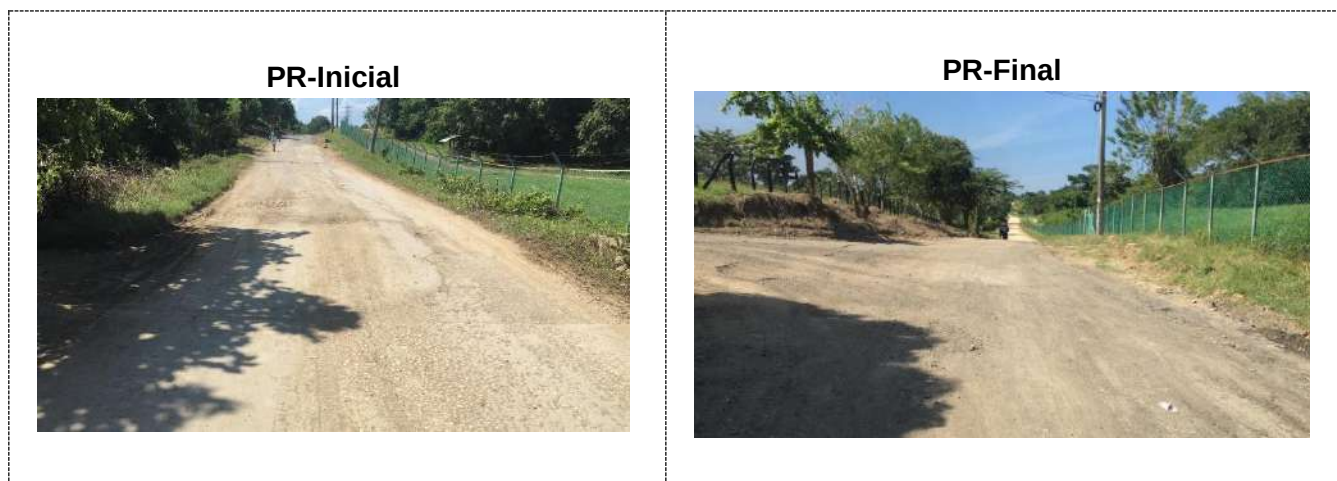
Ilustración 2-7 PR – Inicial y Final – Vía Guayabal – Parcelas de Algarrobo y desvío hacia el sector de Represa de villeros
