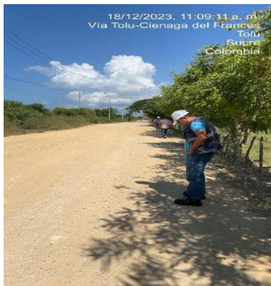
Recorrido de obra Tolú-Frances
