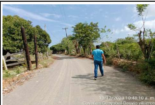
Supervisión estado de vías intervenidas por motivo de señalización.
