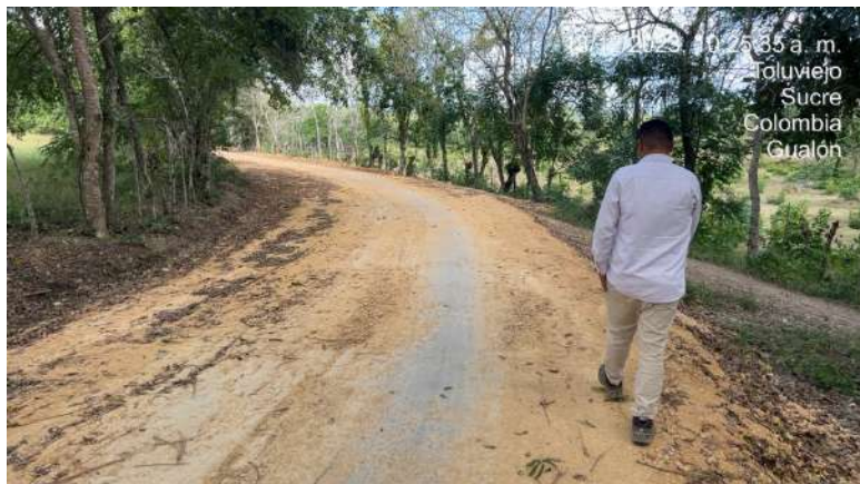
Chequeo material de subbase entre K1+730 hacia mayores Gualón – La Palmira
