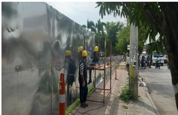
Ilustración 12 . Instalación de láminas de zinc para cerramiento
