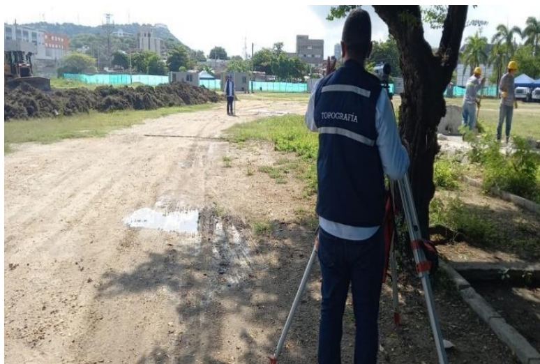
Ilustración 11. Localización y replanteo
