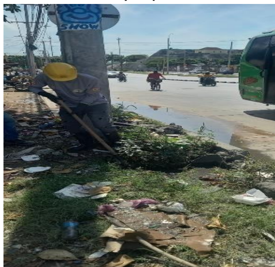
Foto 5. cerramiento y limpieza
