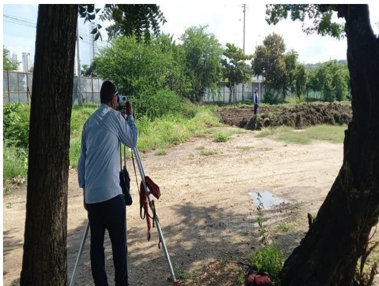
Ilustración 10 . Localización y replanteo
