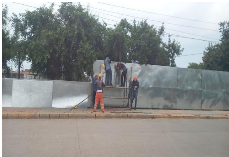
Ilustración 13. Instalación de estructura y láminas de zinc para el cerramiento
