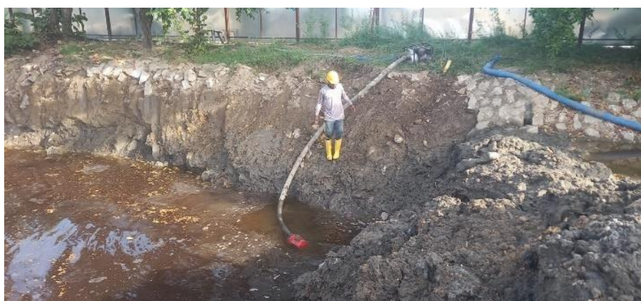
Ilustración 35. Manejo de aguas canal existente
