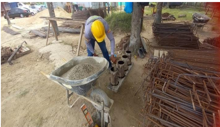
Ilustración 46. Toma de muestras concreto fondo canal perimetral.
