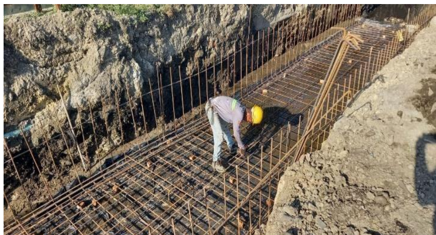
Ilustración 21. Figurado acero canal perimetral
