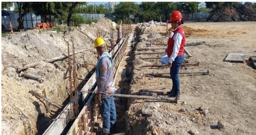
Ilustración 26. Fundida de concreto vigas de cerramiento
