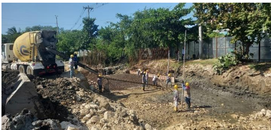
Ilustración 27. Fundida concreto ciclópeo box culvert
