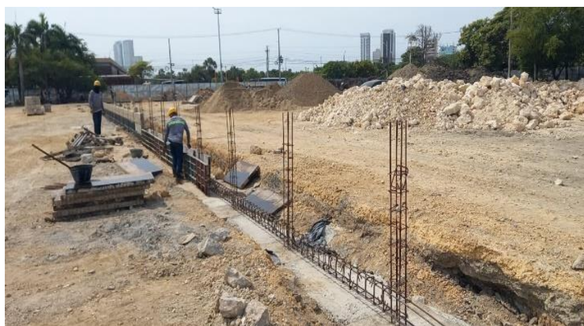
Ilustración 23. Acero refuerzo vigas, columnetas cerramiento
