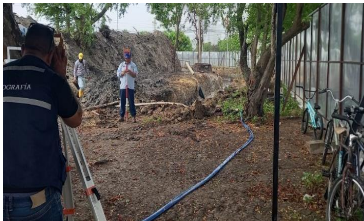
Ilustración 10. Localización y replanteo canal perimetral
