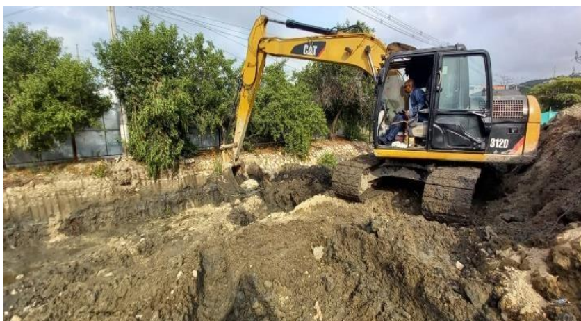
Ilustración 17. Excavación Box coulvert
