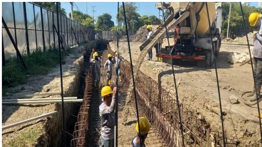
Ilustración 30. Fundida concreto 4000 psi canal perimetral
