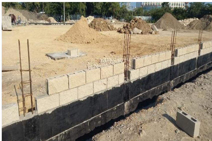
Ilustración 38. Impermeabilización muro block.
