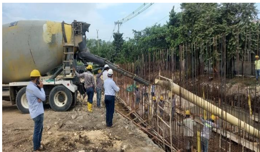
Ilustración 33. Fundida concreto 4000 psi box coulvert
