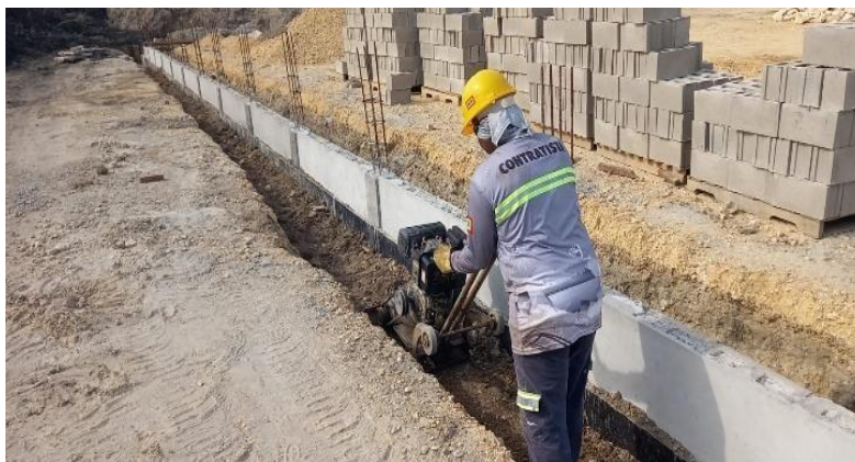
Ilustración 12. Relleno y compactación material seleccionado cerramiento cancha futbol 11
