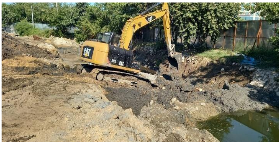
Ilustración 18. Excavación Box coulvert
