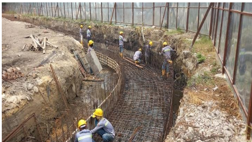
Ilustración 22. Figurado acero canal perimetral
