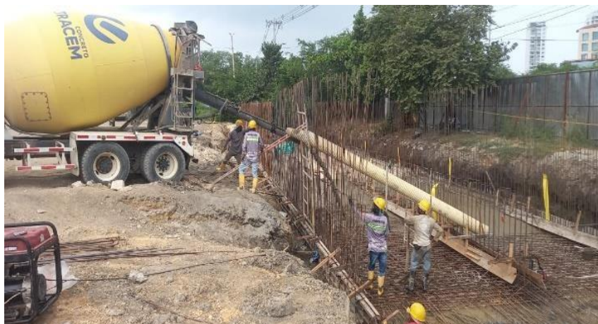
Ilustración 32. Fundida concreto 4000 psi box coulvert
