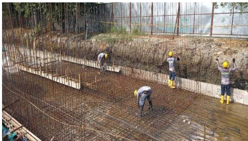
Ilustración 20. Figurado acero Box coulvert
