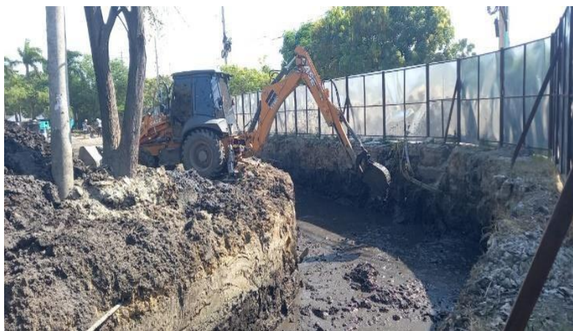
Ilustración 16. Excavación Canal perimetral
