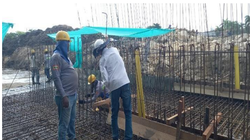
Ilustración 19. Figurado acero Box coulvert
