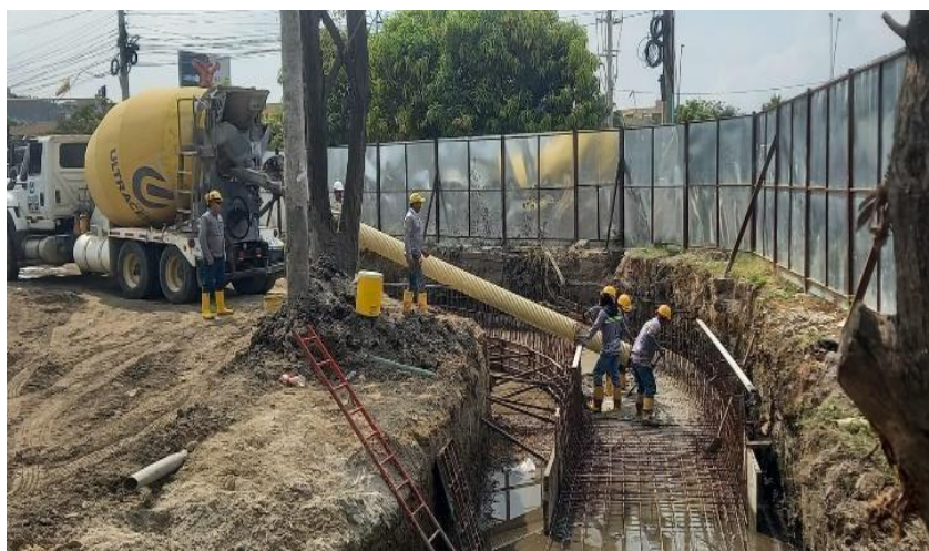
Ilustración 31. Fundida concreto 4000 psi canal perimetral
