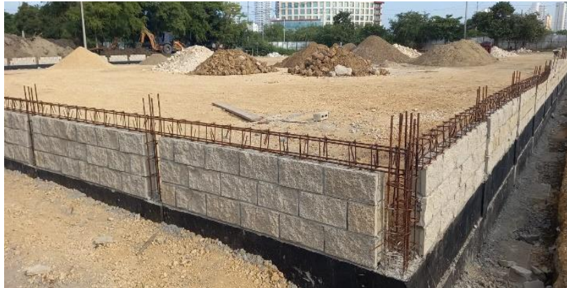
Ilustración 24. Acero refuerzo vigas confinamiento cerramiento
