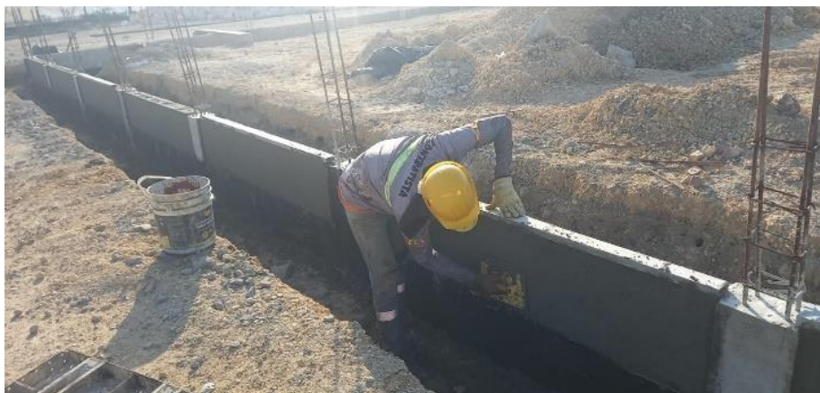
Ilustración 37. Pañete en muro block.
