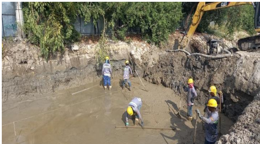
Ilustración 28. Fundida concreto ciclópeo box couvert
