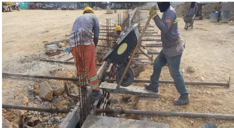
Ilustración 25. Fundida de concreto vigas, columnetas cerramiento
