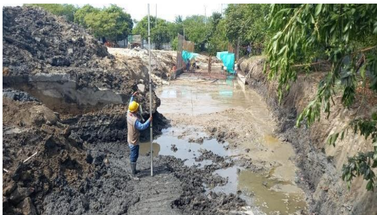
Ilustración 11. Localización y replanteo box culvert
