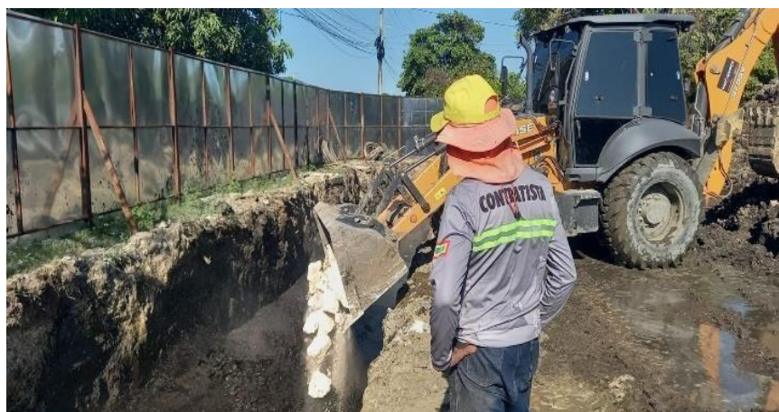
Ilustración 29. Fundida concreto ciclópeo canal perimetral
