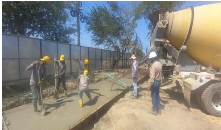
Ilustración 33. Fundida concreto 4000 psi placa superior canal perimetral
