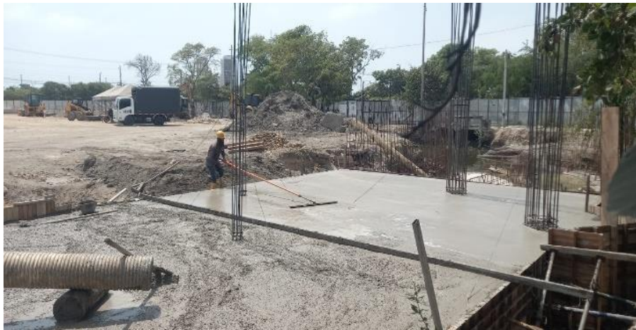
Ilustración 36. Fundida concreto 4000 psi placa superior box coulvert
