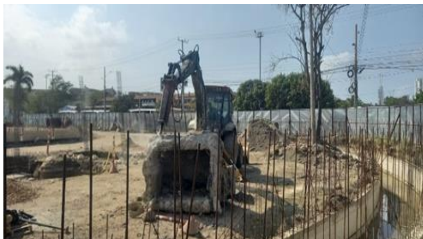
Ilustración 28. Demolición estructura de concreto
