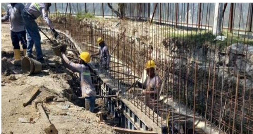
Ilustración 32. Fundida concreto 4000 psi muro canal perimetral
