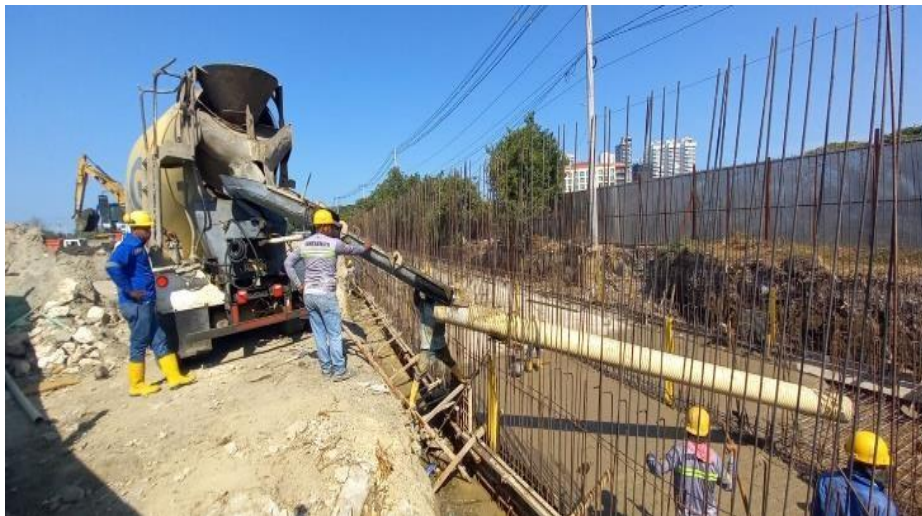
Ilustración 34. Fundida concreto 4000 psi fondo box coulvert
