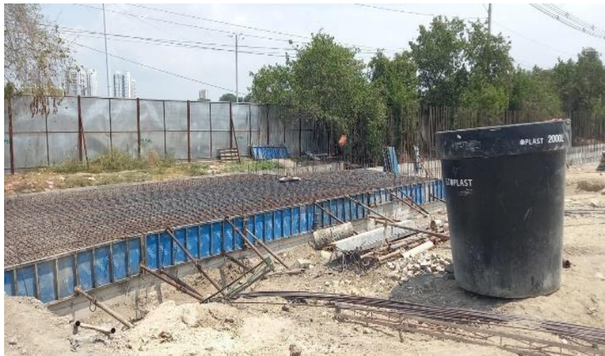
Ilustración 20. Figurado acero placa superior Box couvert
