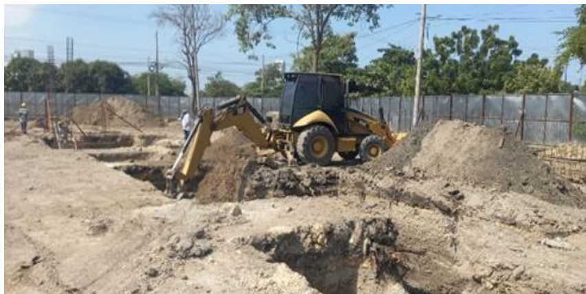
Ilustración 16. Excavación zapatas baterías de baños
