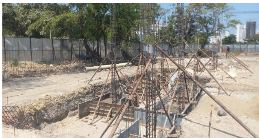
Ilustración 26. Acero refuerzo zapatas, vigas de cimentación y columnas baños
