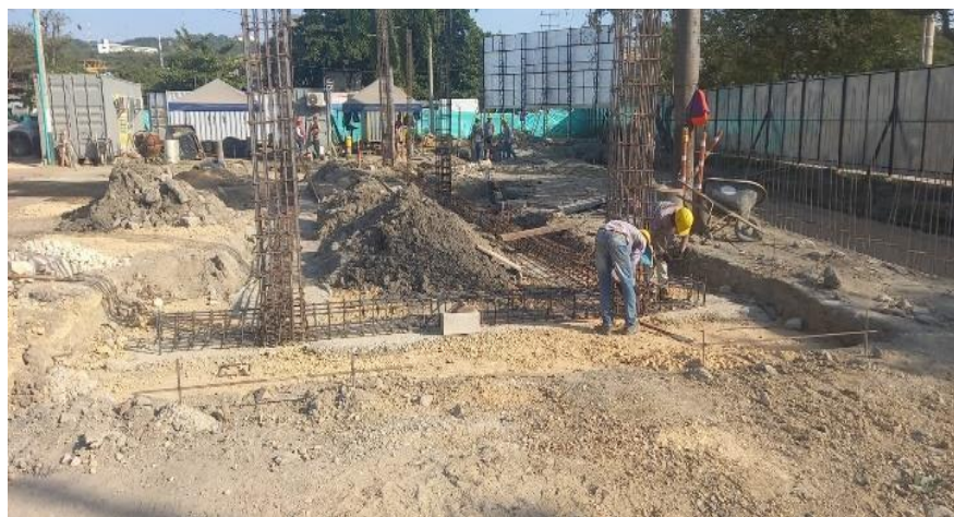
Ilustración 25. Acero refuerzo vigas de cimentación y columnas acceso principal
