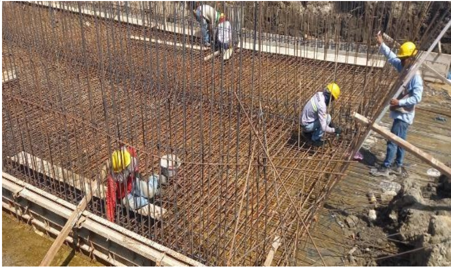
Ilustración 21. Figurado acero fondo Box coulvert
