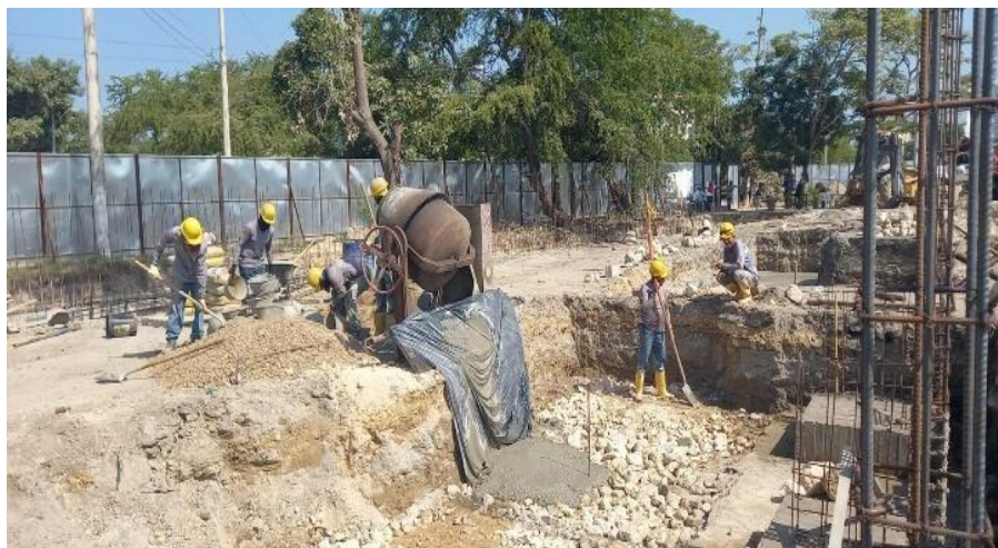
Ilustración 31. Fundida concreto ciclópeo zapatas baterías de baños
