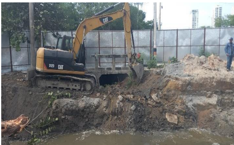
Ilustración 14. Excavación Canal principal
