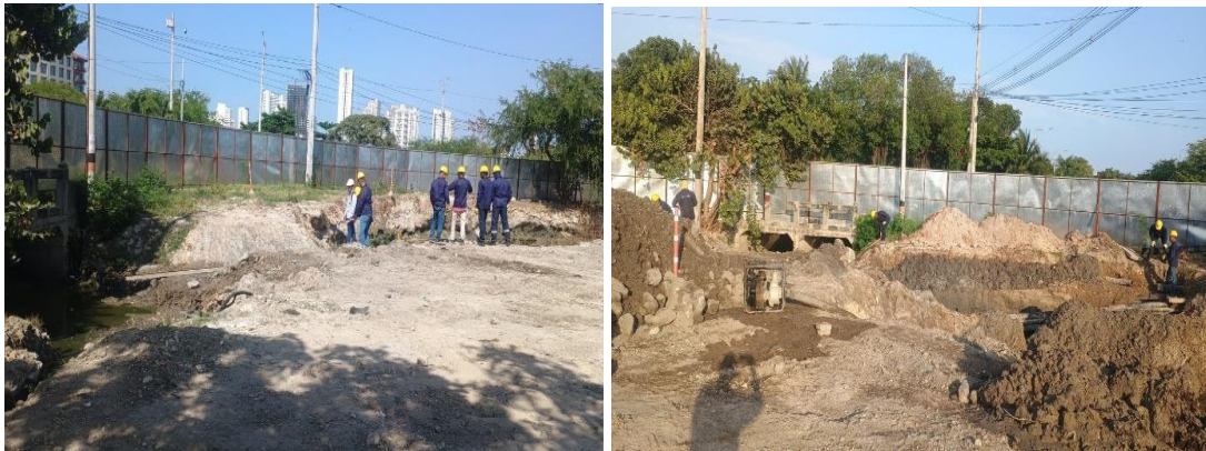
Ilustración 74. Trabajos reubicación y protección redes eléctricas.
