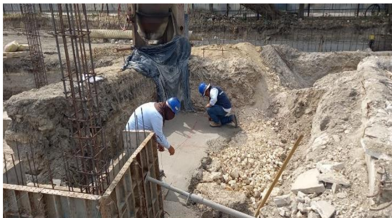
Ilustración 12. Localización y replanteo cimentación baterías de baños
