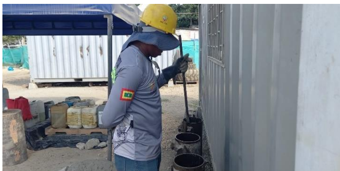
Ilustración 46. Toma de muestras concreto placa superior canal principal.
