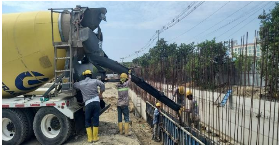
Ilustración 35. Fundida concreto 4000 psi muros box coulvert
