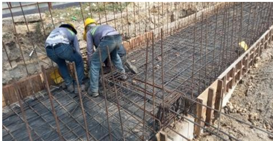
Ilustración 27. Acero vigas de cimentación acceso No 2 canal perimetral
