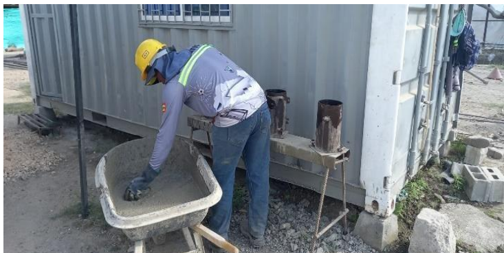
Ilustración 45. Toma de muestras concreto de vigas acceso principal.
