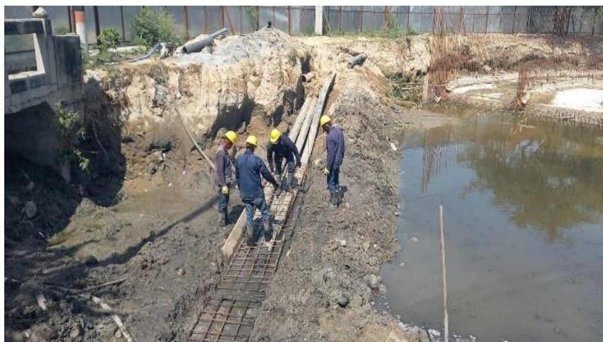
Ilustración 43. Trabajos de reubicación líneas eléctricas.
