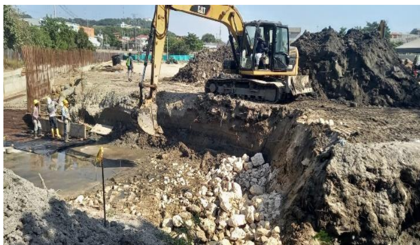
Ilustración 30. Conformación para concreto ciclópeo box coulvert
