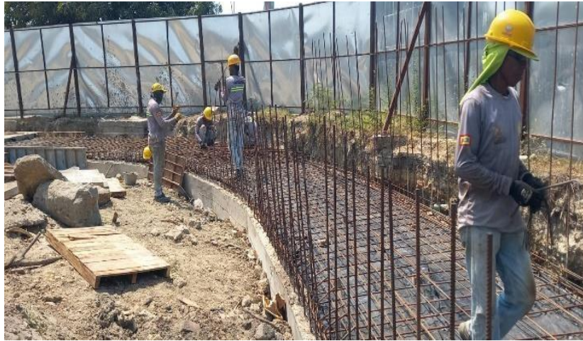
Ilustración 23. Figurado acero placa superior canal perimetral
