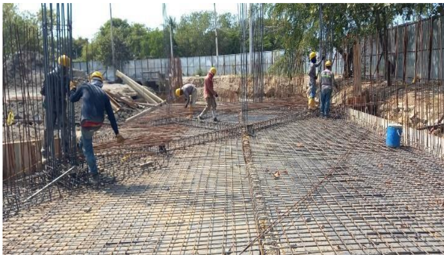
Ilustración 24. Acero refuerzo zapatas, vigas y columna acceso 2 canal principal
