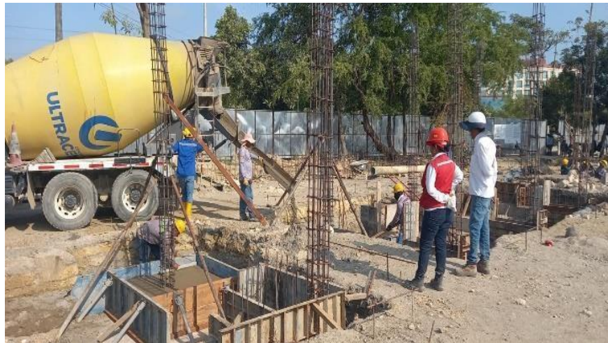
Ilustración 38 .Fundida concreto 4000 psi zapatas baterías de baños
