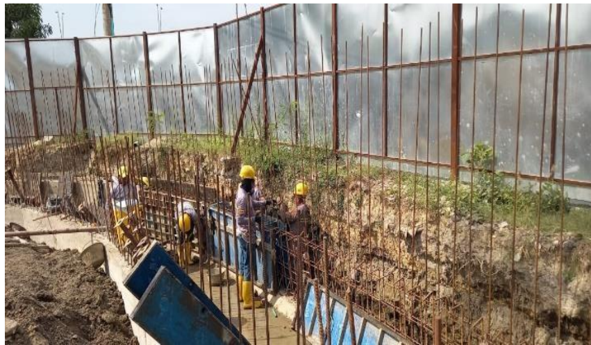
Ilustración 22. Figurado acero muro canal perimetral
