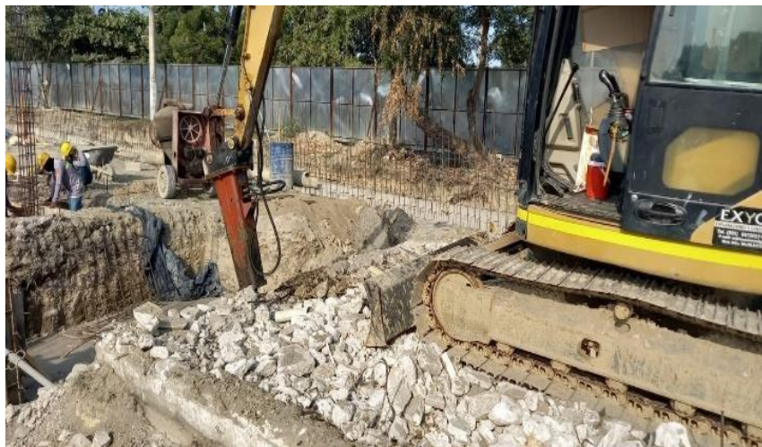
Ilustración 29. Demolición estructura de concreto
