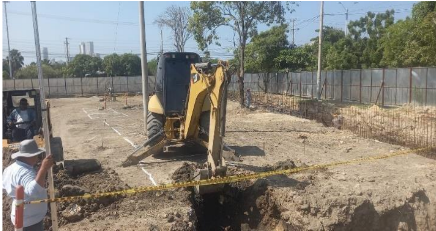
Ilustración 15. Excavación zapatas camerinos
