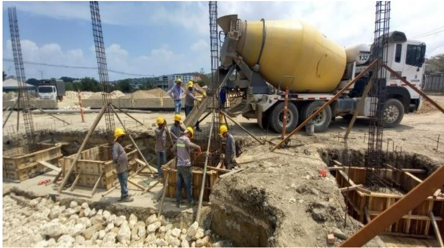
Ilustración 37. Fundida concreto 4000 psi zapatas baterías de baños
