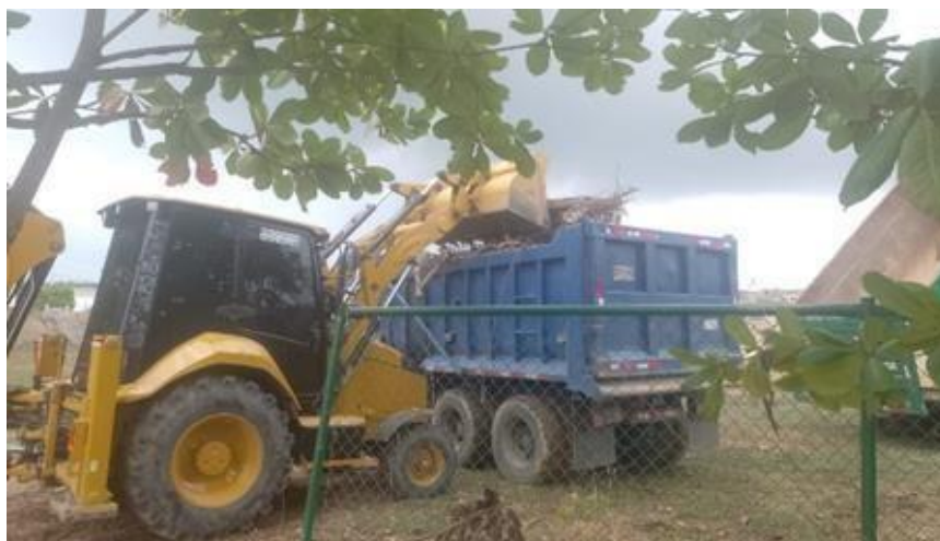
Ilustración 18. Retiro material de poda de árboles y excavaciones
