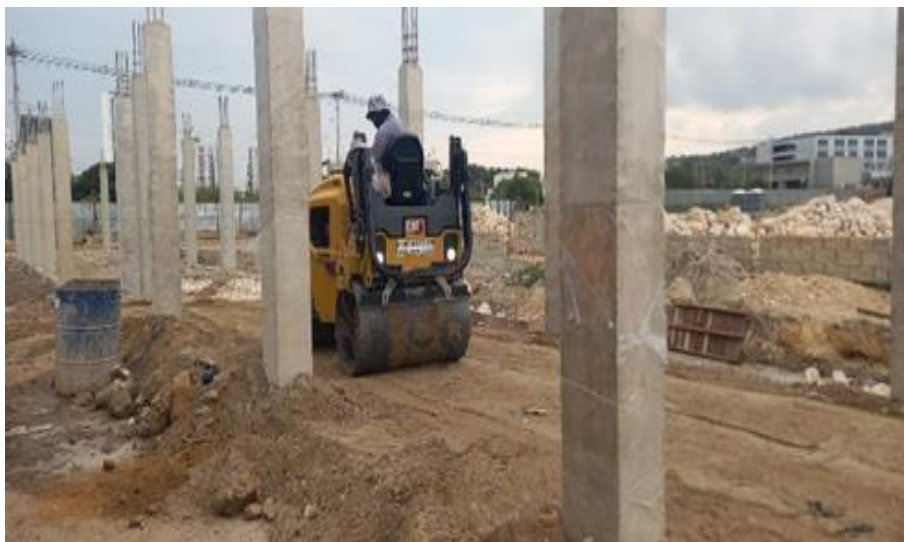
Ilustración 47. Relleno y compactación zona de baños y camerinos
