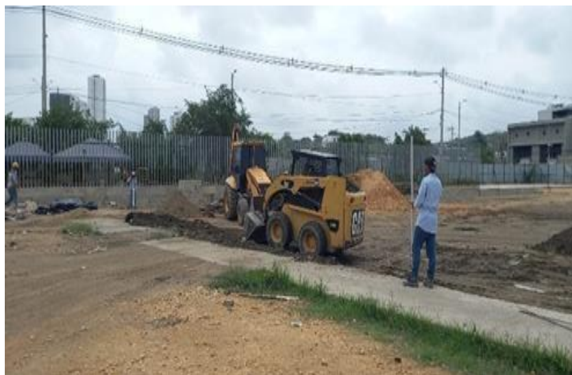
Ilustración 40. Localización y replanteo cancha futbol 9
