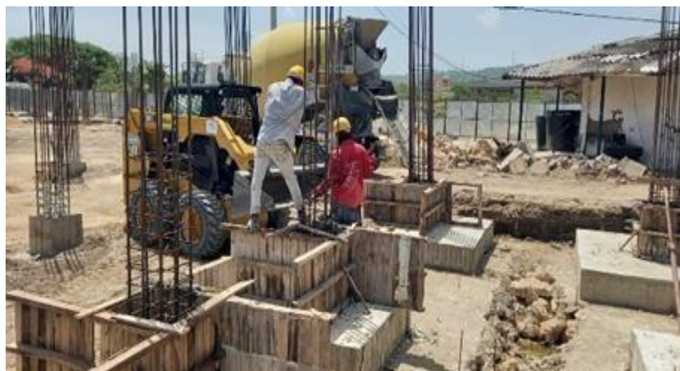
Ilustración 37. Fundida concreto 4000 psi pedestales zapatas Z10, Z11 y Z12 graderías cancha de softbol
