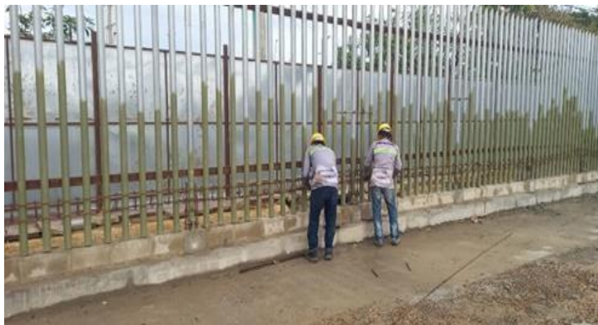
Ilustración 54. Acero refuerzo viga de confinamiento
