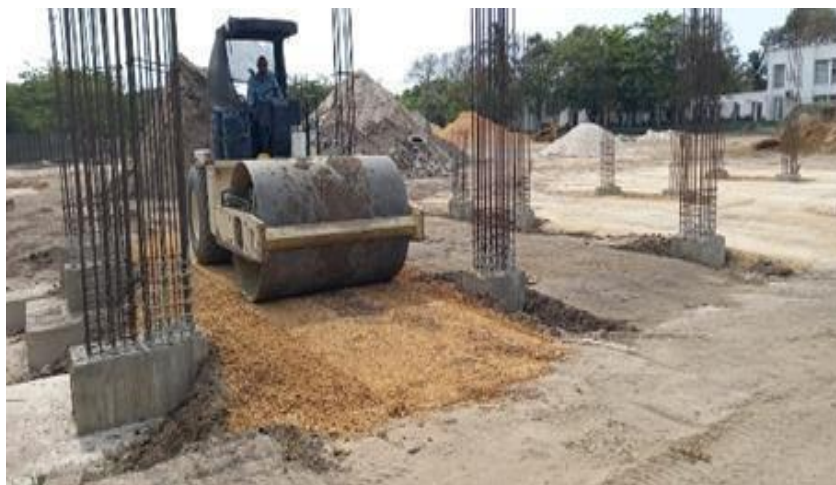
Ilustración 21. Relleno y compactación material seleccionado cancha zona de graderías.
