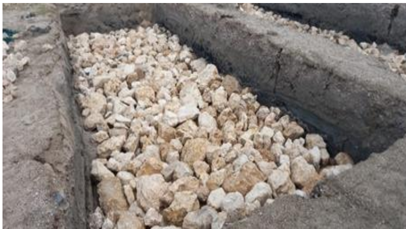
Ilustración 23. Conformación concreto ciclópeo cimentación graderías cancha de futbol
