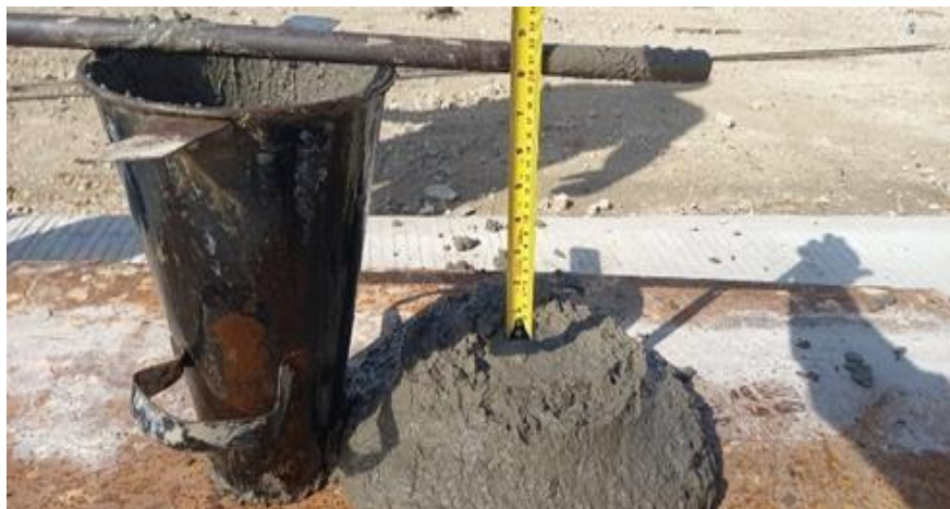
Ilustración 77. Prueba de Slump concreto placa 3er nivel acceso No 2.
