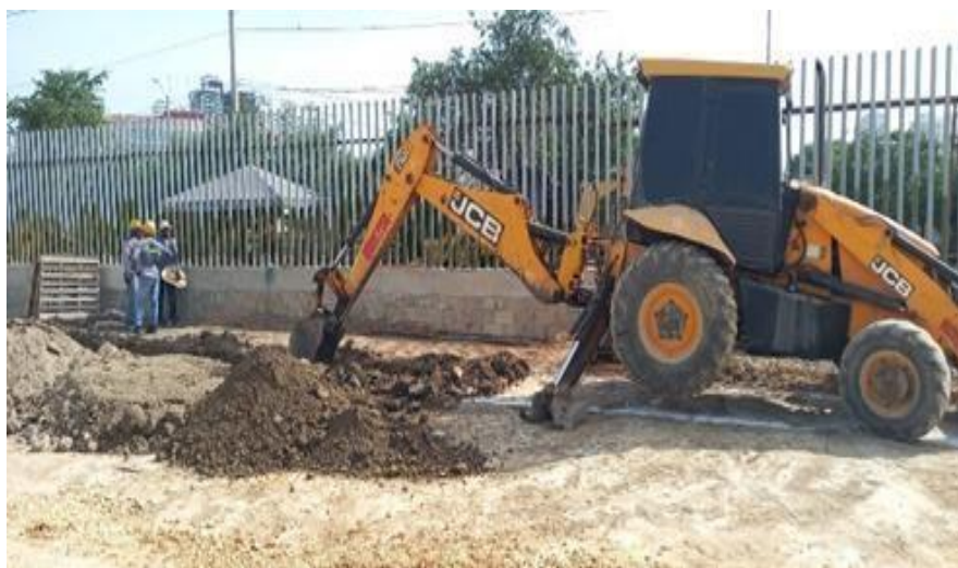
Ilustración 45. Excavación cancha futbol 9
