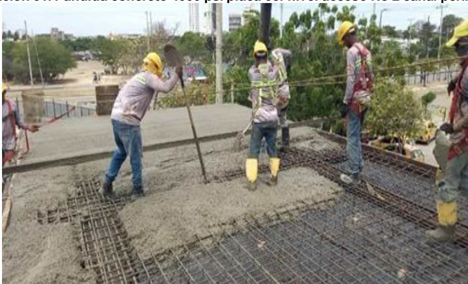
Ilustración 60. Fundida concreto 4000 psi placa 3er nivel acceso No 2 canal perimetral
