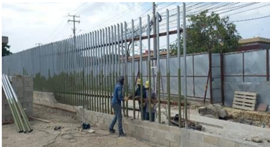
Ilustración 70. Módulos de tubería de cerramiento externo paralelo al canal perimetral
