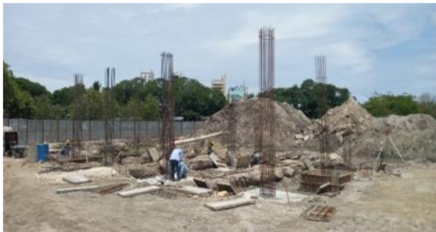
Ilustración 32. Figurado acero 60000 psi zapatas y columnas graderías cancha de softbol
