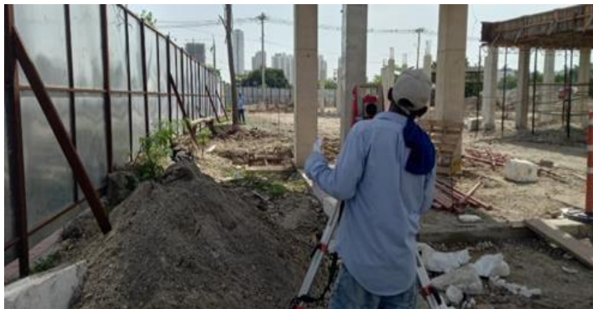
Ilustración 42. Localización y replanteo muro de cerramiento perimetral.
