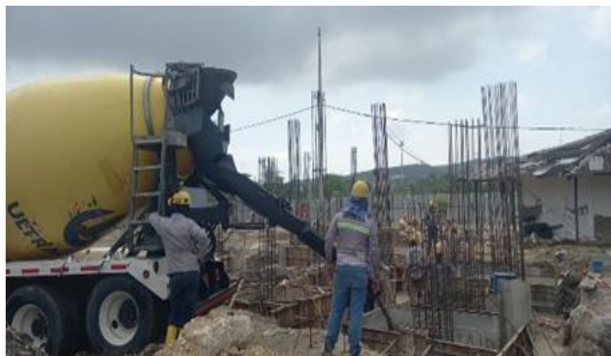
Ilustración 35. Fundida concreto 4000 psi zapatas Z10, Z11 y Z12 graderías cancha de softbol
