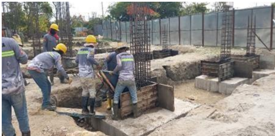
Ilustración 36. Fundida concreto 4000 psi pedestales zapatas Z10, Z11 y Z12 graderías cancha de fútbol
