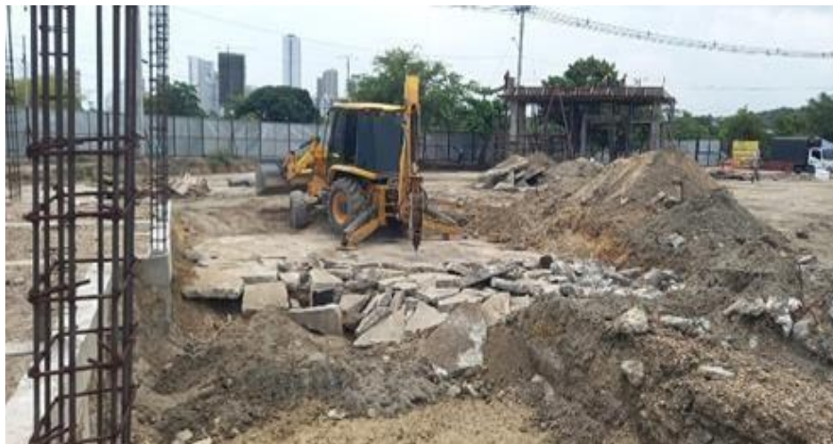
Ilustración 49. Demolición placa de concreto zona de camerinos
