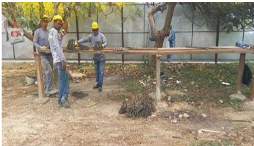
Ilustración 29. Figurado acero 60000 psi zapatas cerramiento cancha múltiple
