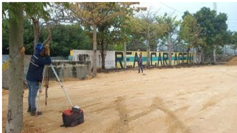
Ilustración 12 . Localización y replanteo cancha de múltiple.
