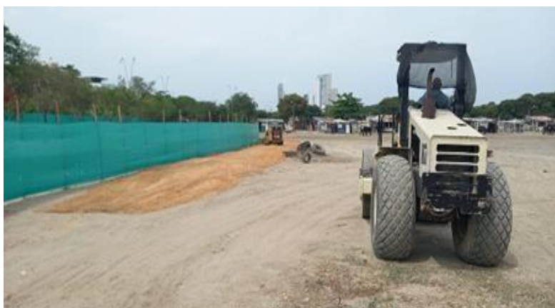
Ilustración 22. Relleno y compactación material seleccionado zona de parqueaderos.
