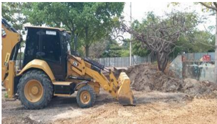
Ilustración 15. Descapote cancha múltiple.
