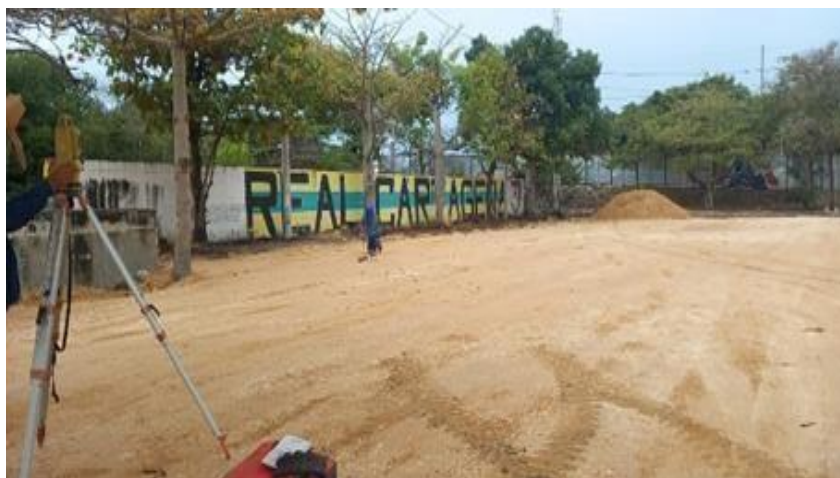
Ilustración 20. Relleno y compactación material seleccionado cancha múltiple
