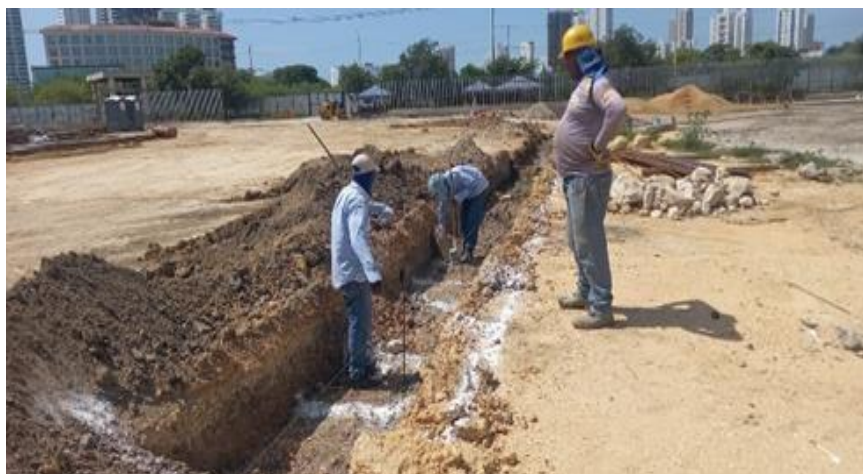
Ilustración 41. Localización y replanteo cimentación cerramiento cancha futbol 9.
