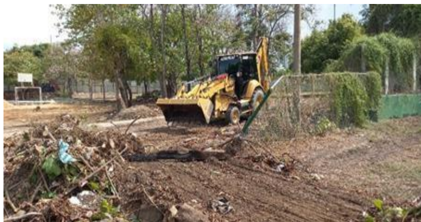
Ilustración 14. Descapote cancha de softbol.
