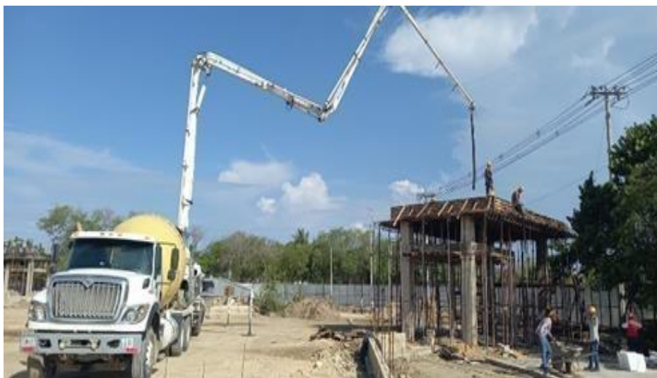
Ilustración 61. Fundida concreto 4000 psi Placa 3er nivel acceso No 2 canal principal
