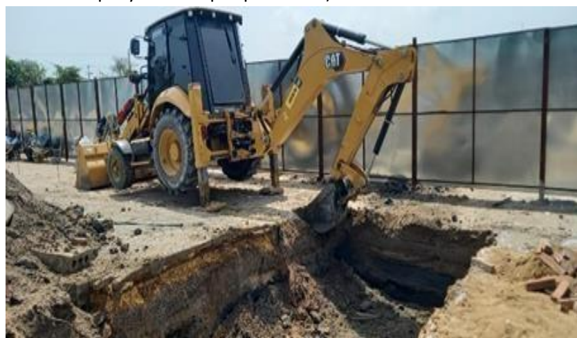
Ilustración 16. Excavación zapatas graderías de futbol
