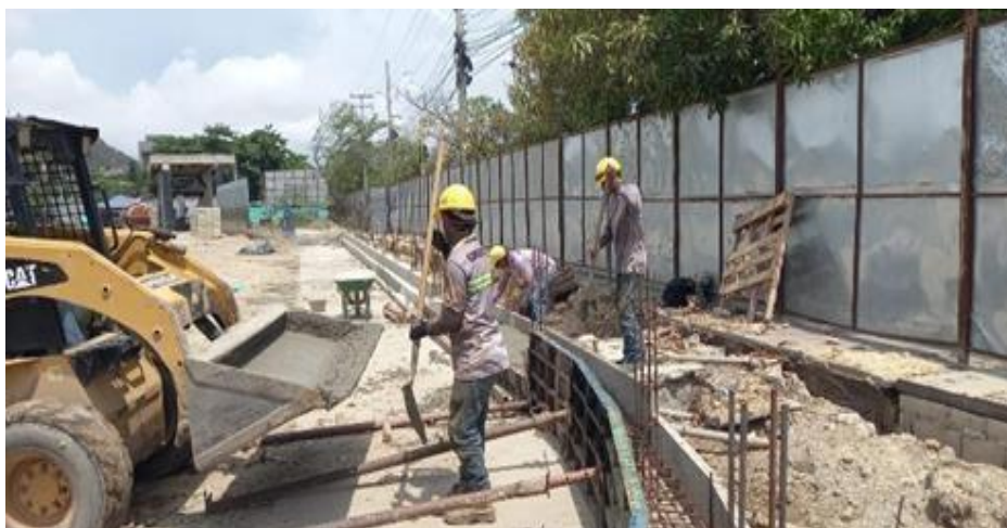
Ilustración 52. Acero refuerzo viga cimentación cerramiento perimetral
