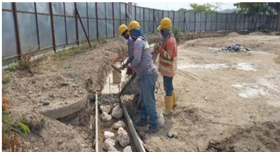
Ilustración 57. Fundida concreto ciclópeo cimentación cerramiento perimetral
