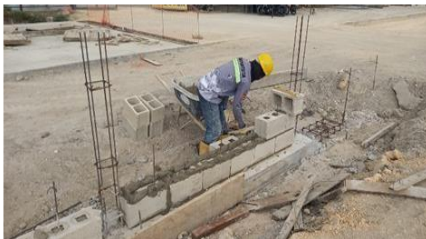
Ilustración 68. Levante en block No 8 muro de cerramiento perimetral
