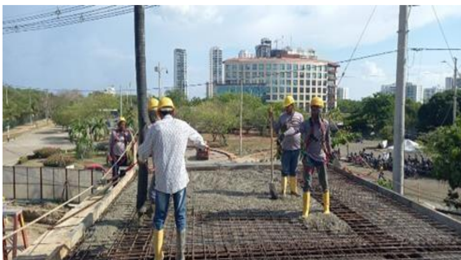
Ilustración 62. Fundida concreto 4000 psi Placa 3er nivel acceso No 2 canal principal
