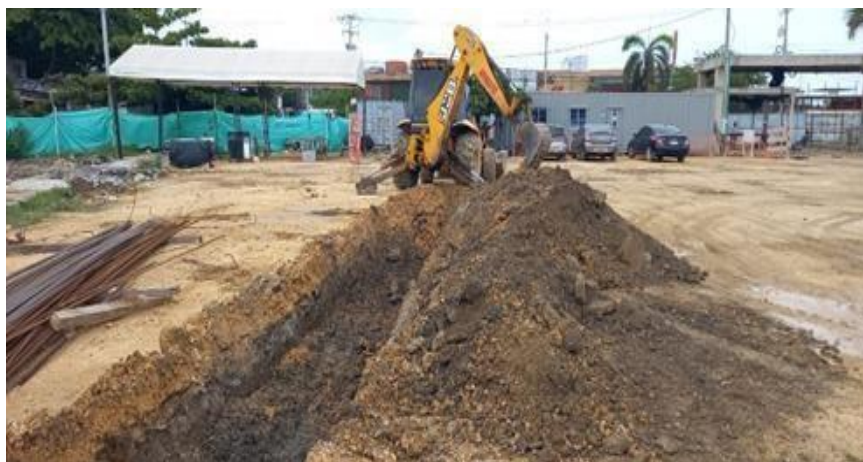
Ilustración 44. Excavación mecánica para cimentación cerramiento cancha futbol 9
