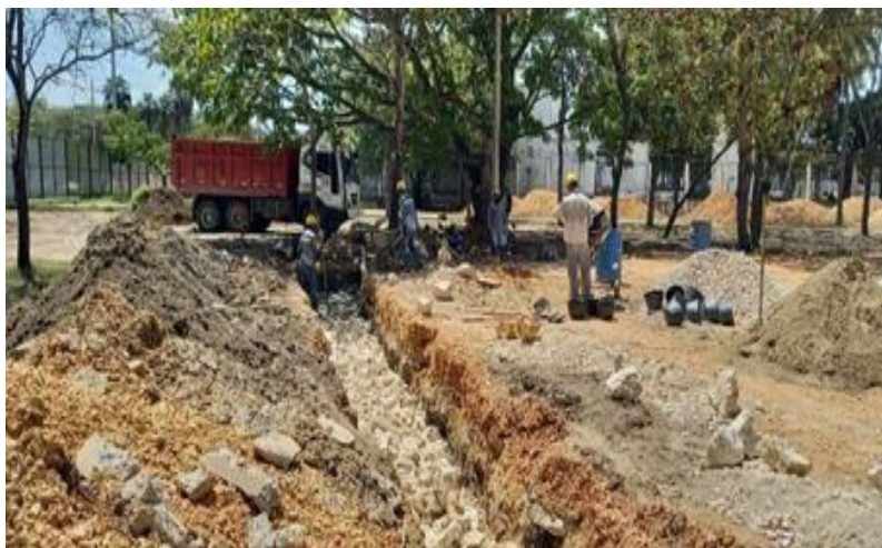
Ilustración 27. Conformación concreto ciclópeo cimentación cerramiento cancha múltiple
