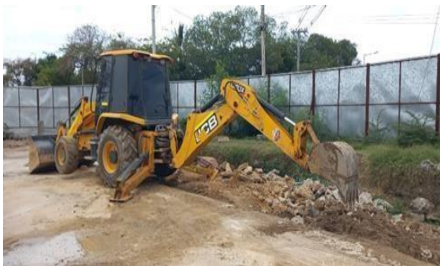
Ilustración 43. Excavación mecánica para cimentación cerramiento perimetral
