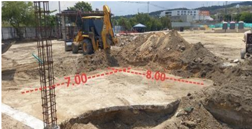
Ilustración 48. Demolición placa de concreto zona de camerinos
