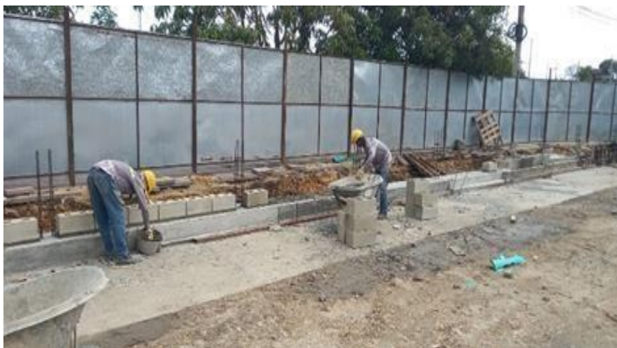
Ilustración 67. Levante en block No 8 muro de cerramiento perimetral
