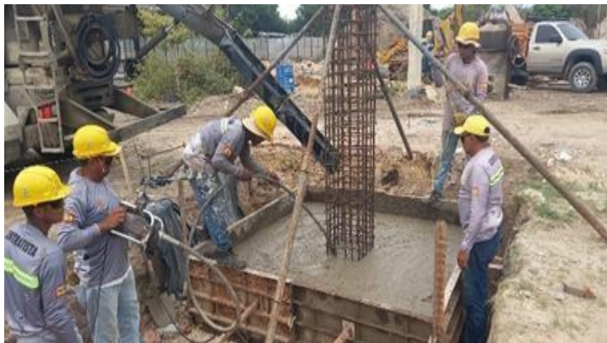
Ilustración 34. Fundida concreto 4000 psi zapatas Z10, Z11 y Z12 graderías cancha de futbol
