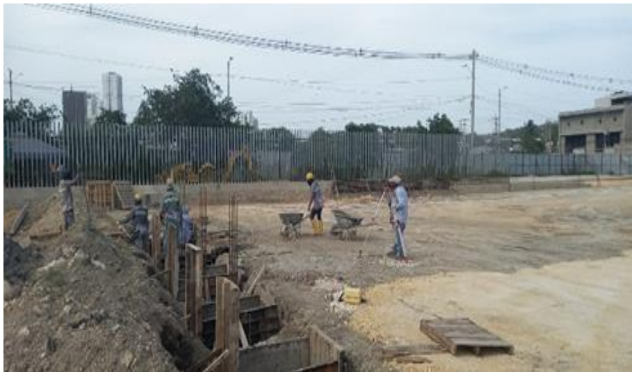
Ilustración 56. Acero de refuerzo zapatas y columnetas cancha futbol 9
