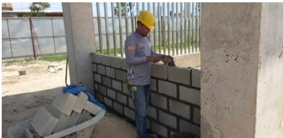
Ilustración 73. Levante en block No 4 garita acceso principal
