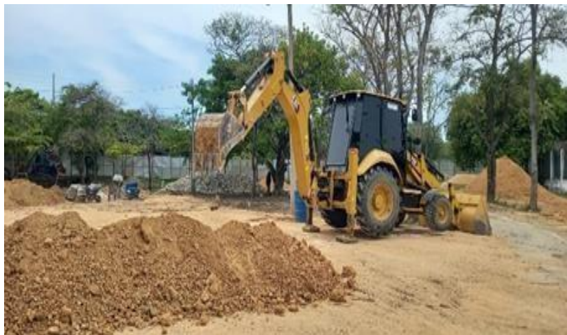
Ilustración 17. Excavación cancha múltiple
