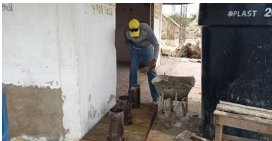
Ilustración 79. Toma de muestras concreto zapatas graderías cancha de futbol
