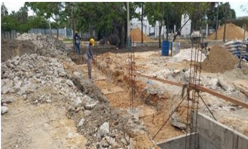
Ilustración 28. Conformación concreto ciclópeo cimentación cerramiento cancha de múltiple
