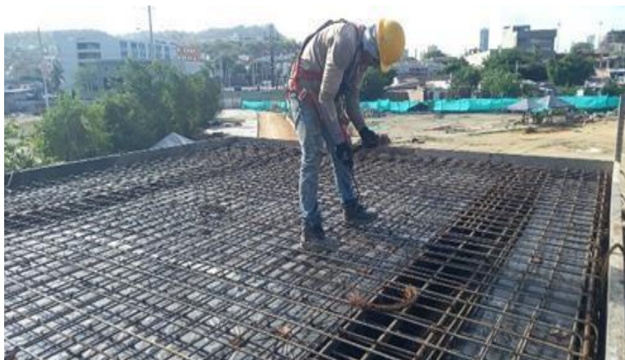
Ilustración 50. Figurado acero placa 3er nivel acceso No 2 Box couvert
