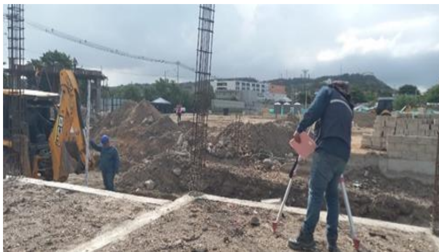
Ilustración 40. Localización y replanteo graderías.
