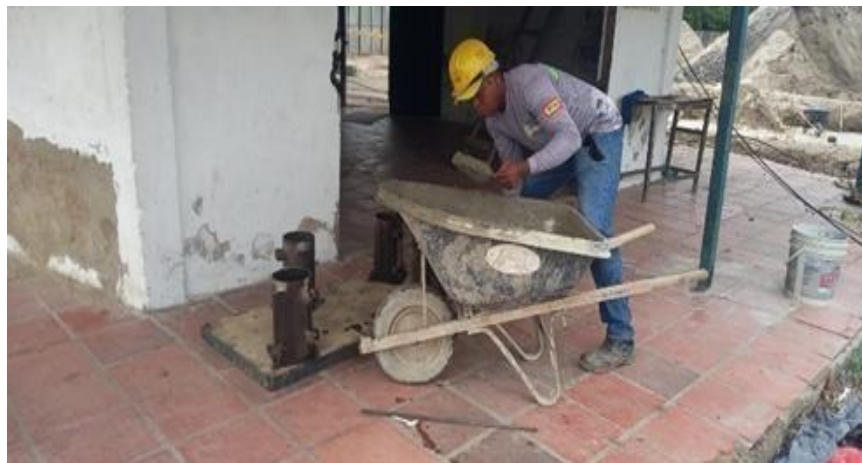
Ilustración 78. Toma de muestras concreto zapatas graderías cancha de futbol
