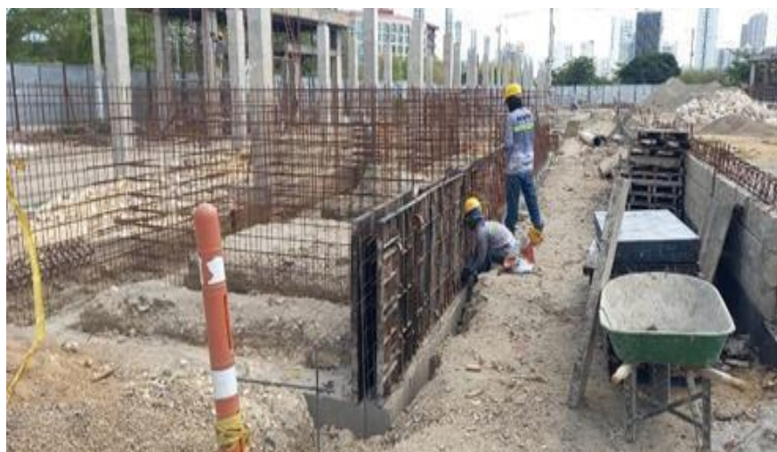
Ilustración 53. Acero refuerzo graderías cancha futbol 11
