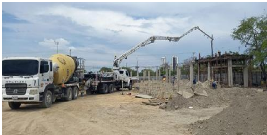
Ilustración 61. Fundida concreto 4000 psi placa 3er nivel acceso No 2 canal perimetral
