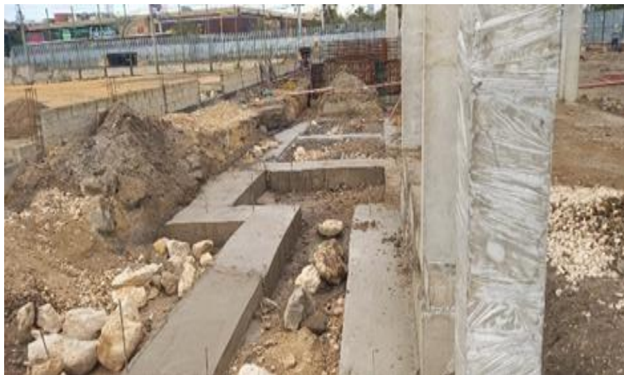
Ilustración 59. Fundida concreto ciclópeo graderías futbol 11
