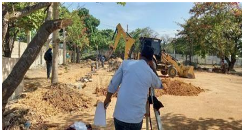
Ilustración 13. Localización y replanteo cerramiento cancha de múltiple.
