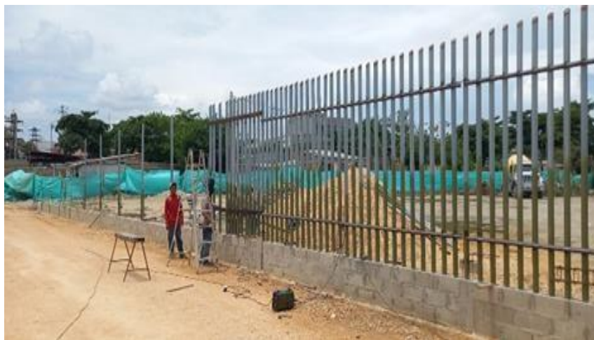
Ilustración 69. Módulos de cerramiento externo sector parqueaderos
