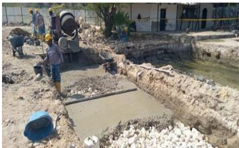
Ilustración 26. Fundida concreto ciclópeo cimentación graderías cancha de softbol
