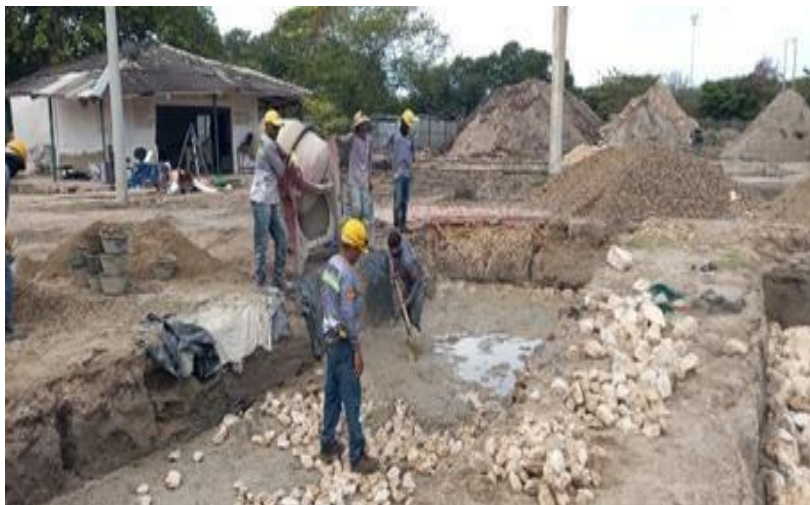
Ilustración 24. Fundida concreto ciclópeo cimentación graderías cancha de futbol
