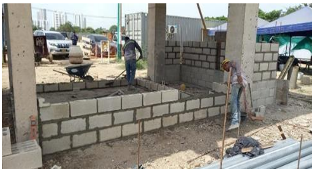
Ilustración 72. Levante en block No 4 garita acceso principal
