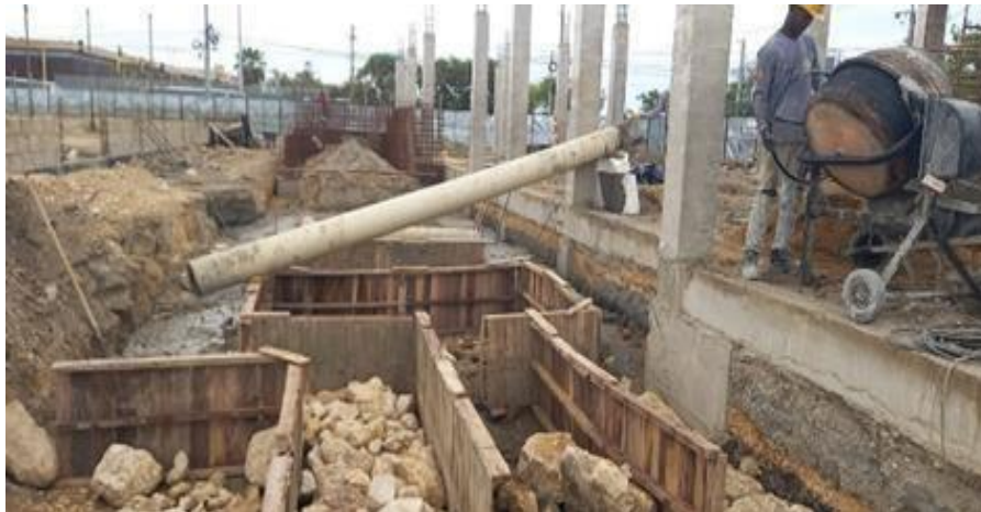
Ilustración 58. Fundida concreto ciclópeo graderías futbol 11
