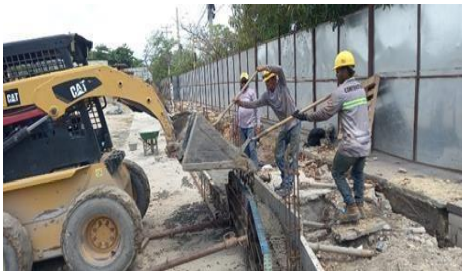
Ilustración 63. Fundida concreto 4000 psi vigas de cimiento cerramiento externo
