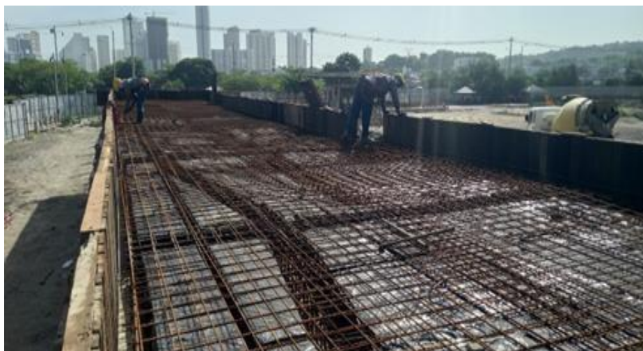
Ilustración 55. Acero de refuerzo Placa baterías de baños y camerinos
