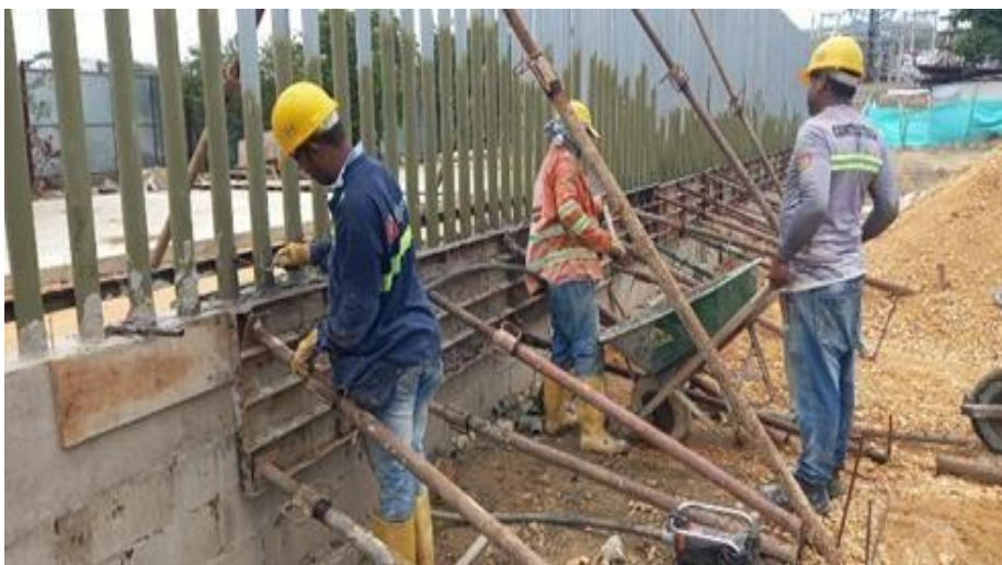
Ilustración 64. Fundida concreto 4000 psi vigas de muro de cerramiento externo
