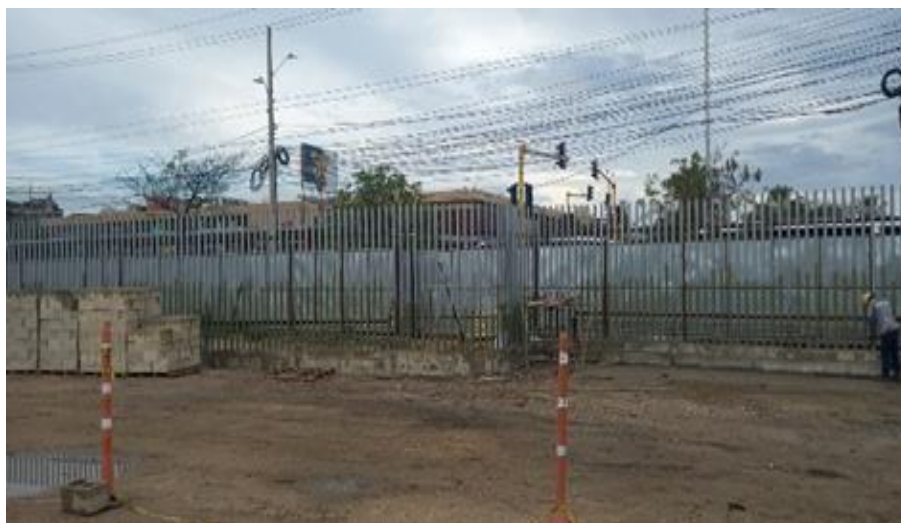
Ilustración 71. Instalación Módulos de tubería de cerramiento externo acceso principal
