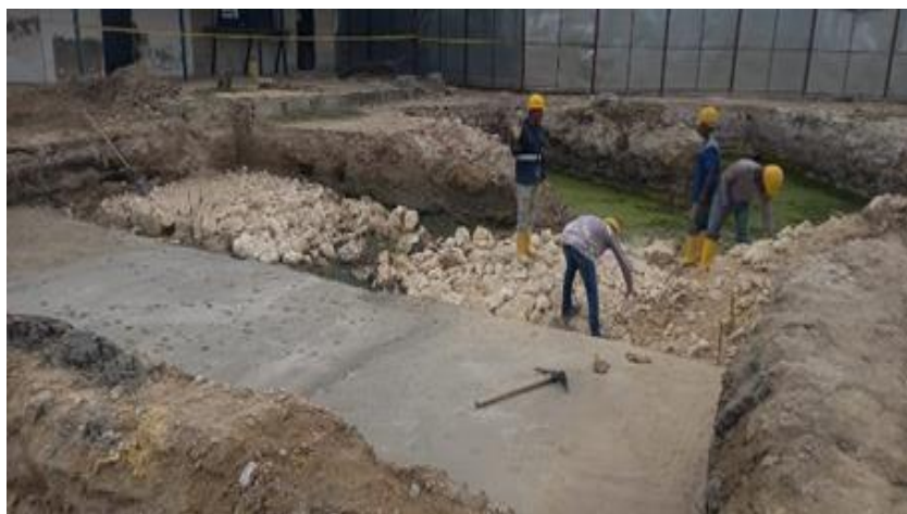
Ilustración 25. Conformación concreto ciclópeo cimentación graderías cancha de softbol
