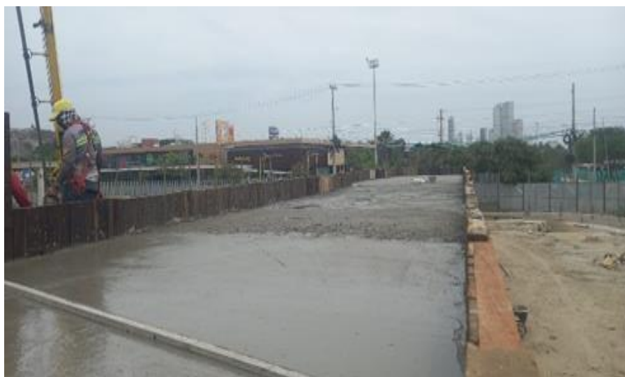
Ilustración 66. Fundida concreto 4000 psi placa baterías de baños
