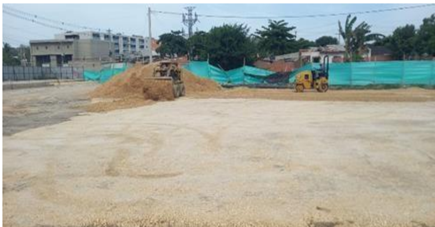
Ilustración 46. Relleno y compactación cancha futbol 9
