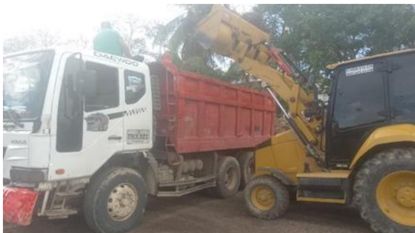
Ilustración 19. Retiro material excavaciones graderías.
