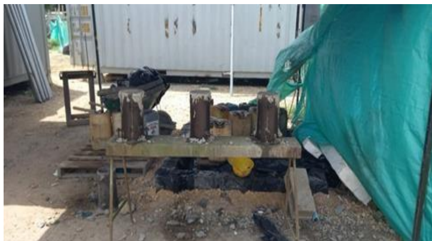
Ilustración 76. Toma de muestras concreto Placa baterías de baños y camerinos
