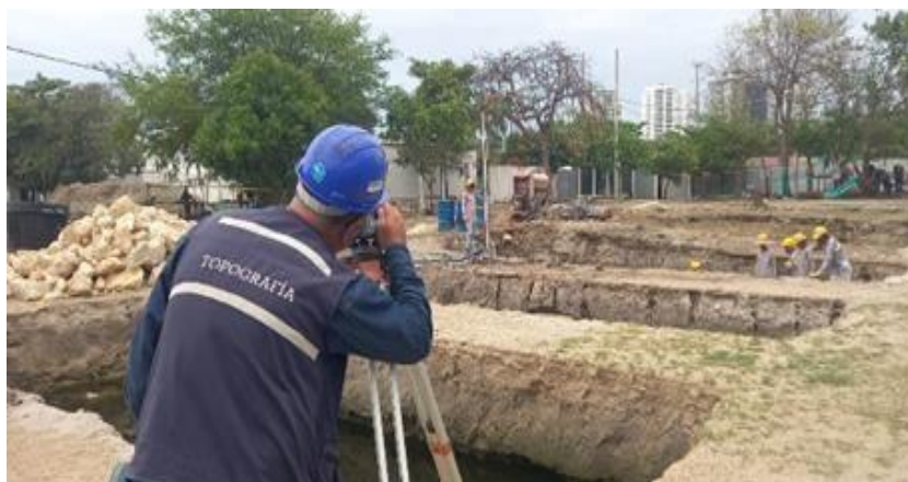
Ilustración 11. Localización y replanteo zapatas graderías cancha de fútbol.
