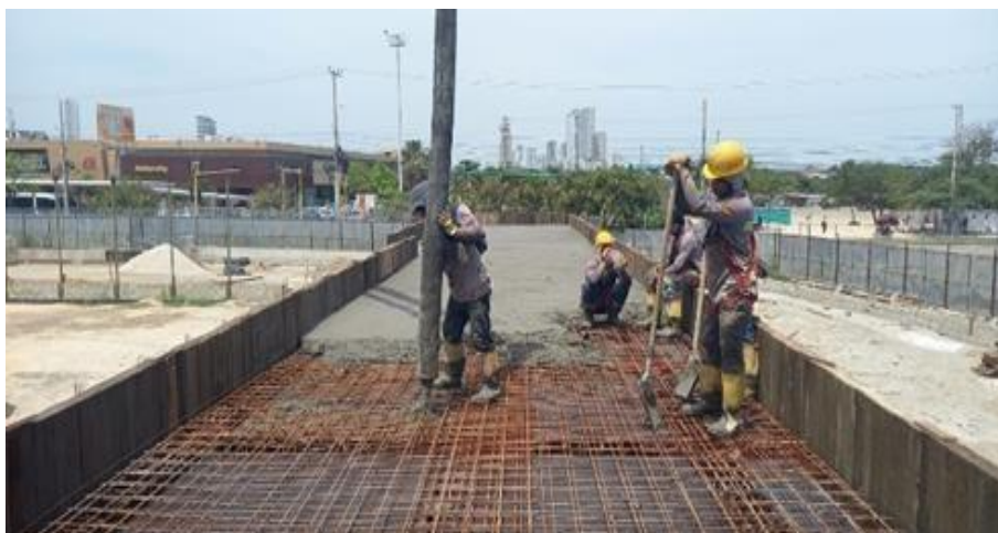
Ilustración 65. Fundida concreto 4000 psi placa baterías baños
