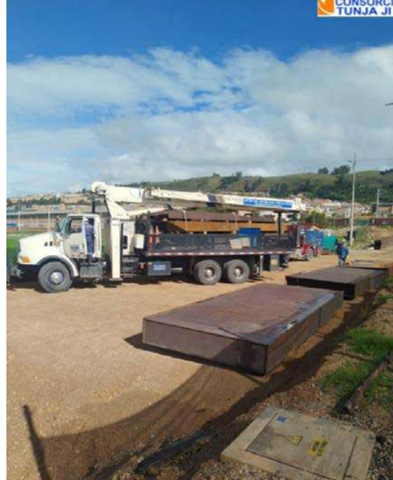
Suministro, Transporte ,Fabricación, Ensamblaje Y Montaje De Estructura Metálica – (Acopio en Sitio)
