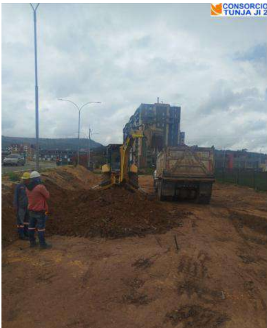
Transporte De Material De Afirmado Y/O Granular Después De 5 Km (Instalado Y Compactado Según Sección De Diseño).
