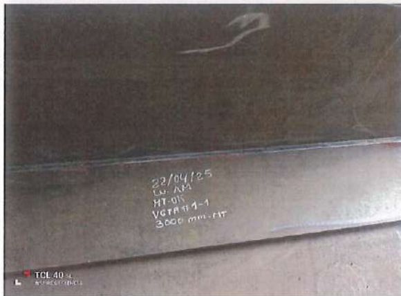
FOTOGRAFIA # 1: Evidencia Inspección MT
