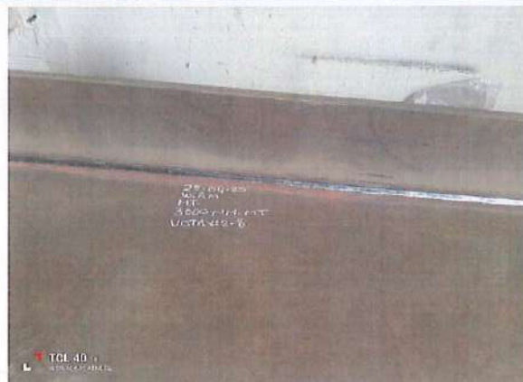
FOTOGRAFIA # 2: Evidencia Inspección MT
