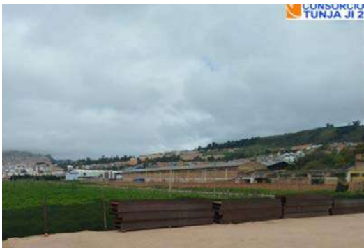
Suministro, Transporte ,Fabricación, Ensamblaje Y Montaje De Estructura Metálica – (Acopio en Sitio)
