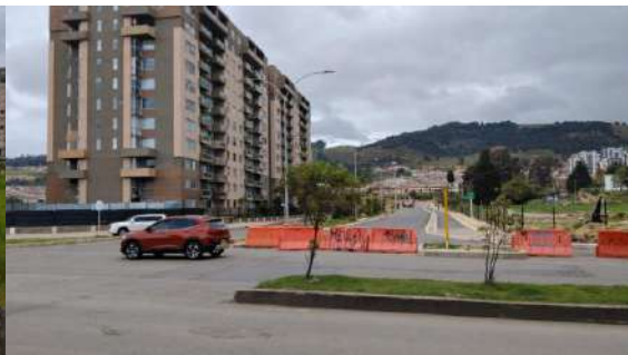
Cerramiento Con maletines Cruce Unidad Residencia Hayuelos
