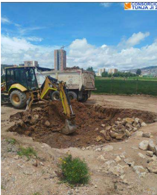
Excavación De Cortes, Canales Y Prestamos En Material Común A Maquina Incluye Carga Y Acarreo Libre De 5 Km
