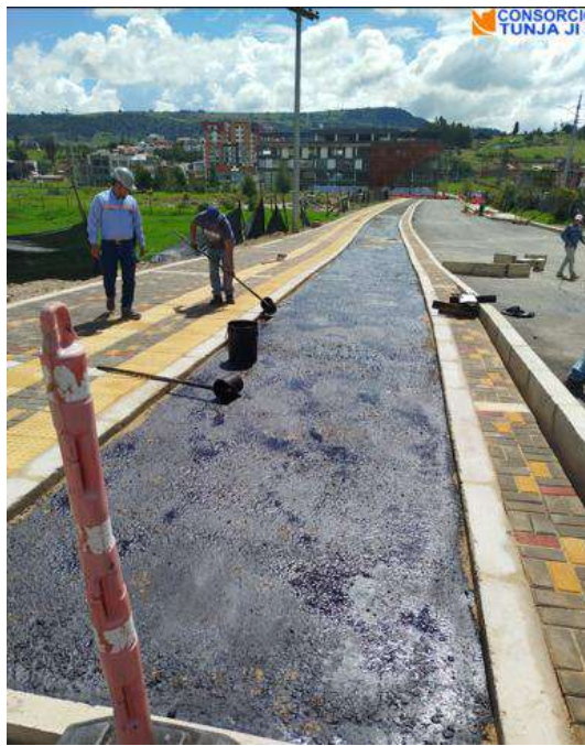
Imprimación Con Emulsión Asfáltica Crl-1h
