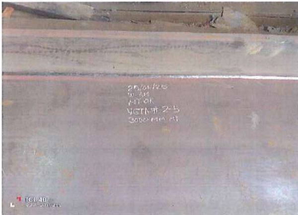
FOTOGRAFIA # 3: Evidencia Inspección MT
