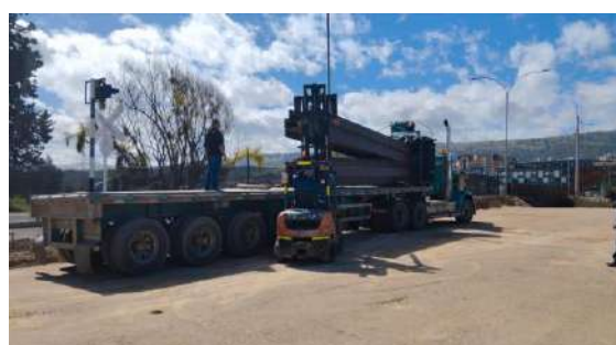
Suministro, Transporte ,Fabricación, Ensamblaje Y Montaje De Estructura Metálica – (Acopio en Sitio)
