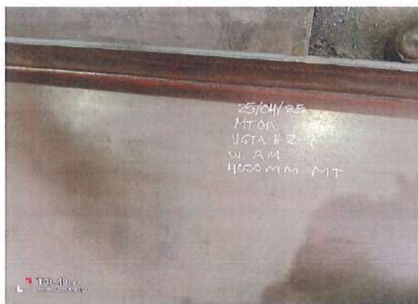
FOTOGRAFIA # 4: Evidencia Inspección MT
