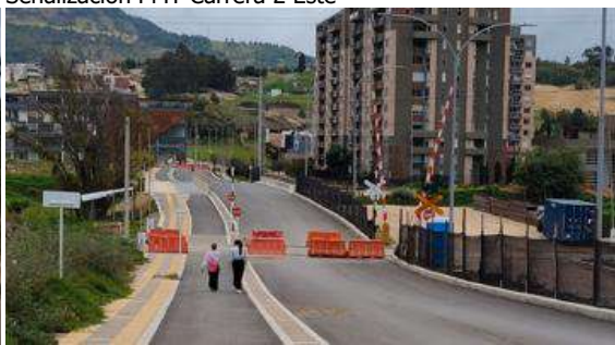
Señalización PMT y cerramiento con maletines Carrera 2 Este
