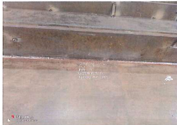
FOTOGRAFIA # 4: Evidencia Inspección MT
