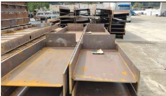
Suministro, Transporte ,Fabricación, Ensamblaje Y Montaje De Estructura Metálica – (Acopio en Bodega)
