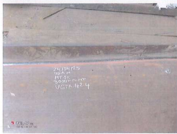
FOTOGRAFIA # 2: Evidencia Inspección MT
