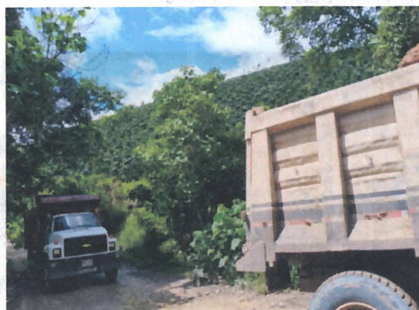
Ilustración 13. Transporte de materiales provenientes de excavación
