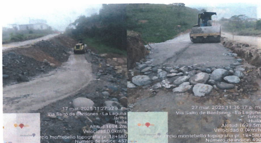
Ilustración 40. Terraplén Conformado en tramo 3.
