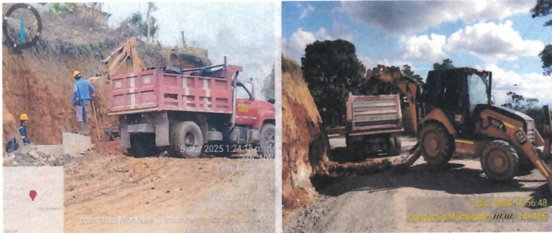
Ilustración 48. Excavación de material común seco en el tramo 3
