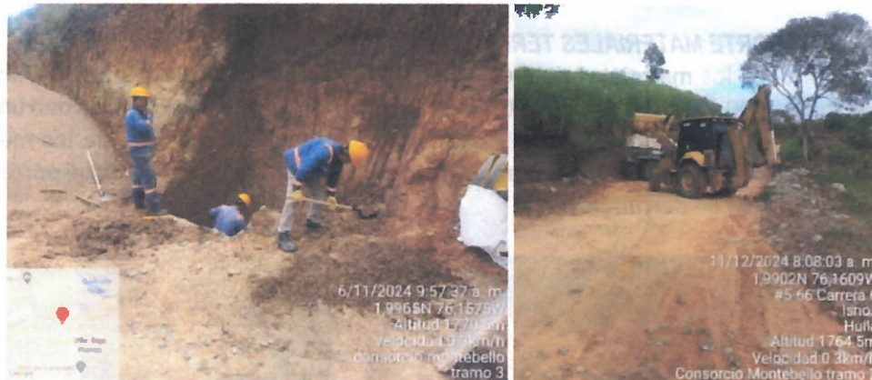
Ilustración 46. Excavación de material común seco en alcantarilla tramo 3.
