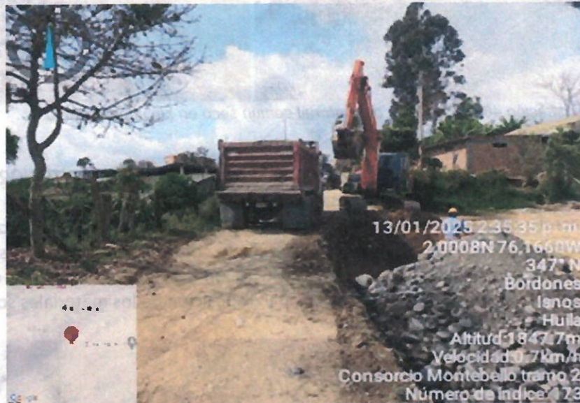
Ilustración 45. Transporte de material de mejoramiento en tramo 3.
