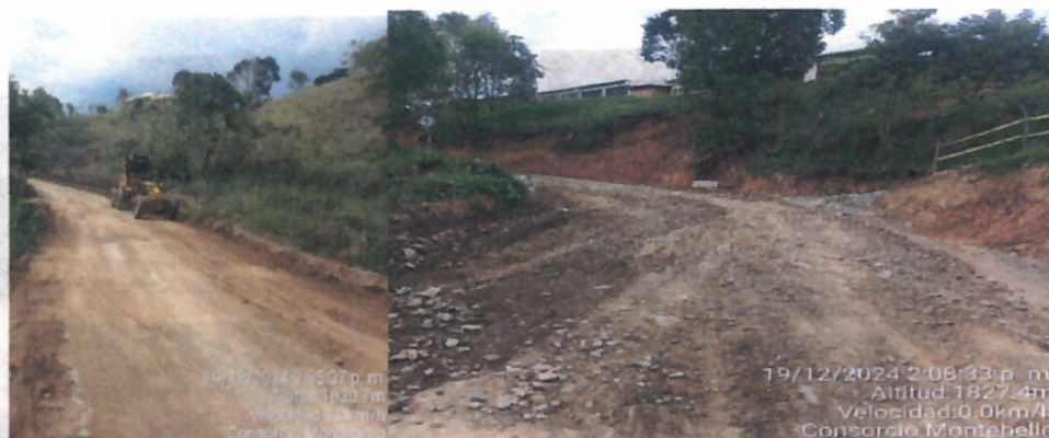
Ilustración 18. Instalación de material de mejoramiento en tramo 2
