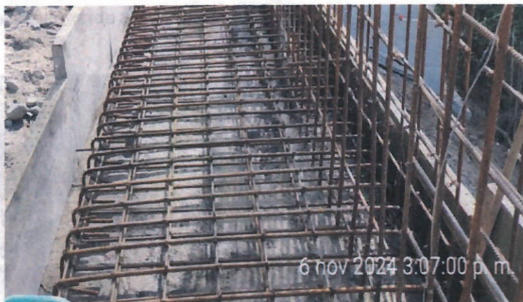
Ilustración 33. Solado para muro de contención en tramo 2
