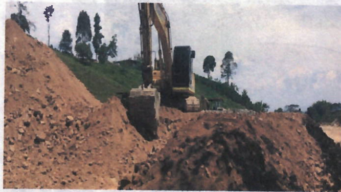
Ilustración 7. Conformación y renivelación en tramo 1.
