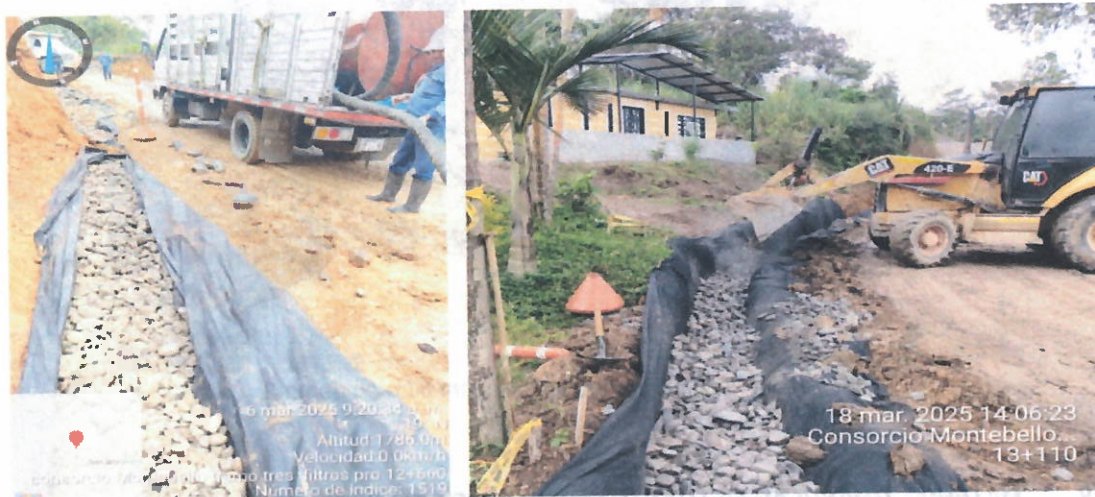
Ilustración 32. Instalación de material granular filtrante en tramo 2.
