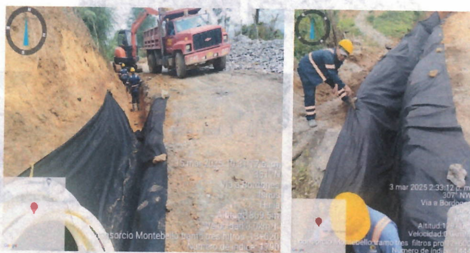
Ilustración 30. Instalación de geotextil para filtro en tramo 2.
