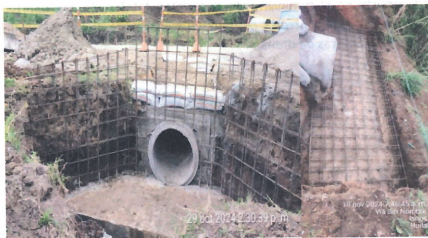
Ilustración 25. Suministro e instalación de acero de refuerzo en tramo 2
