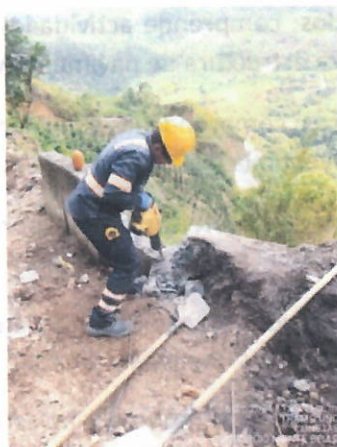
Ilustración 4. Demolición en estructuras de concreto
