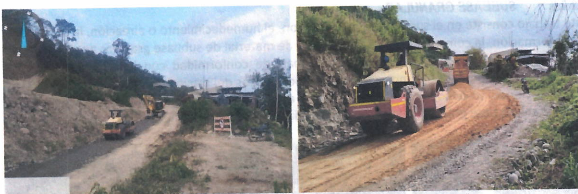
Ilustración 17. Instalación de material de mejoramiento en tramo 2
