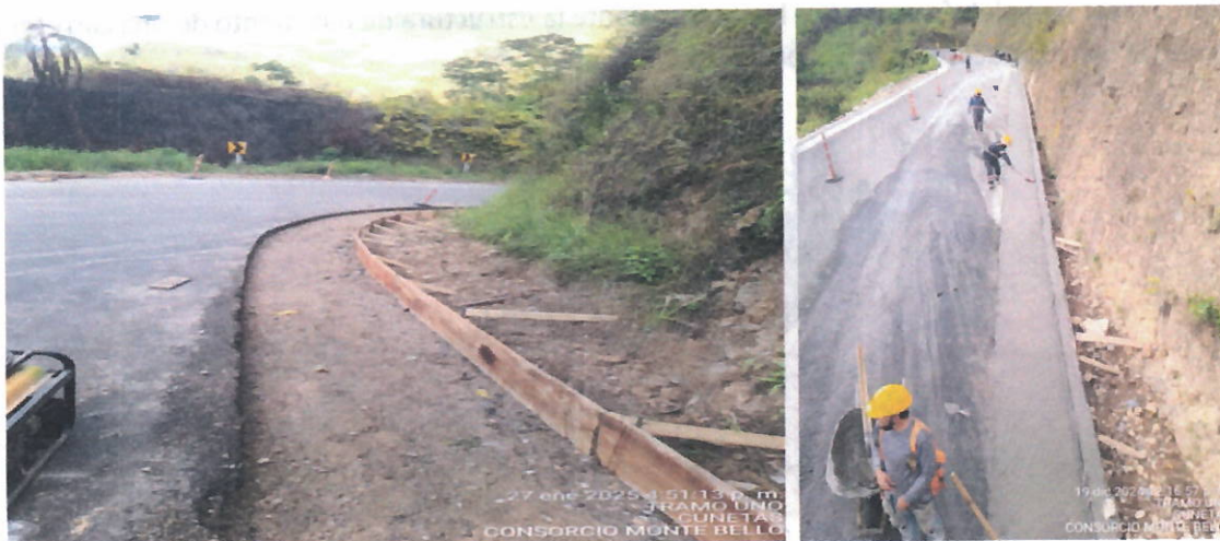
Ilustración 9. Cuneta en tramo 1
