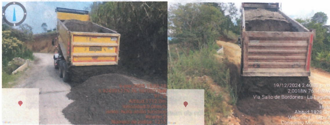
Ilustración 20. Transporte de subbase granular en tramo 2.
