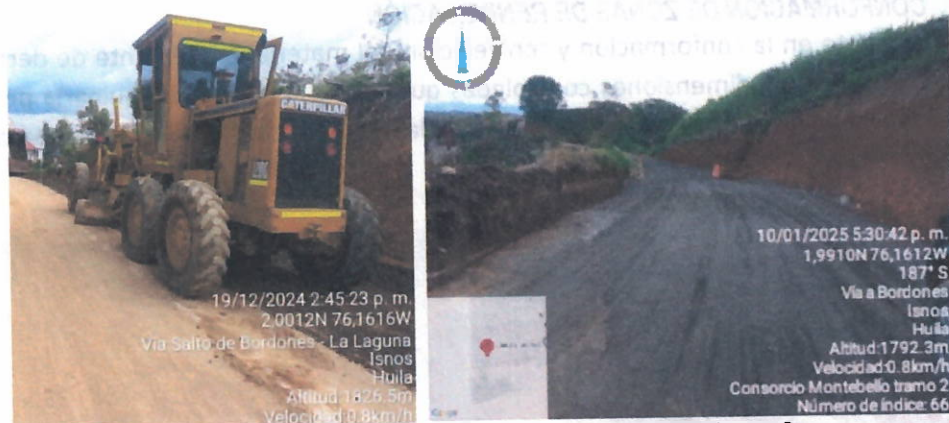
Ilustración 16. Instalación de subbase granular en tramo 2
