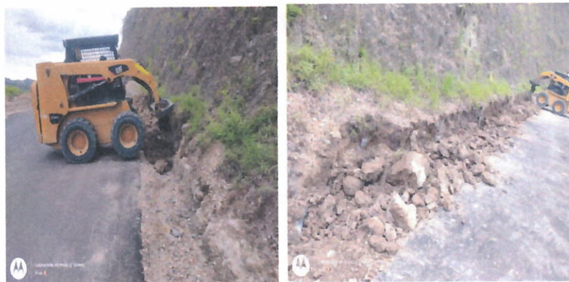
Ilustración 5. Excavación en roca – explanación y canales
