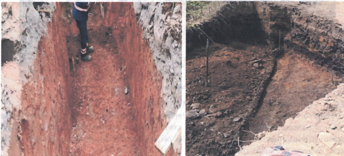
Ilustración 21. Excavación sin clasificar en tramo 2
