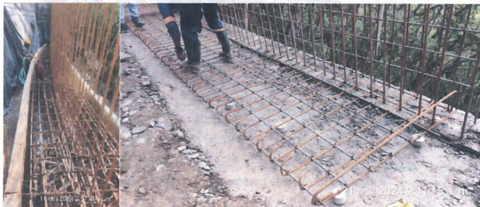
Ilustración 35. Instalación de acero de refuerzo
