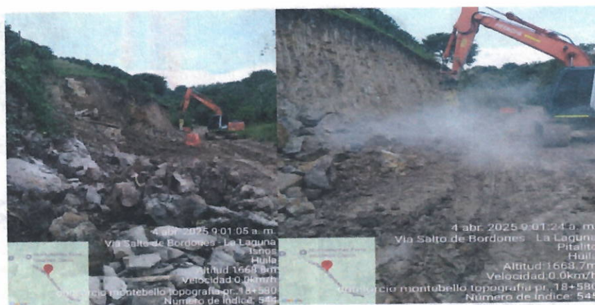
Ilustración 39. Excavación en roca en tramo 3.
