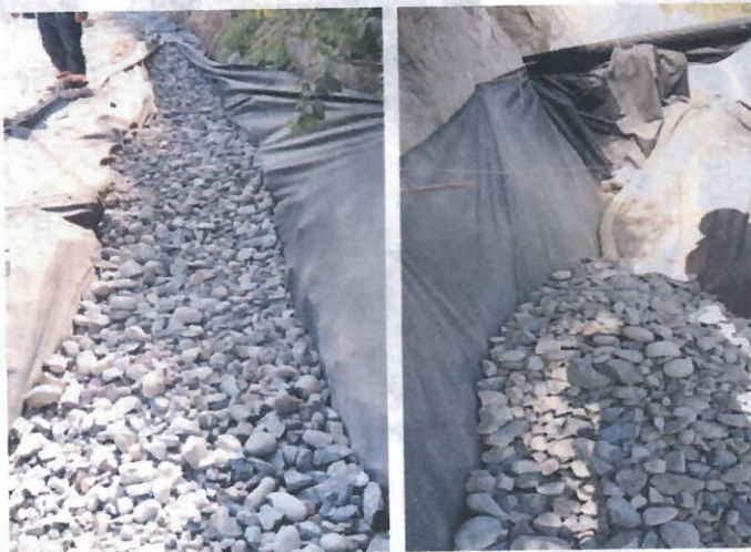
Ilustración 31. Instalación de material granular filtrante en tramo 2.
