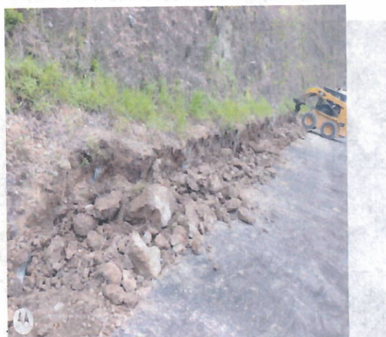
Ilustración 8. Excavación de material común seco en tramo 1
