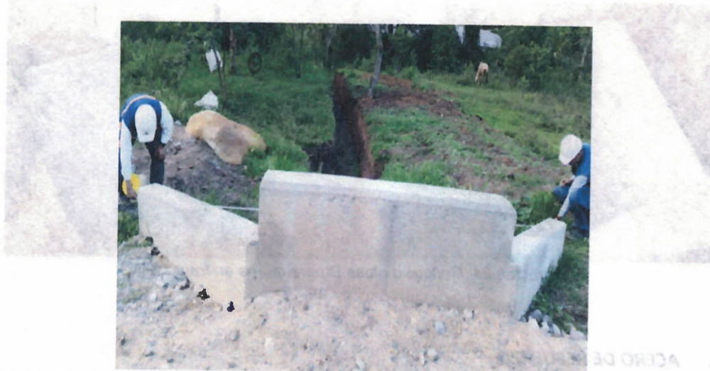
Ilustración 22. Relleno de estructuras de drenaje en tramo 2
