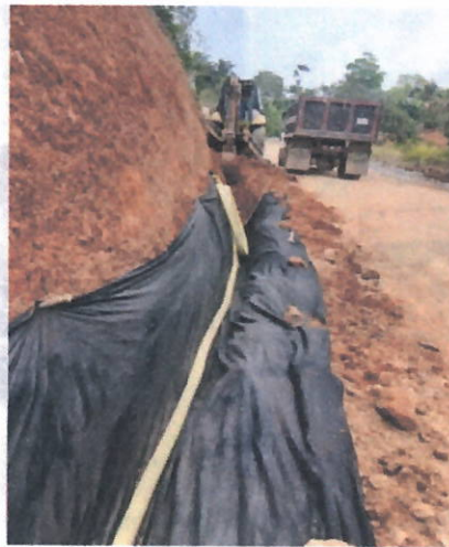
Ilustración 50. Instalación de geotextil para filtro en tramo 3
