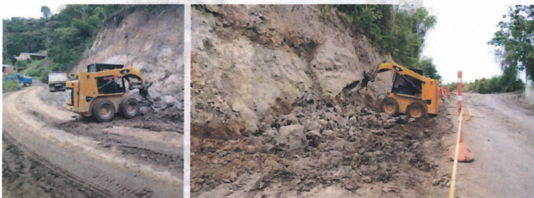
Ilustración 11. Excavación de roca para filtro en tramo 2
