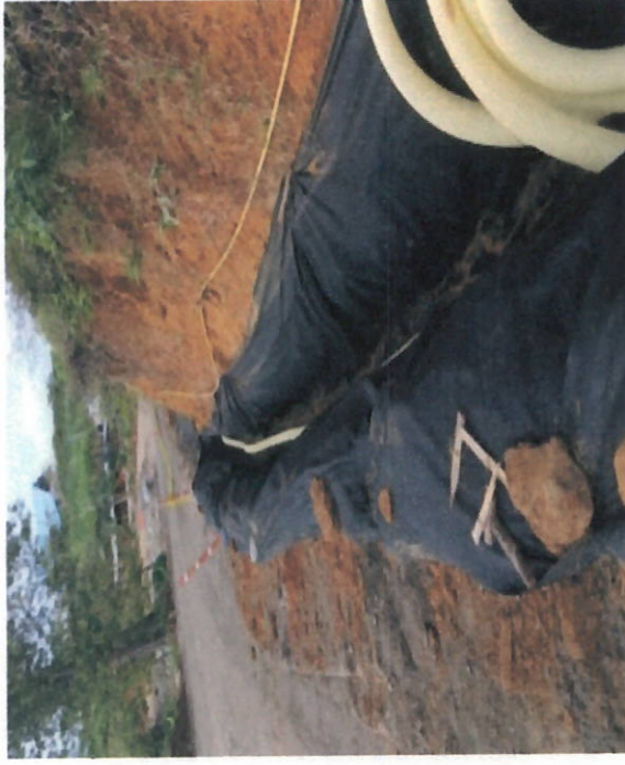
DREN LONGITUDINAL CON TUBERÍA DE PVC DE 100 MM PARA FILTRO
