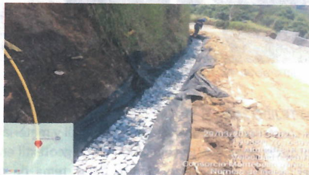
Ilustración 51. Instalación de material granular filtrante en tramo 3.
