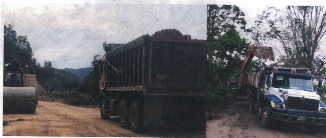
Ilustración 41. Transporte de material de explanación en tramo 3.
