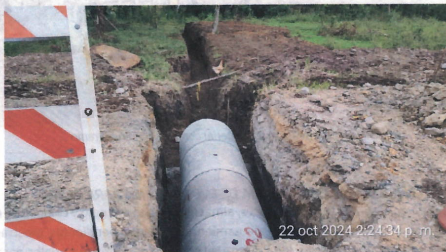
Ilustración 26. Colocación de tubería de concreto reforzado de 900mm en tramo 2
