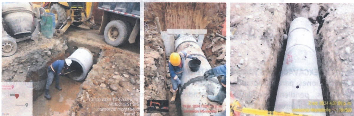
Ilustración 47. Colocación de tubería de concreto reforzado de 900mm en tramo 3.
