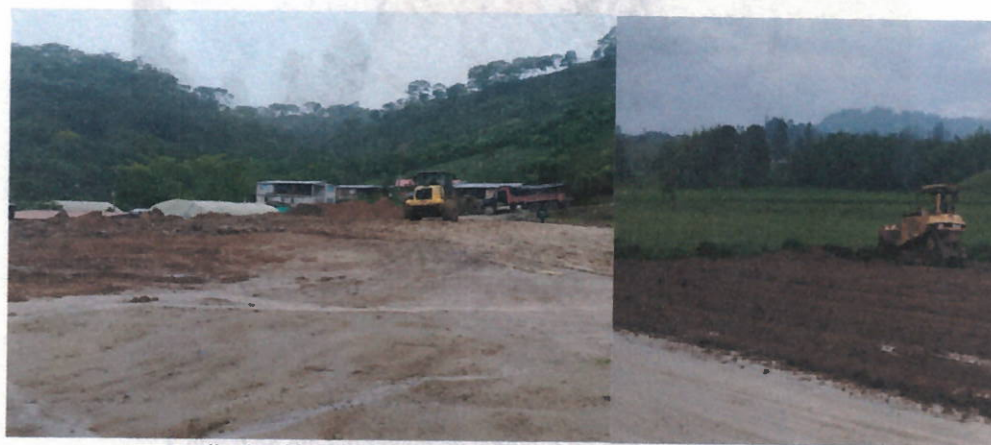
Ilustración 42. Conformación y renivelación en tramo 3.
