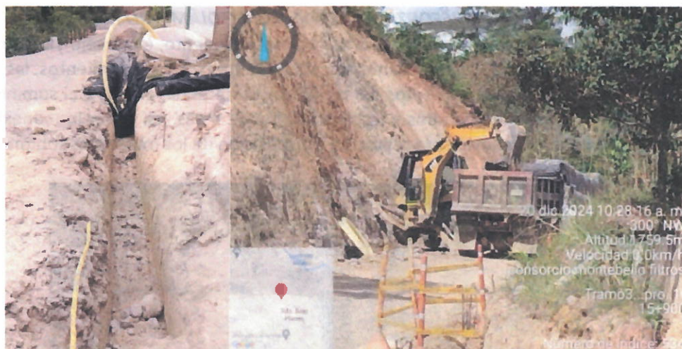
Ilustración 27. Excavación de material común seco en el tramo 2.
