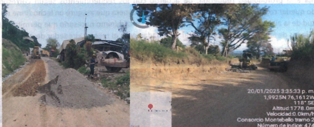
Ilustración 19. Transporte de material de mejoramiento en tramo 2
