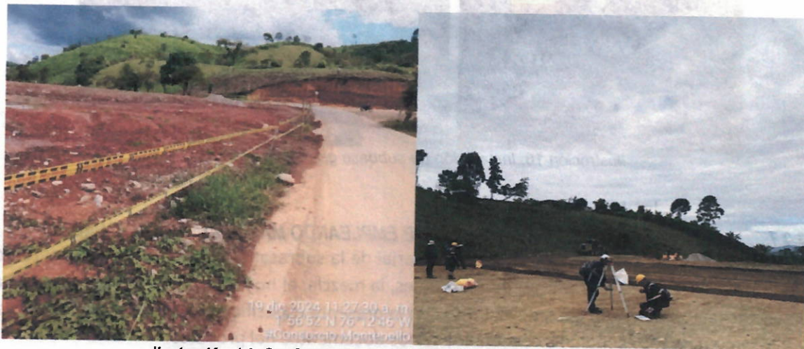
Ilustración 14. Conformación y renivelación en Zodme en tramo 2.
