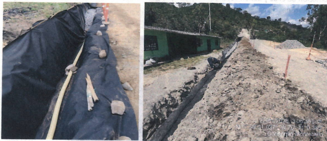
Ilustración 29. Instalación de geotextil para filtro en tramo 2.
