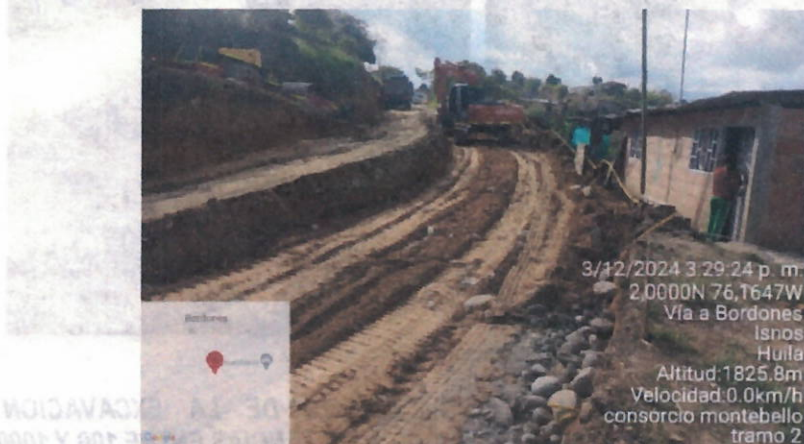
Ilustración 10. Excavación sin clasificar de la explanación y canales.
