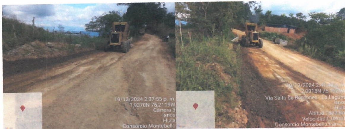
Ilustración 43. Instalación de subbase granular en tramo 3.
