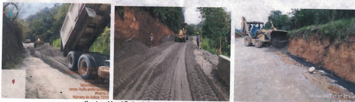
Ilustración 15. Instalación de subbase granular en tramo 2.
