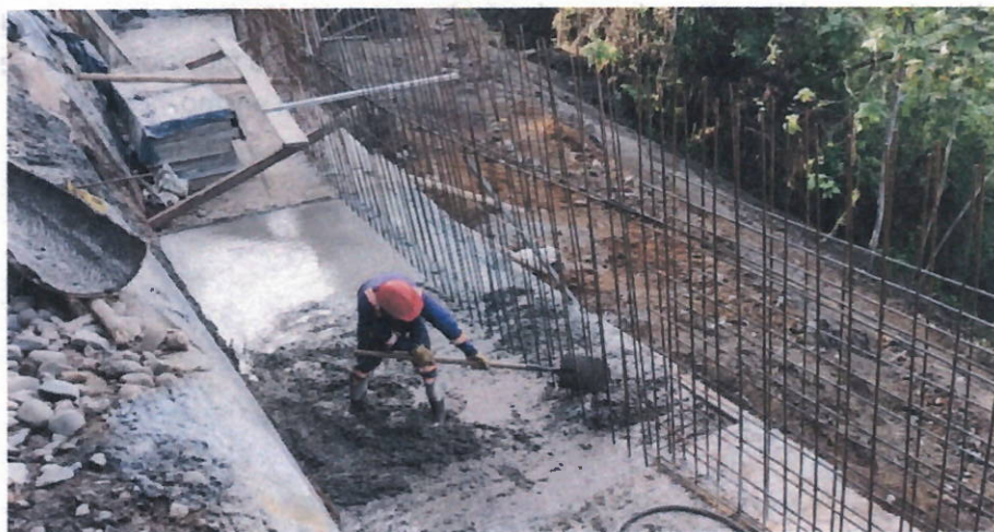
Ilustración 34. Instalación de concreto clase D para muros
