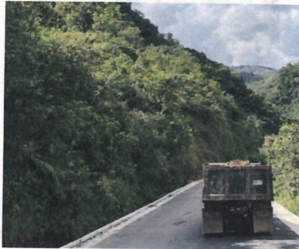
Ilustración 6. Transporte de material de excavaciones (explanación)
