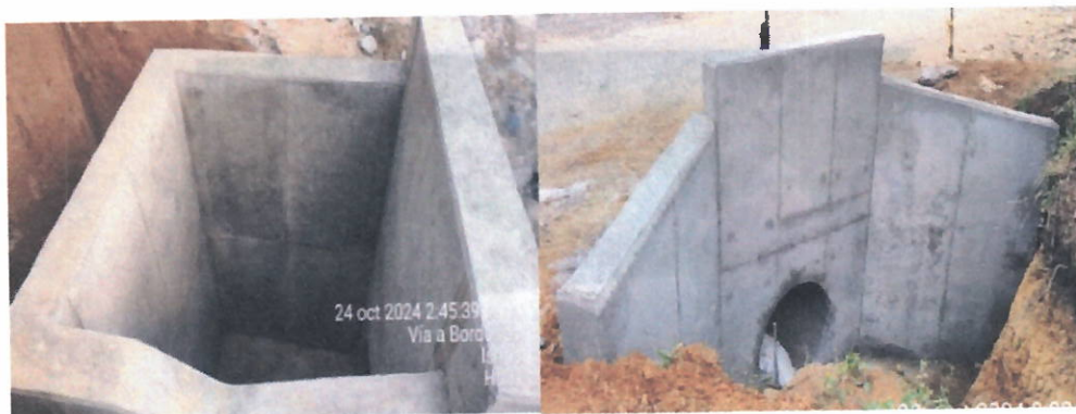
Ilustración 24. Concreto clase D para muros en tramo 2
