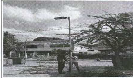
Instalacion de luminarias solares
