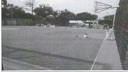
Pintura de canchas.
