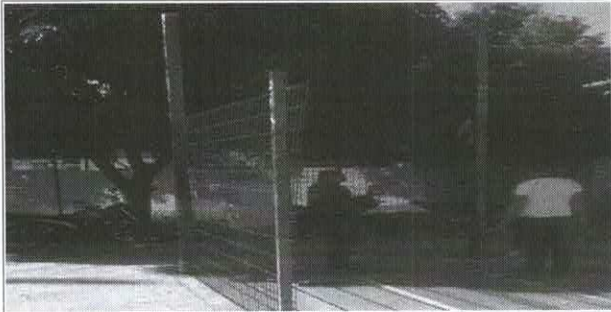
Colocacion cerramiento canchas
