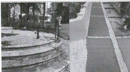
Limpieza de pisos y reposición de andenes demolidos.
