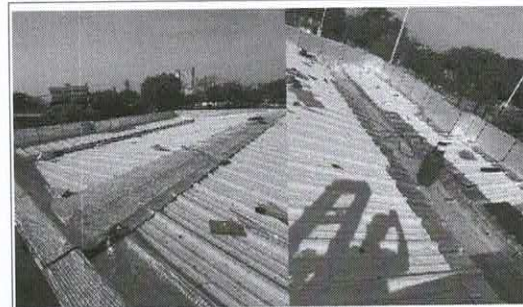
impermeabilización de viga canales de cubierta.
