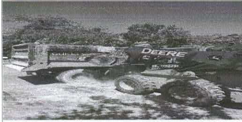
Retiro de escombros y basura.
