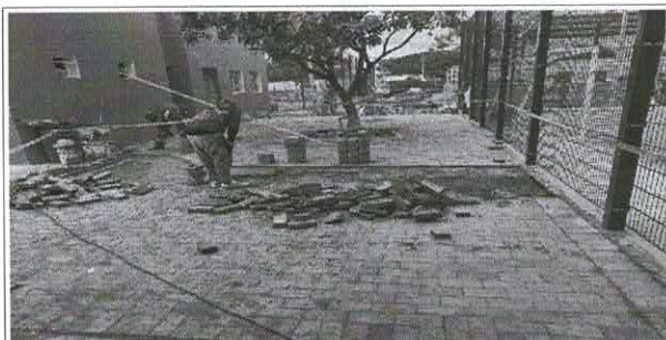
Nivelación de cama de arena, limpieza y reacomodación de adoquines.
