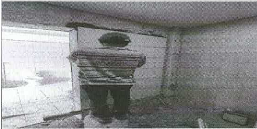
Enchape de muros de baños.
