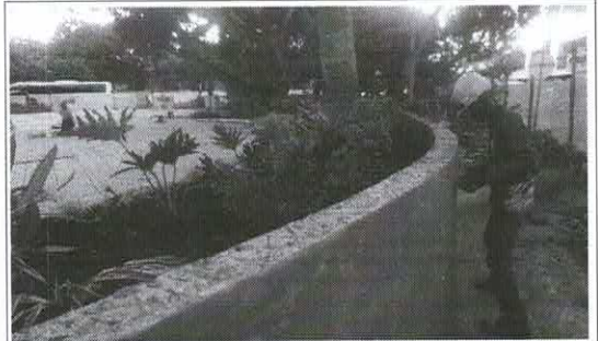
Muro detrás tarima proceso pañetado impermeabilizado
