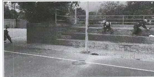
Pañetado de graderías grandes
