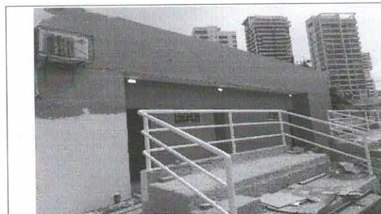
Instalación de luminaria tipo tortuga.
