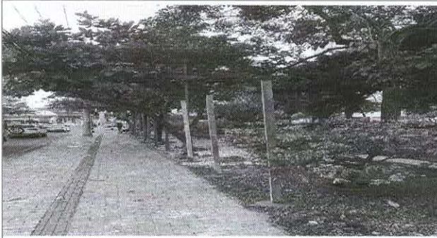
Instalacion de pedestales para cerramiento en lona verde.
