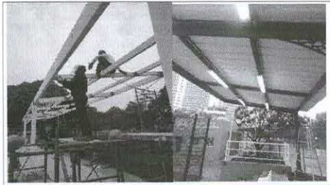
Instalación de cubierta para techo de graderías.
