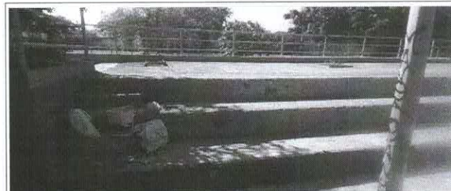
Retiro de pañetes en mal estado de graderías grandes
