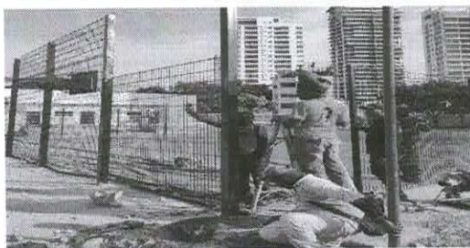
Instalación de tubería y mallas de cerramiento.
