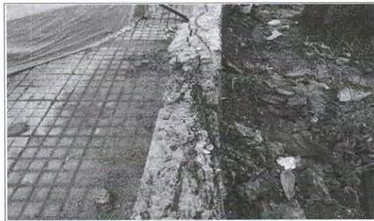
Aspecto de viga en parque Lacides de jardineras a reconstruir
