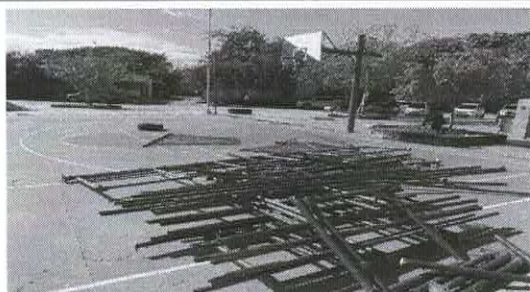
Retiro de cerramiento existente en canchas.
