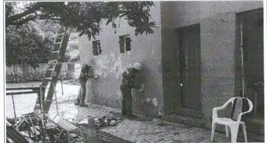
Durante retiro pintura y adecuacion superficie muros exteriores de edificación
