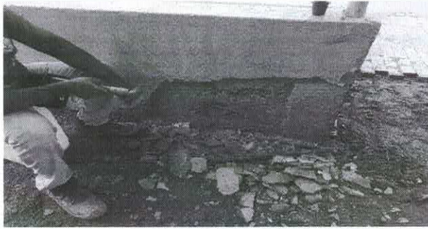
demolicion de apeñetes en mal estado.
