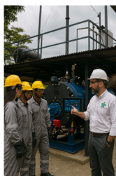
Modernización Caldera bajo Resolución 1857 de 2024
