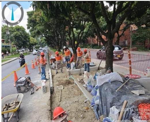
Construcción de rampa en cicloruta
