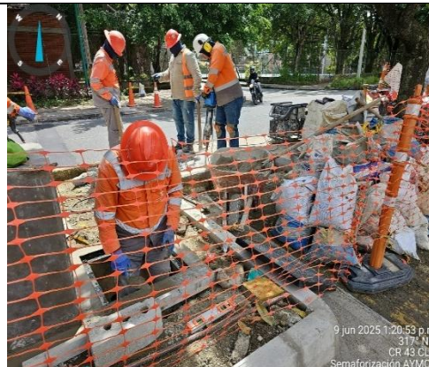
Construcción de cajas de empalme y conexión
