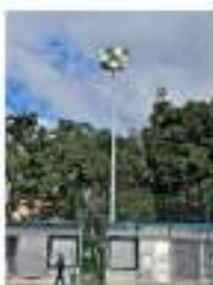
Torre 1 Iluminacion occidental central 20250307.jpeg 394K
