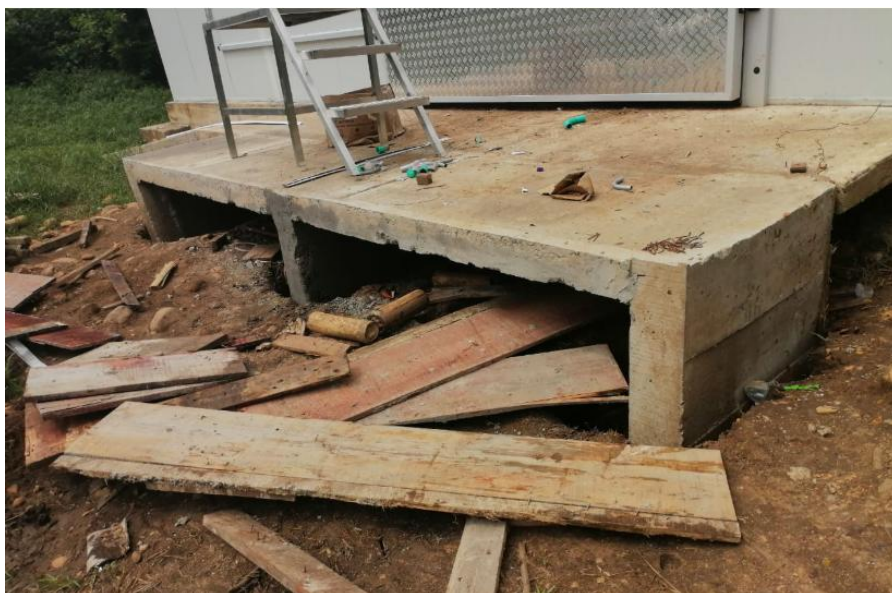
Foto 6. Cuadrilla desencofo de placa para sacrificadero
