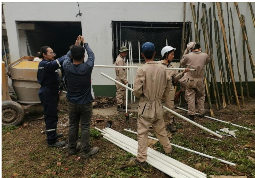
Foto 4. Cuadrilla en construcción del prototipo de Domo geodésico
