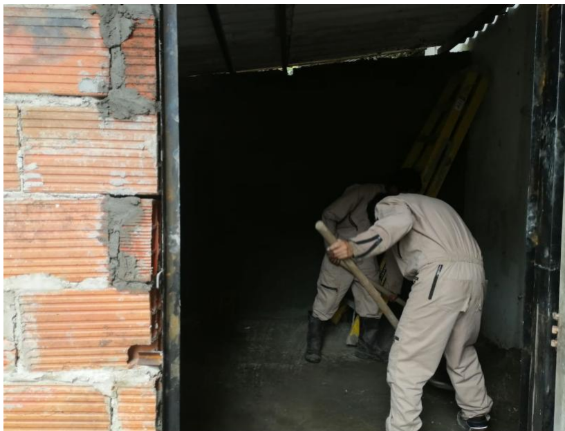
Foto 5. Cuadrilla de construcción bodega para semillas
