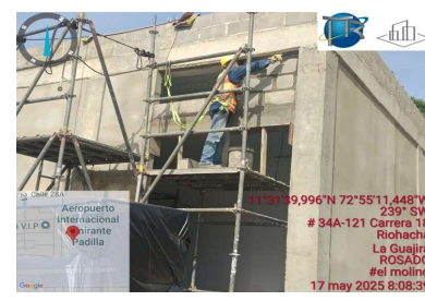
Levante de mampostería en dintel de acceso de equipos
