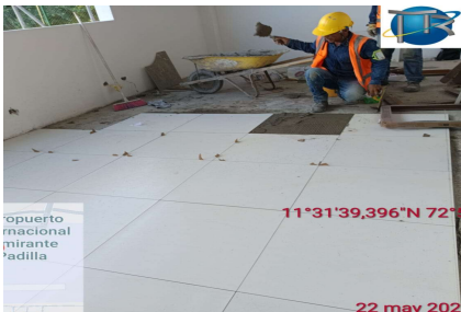
Se realiza acompañamiento SST durante la actividad de instalación de baldosa en zona de taller
