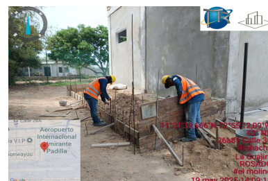
Encofrado de en zona posterior de la subestación
