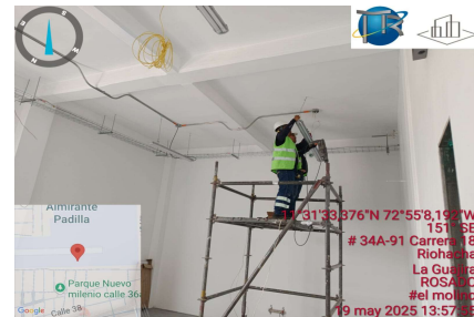
Instalación de iluminación
