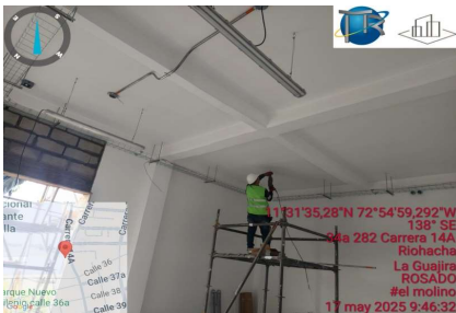
Instalación de tunería y accesorios EMT
