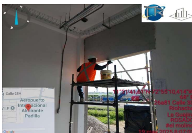
Aplicación de base y estuco en dintel
