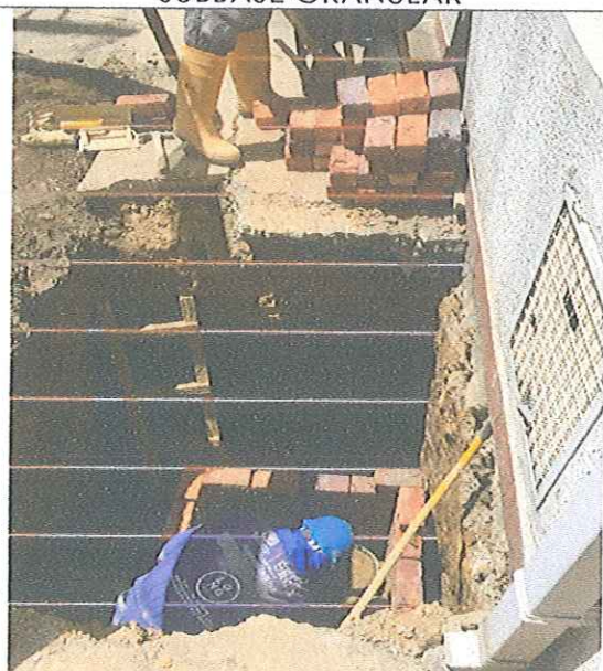
CONSTRUCCIÓN DE CAJAS DE INSPECCIÓN
