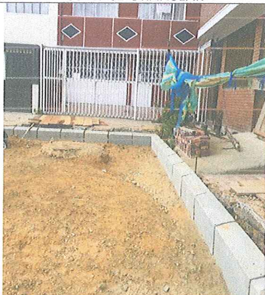
INSTALACIÓN DE LOS PREFABRICADOS A-85 BAJO RAMPA
