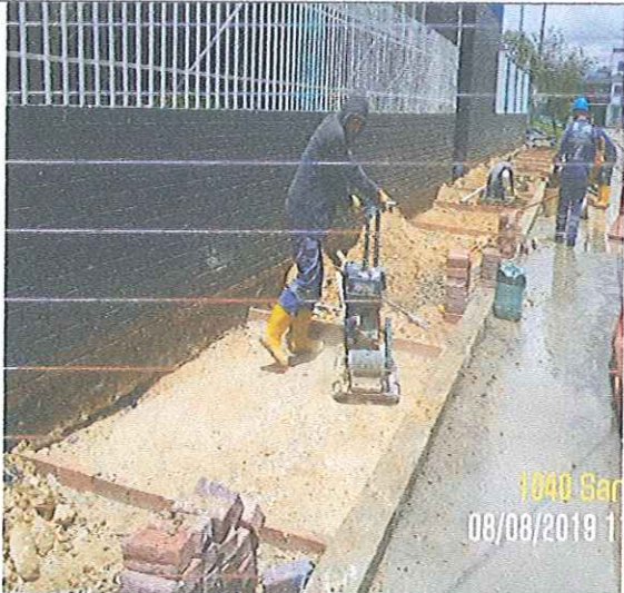
CONFORMACIÓN Y ADECUACIÓN DEL ESPACIO PÚBLICO DEL JARDIN
