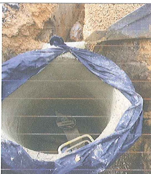
CONSTRUCCIÓN DEL POZO DE SANITARIO
