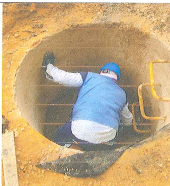
CONSTRUCCIÓN DEL POZO DE LA RED SANITARIA
