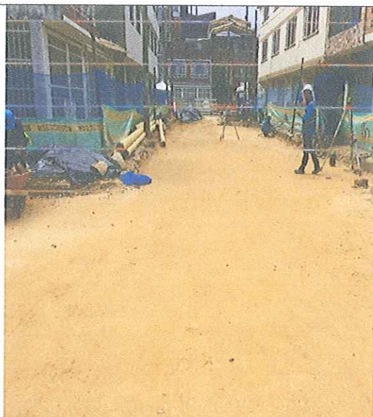
INSTALACIÓN Y COMPACTACIÓN DE LA SUBBASE GRANULAR
