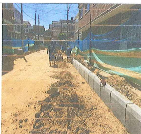
INSTALACIÓN DE SARDINELES PREFABRICADOS A-10
