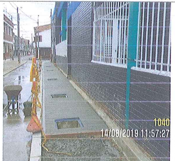
FUNDIDA EN CONCRETO DEL ESPACIO PÚBLICO EN EL JARDIN
