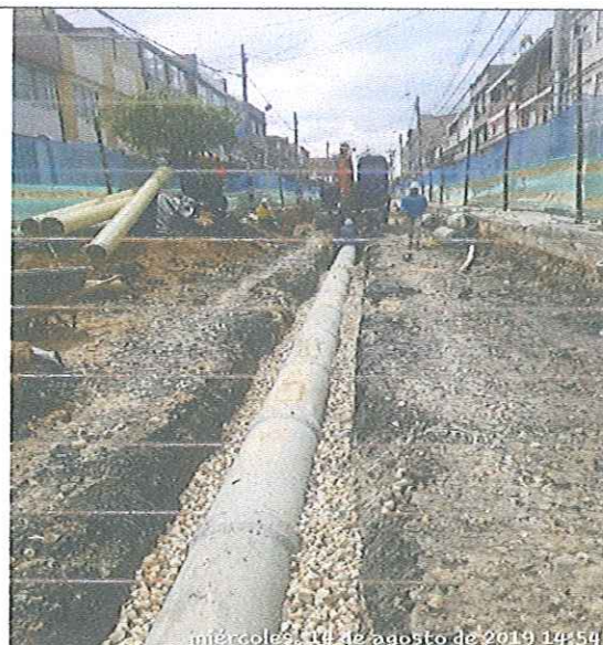
INSTALACIÓN DE LA RED PLUVIAL ULTRAREFORZADA
