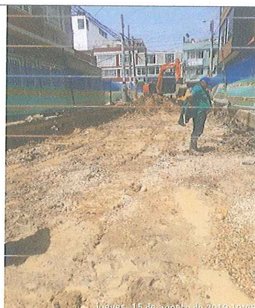
Excavación mecánica para estructura de vía
