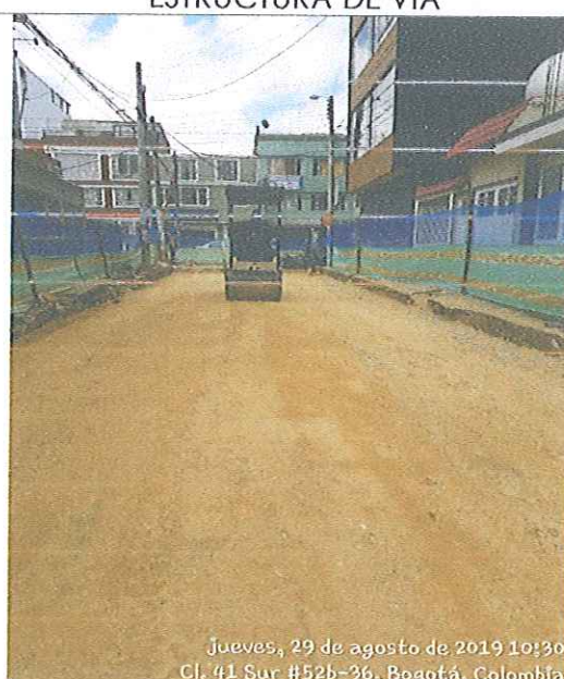
Instalación y compactación de subbase granular
