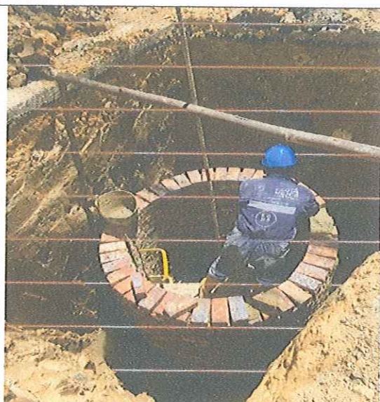
CONSTRUCCIÓN DEL POZO PARA LA RED SANITARIA
