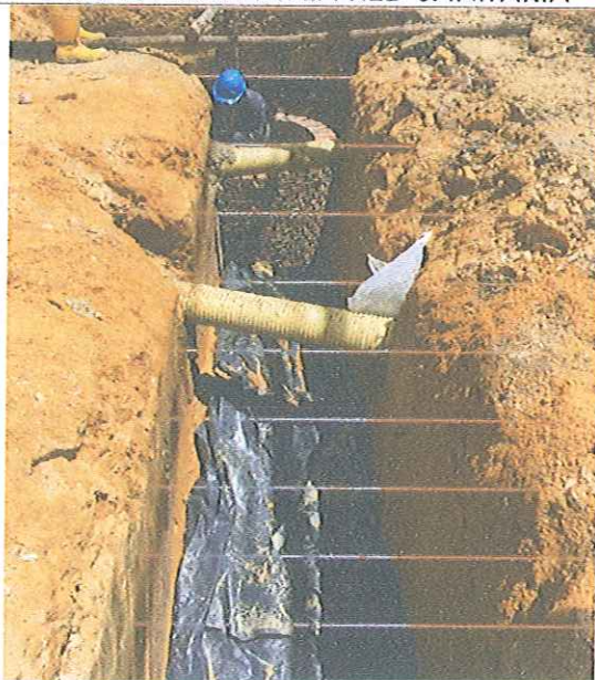
INSTALACIÓN DE LA RED SANITARIA NOVAFORT EN 8 "
