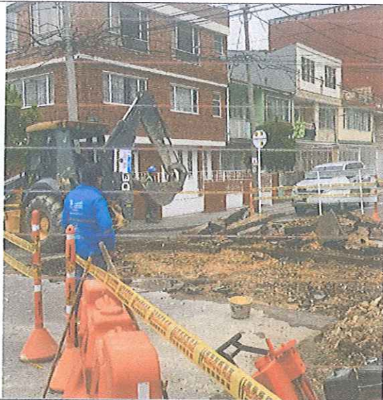
EXCAVACIÓN MECÁNICA PARA LA INSTALACIÓN DE LA RED SANITARIA
