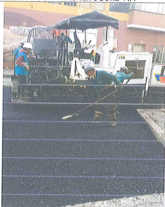
INSTALACIÓN DE LA MEZCLA ASFÁLTICA CON FINISHER SOBRE BAHÍA
