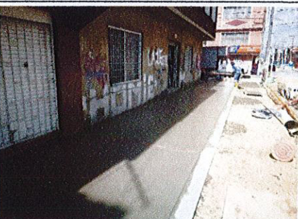
Foto 8. Instalación de concreto de planta para zona de andén costado sur. CIV 16002846
