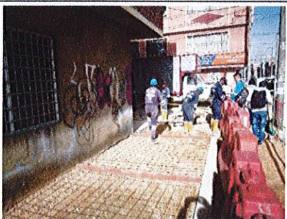
Foto 7. Renivelación de zona de andén, piezas prefabricadas, cenefas y aceros de refuerzo. CIV 16002846
