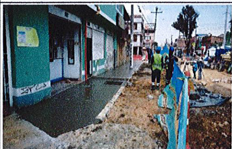
FOTO No. 7 CIV 16002879 Fundida anden en concreto
