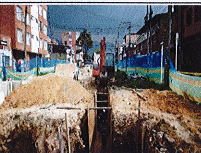
FOTO No. 8 CIV 16002905 Instalación red sanitaria 12" costado sur, rellenos en B-200.
