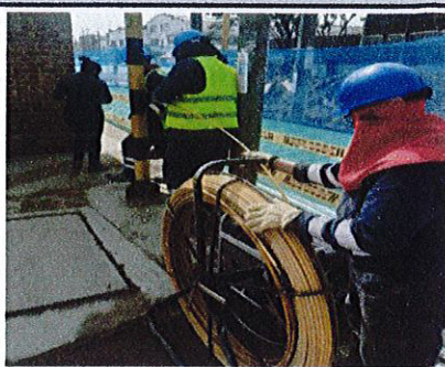
FOTO No. 2 16001745 Inspección redes semafóricas.
