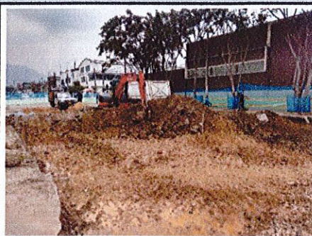
FOTO No. 3 16001745 Excavación mecánica estructura vía.
