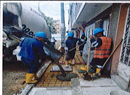
Foto No. 1. Fundida de andenes costado Oriental CIV 16001256
