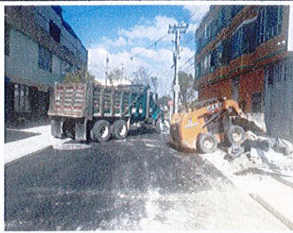
Foto 10. Retiro de escombros frente alquería 1
