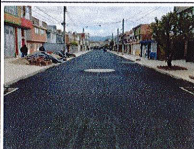
Foto 6. Instalación de mezcla asfáltica con gránulo de caucho CIV 16003173
