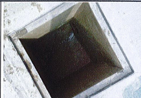
FOTO No. 1 CIV 16001256 Remate cajas de inspección domiciliarias.
