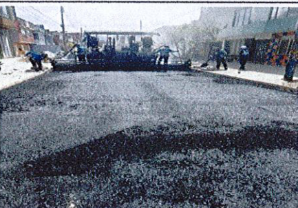
Foto 5. Instalación de mezcla asfáltica con gránulo de caucho CIV 16003173
