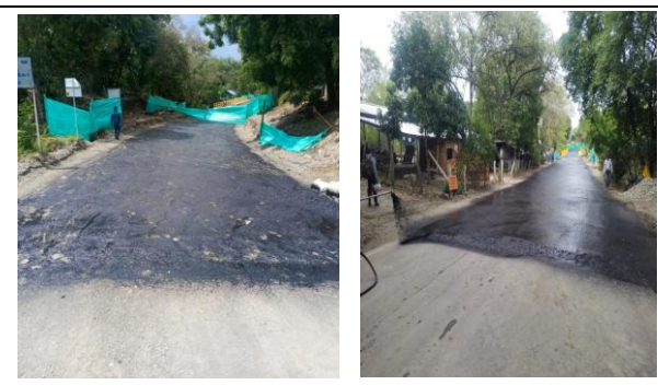
4.1 Riego de imprimación con emulsión asfáltica CRL-0
