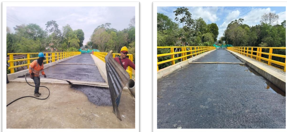
Figura No. 11. imprimación sobre loza de puente.
