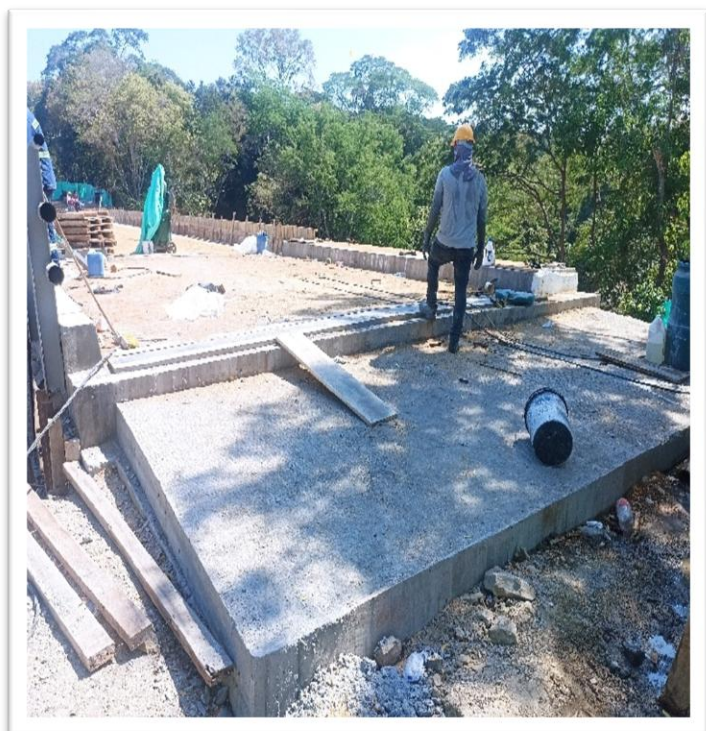
Figura No. 5. Placas de acceso a puente y terminación mediante aplicación asfalto MDC.
