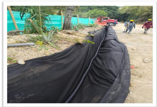
Figura No. 10. ejecución de drenes en acceso y salida puente.
