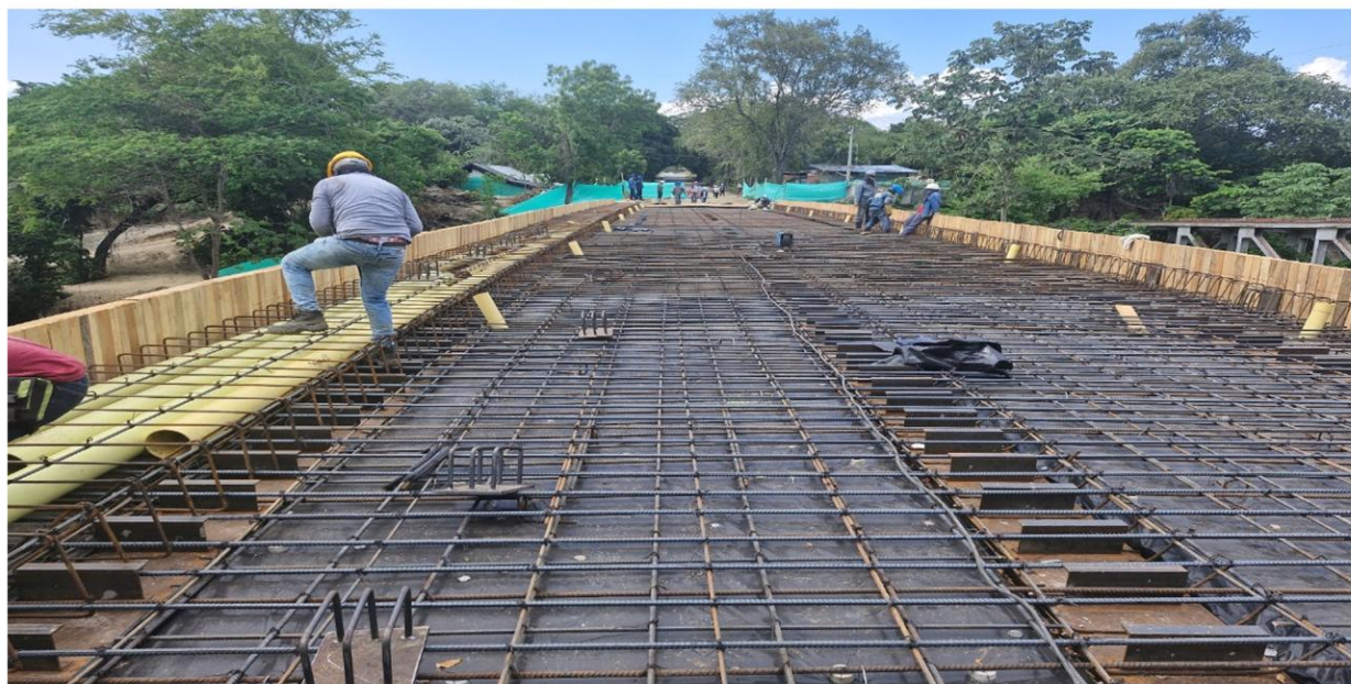
Figura No. 9. acero placa sobre estructura metálica.
