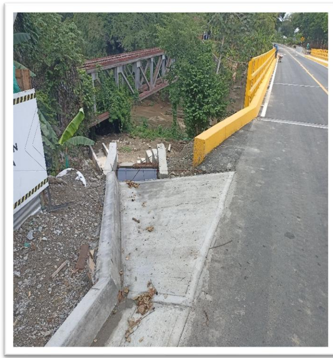
Figura No. 5. Placas de acceso a puente y terminación mediante aplicación asfalto MDC.
