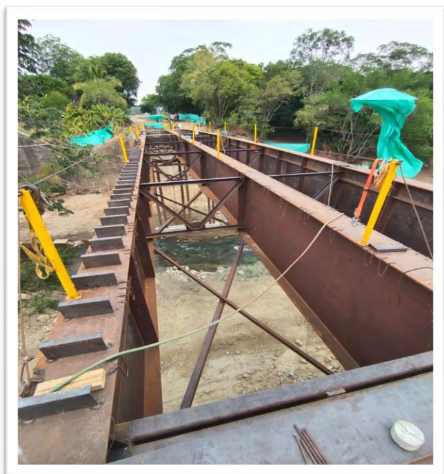
Figura No. 8. Ejecución soporte metálico placa de concreto puentes estado final ejecución contractual.
