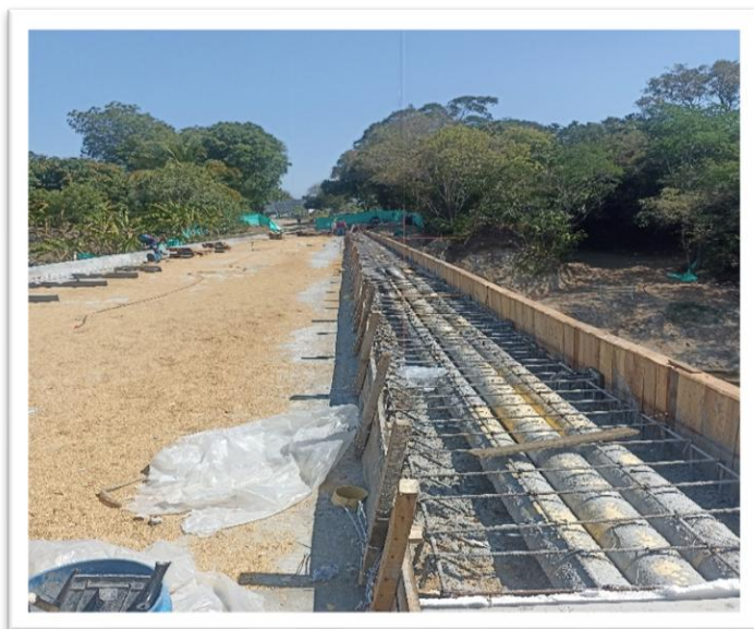
Figura No. 6. Ejecución andenes sobre puente vs terminados actuales a terminación contractual.
