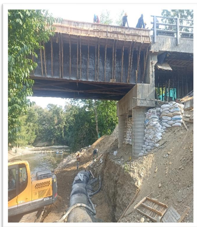
Figura No. 7. Ejecución rellenos y concretos sobre taludes puente.
