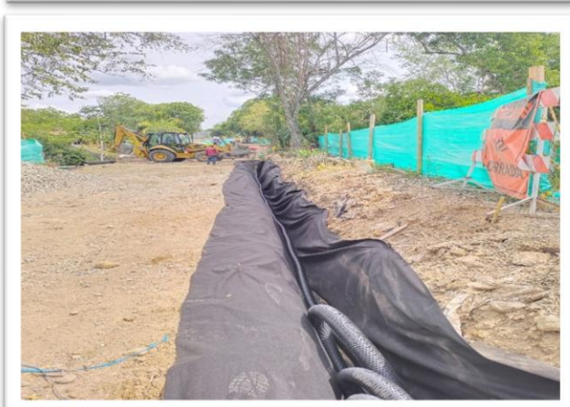
Figura No. 10. ejecución de drenes en acceso y salida puente.
