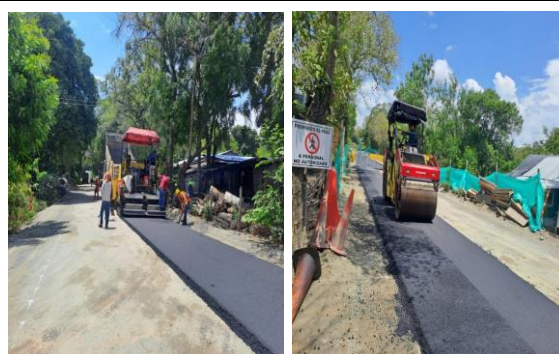
4.2 Mezcla densa en caliente Tipo MDC-19
