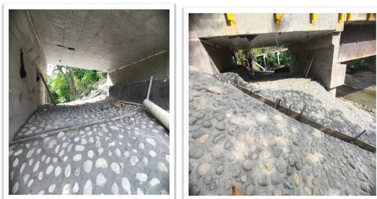
Figura No. 16. Concretos para revestimientos de taludes en puente.
