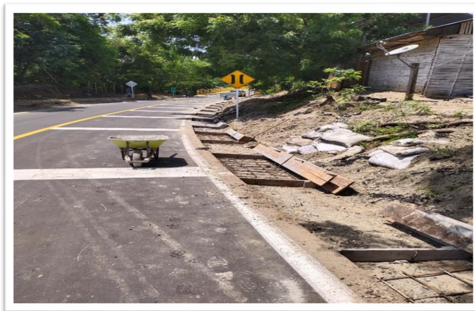
Figura No. 17. Aceros de refuerzo en cunetas longitudinales acceso y salida puente.
