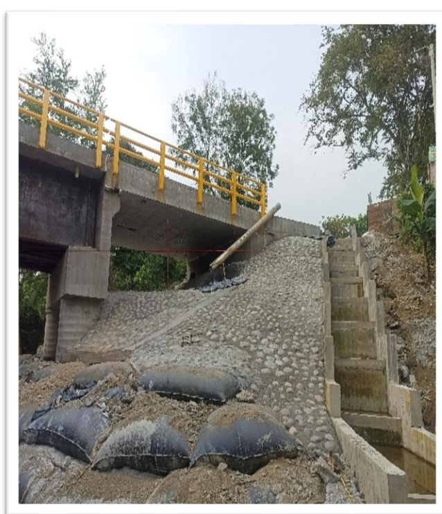
Figura No. 7. Ejecución rellenos y concretos sobre taludes puente.
