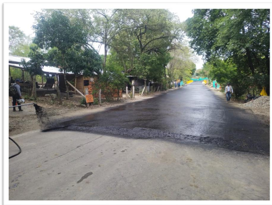
Figura No. 14. Imprimacion acceso y salida puente.
