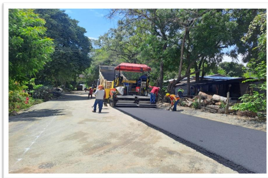
Figura No. 15. Aplicación de MDC.
