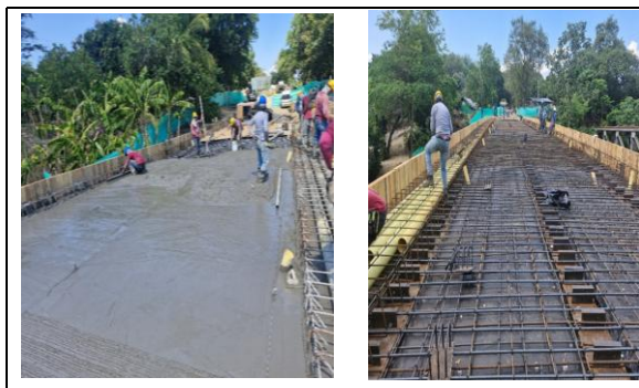
2.17 Drenos PVC para el tablero 4"
