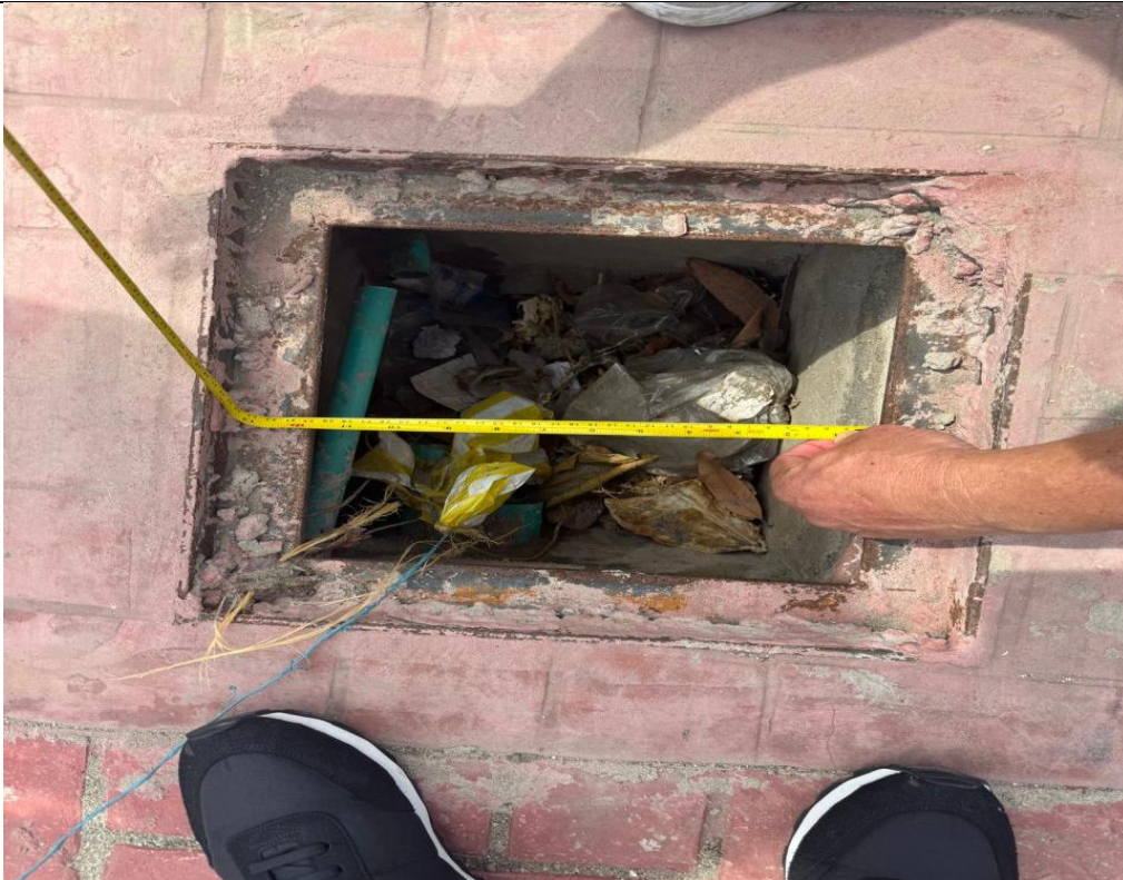
Actividad No 5 INFRAESTRUCTURA CALLE 30
