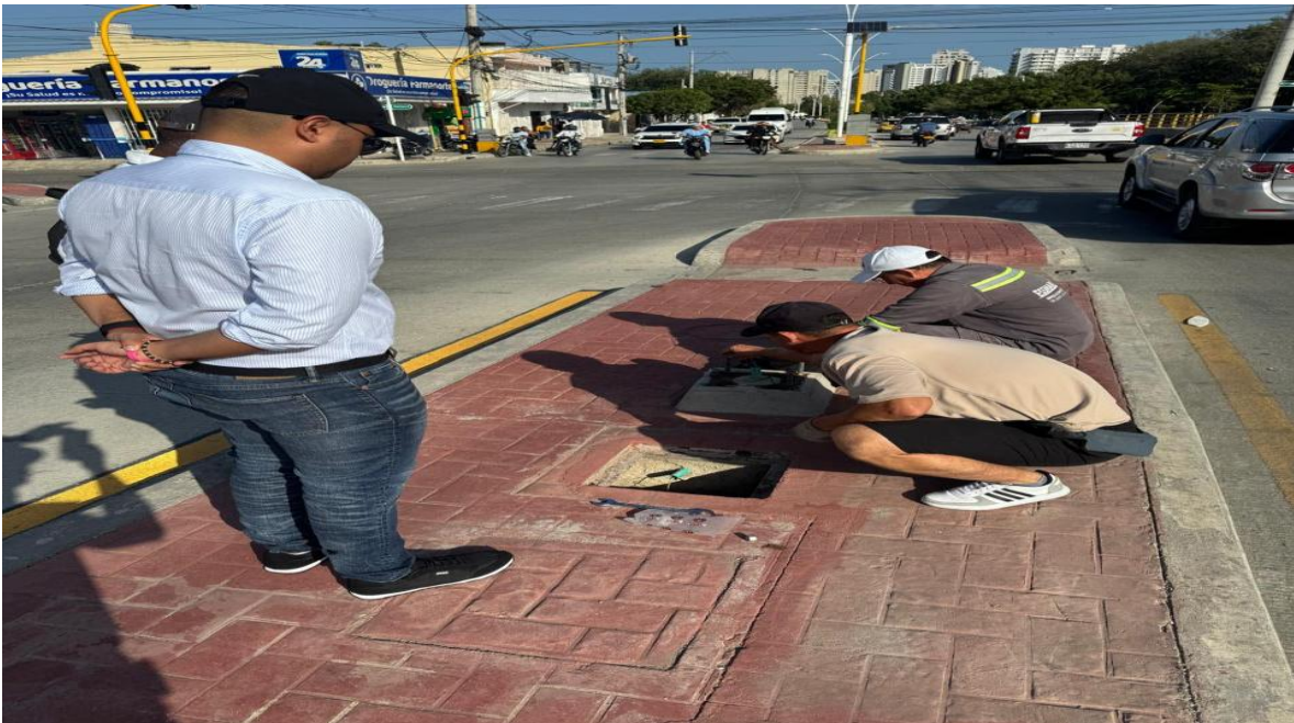
Actividad No 2 INFRAESTRUCTURA CALLE 30
