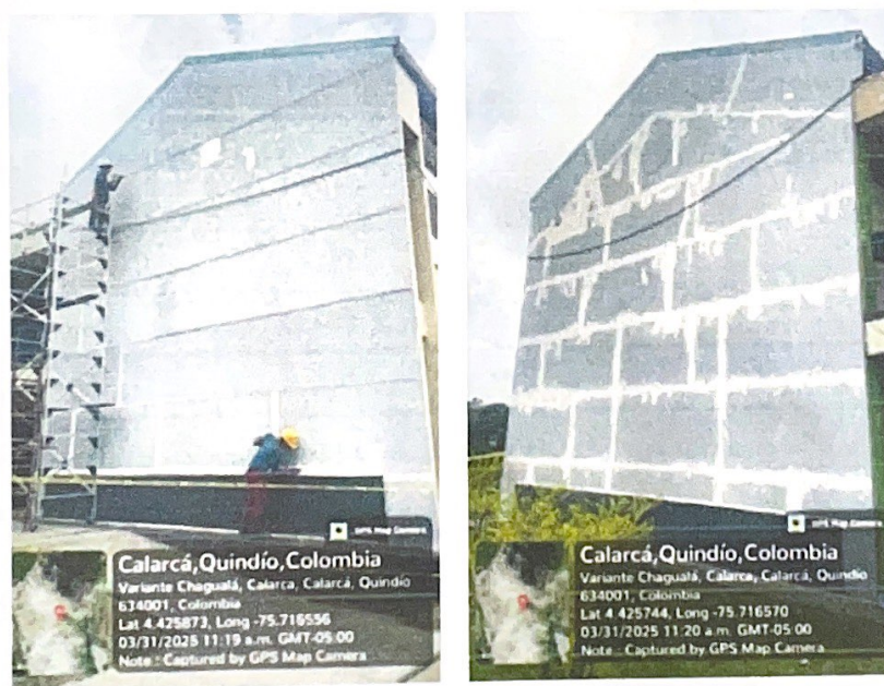
Ilustración 6. Institución Educativa San Bernardo. (Tratamiento de juntas)
