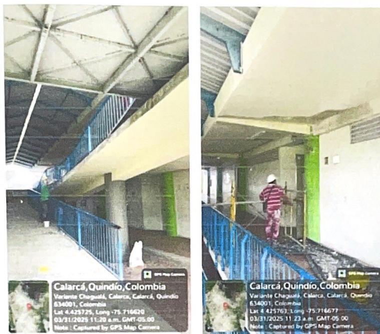
Ilustración 5. Institución Educativa San Bernardo. (e Raqueteado cielo rasos -estuco y pintura Muros)
