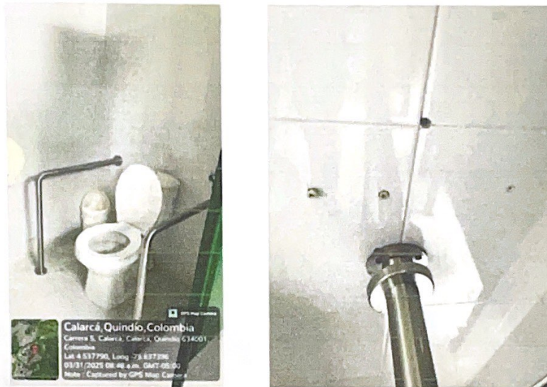
Ilustración 13. Institución Educativa Instituto Calarcá. (Adecuación baño)
