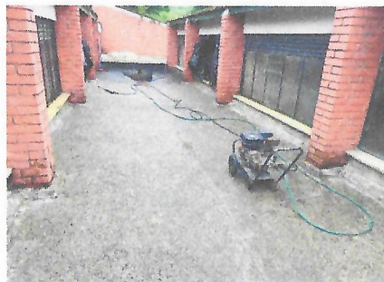
Limpieza de concreto o pisos con chorro de agua (hidrolavado)
