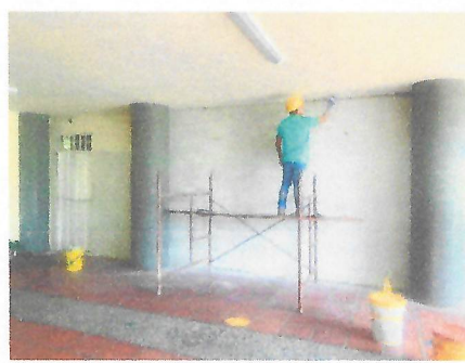
Rasqueteada y lijada de muros
