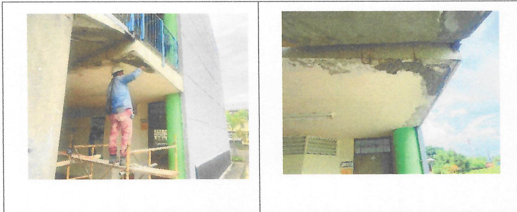
Demolición de pañetes o revoques
