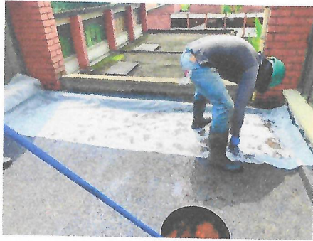
Suministro e instalación de tela asfáltica sobre superficies en concreto y/o mortero (impermeabilización)
