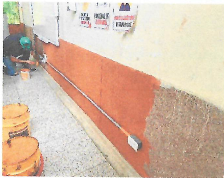
Pintura con vinilo 1 sobre muros tres manos (incluye dilataciones y filos)
