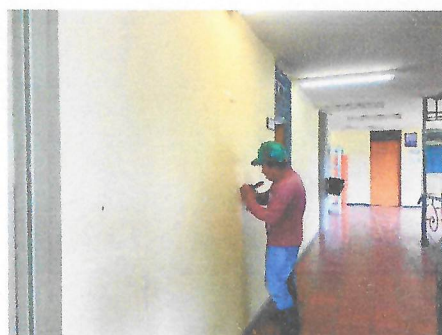
Rasqueteada y lijada de muros
