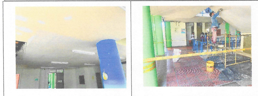
Estuco sobre Revoque o muro
