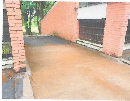
Suministro e instalación de tela asfáltica sobre superficies en concreto y/o mortero (impermeabilización)
