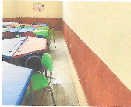
Pintura con vinilo 1 sobre muros tres manos (incluye dilataciones y filos)
