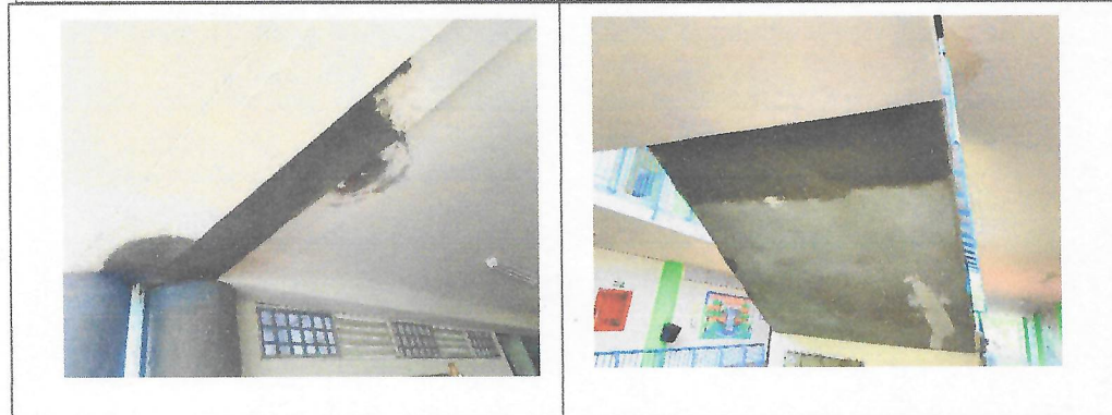
Revoque sobre muro espesor \leq 3.0 cm. Mortero 1:3
