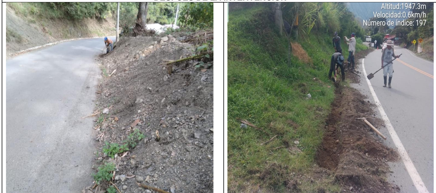
DESPUES DE LA INTERVENCIÓN
