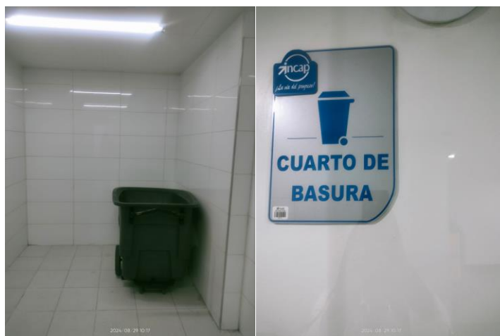
Imagen 2 Y 3. Cuarto de almacenamiento de residuos no aprovechables.
