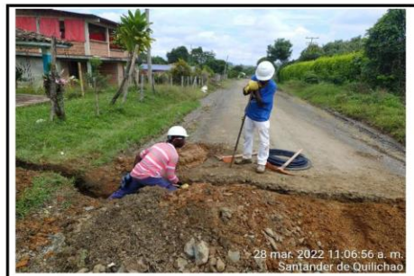
Foto No.: 7 Localización: SANTANDER DE QUILICHAO - VIA PANAMERICANA - DOMINGUILLO Descripción: PROFUNDIZACIÓN ACOMETIDAS DOMICILIARIAS EN EL TRAMO DE PLACA HUELLA
