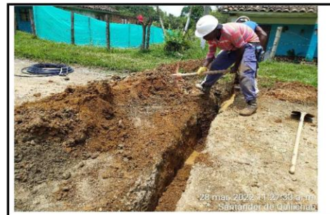
Foto No.: 8 Localización: SANTANDER DE QUILICHAO - VIA PANAMERICANA - DOMINGUILLO Descripción: PROFUNDIZACIÓN ACOMETIDAS DOMICILIARIAS EN EL TRAMO DE PLACA HUELLA
