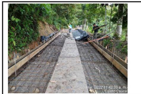
Foto No.: 5 Localización: CALOTO - VIA MARAÑO - ALBA - MORALES - PALOMERA Descripción: CONSTRUCCIÓN DE PLACA HUELLA
