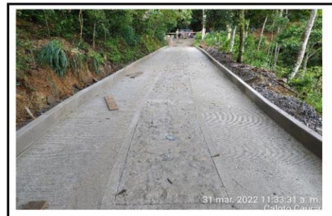
Foto No.: 6 Localización: CALOTO - VIA MARAÑO - ALBA - MORALES - PALOMERA Descripción: CONSTRUCCIÓN DE PLACA HUELLA
