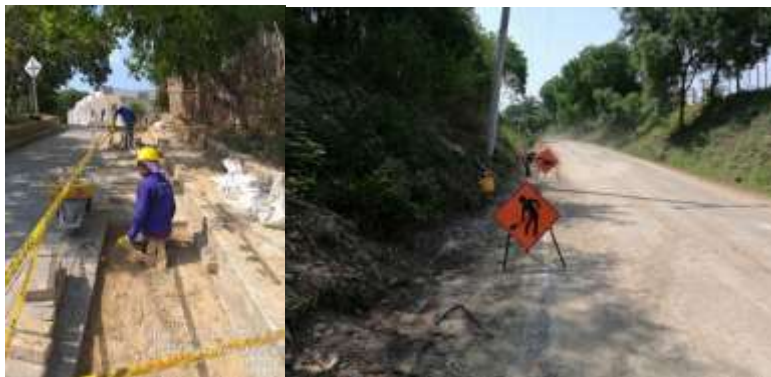
Imagen 19. Señalizaciones preventivas en zonas de intervención.
