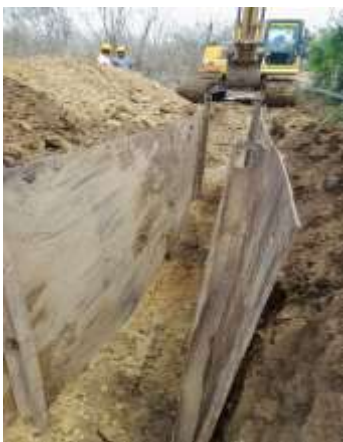
Imagen 1718. Actividades de instalación de tuberías (Sibarco).
