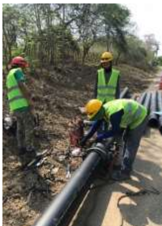
Imagen 27. Termofusión de tuberías de agua.
