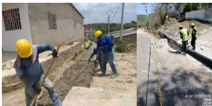
Imagen 20. Personal de obra con EPI completos.
