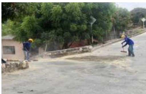
Imagen 23. Aseo en los frentes de obras.
