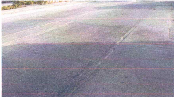
Vista estado actual Losas de pavimento con presencia de hundimiento
