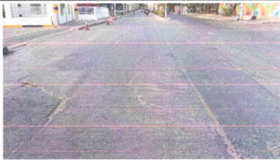
Vista estado actual Losas de pavimento facturadas y con hundimiento sobre la carrera 15 con calle 15, frente al Ara
