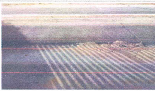
Vista estado actual Losas de pavimento sobre la carrera 15 entre 14 b y 14c con presencia de hundimiento
