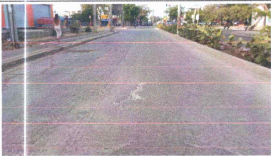
Vista estado actual Losas de pavimento facturadas y con hundimiento sobre la carrera 15 con calle 15, frente al Ara
