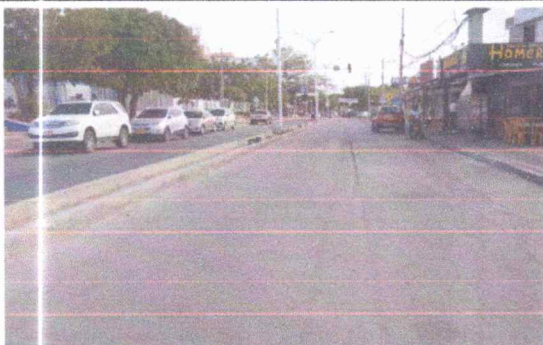
Vista estado actual Losas de pavimento fracturadas y con hundimiento sobre la carrera 15 entre la calle 12ª y 13
