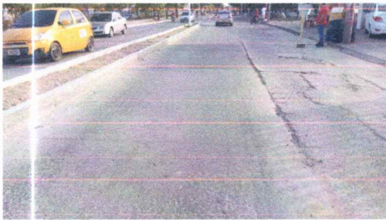
Vista estado actual Losas de pavimento sobre la carrera 15 entre 14 a y 14b con presencia de hundimiento
