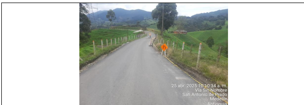
Fotografía 4. Frente Astilleros, señalización de reducción de carril a la izquierda, que no tiene nada que ver con el estado de la obra.
