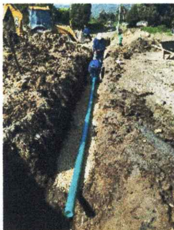
CANALIZACIÓN SUBTERRÁNEA CON 1 DUCTO DE 4" PVC TDP, ACCESORIOS, EXCAVACIÓN, RELLENOS Y ACABADO (INCLUYE SUMINISTRO E INSTALACIÓN) (ML)
