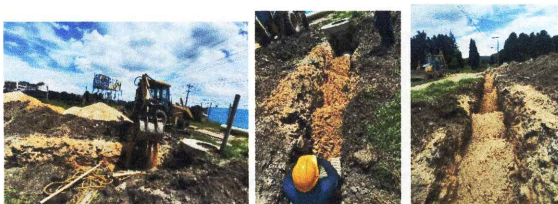
RELLENO TIPO 4 "SUBBASE B-200" (M3)
