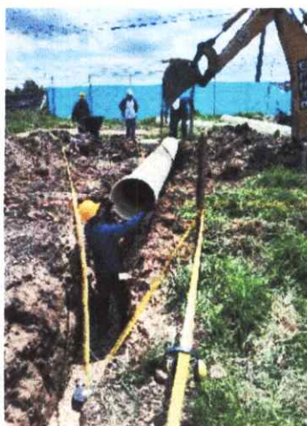
TUBERÍA PVC ALCANTARILLADO REFORZADO 20" (ML)
