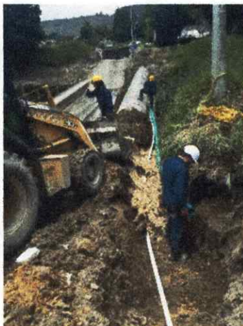
CANALIZACIÓN SUBTERRÁNEA CON 1 DUCTO DE 4" PVC TDP, ACCESORIOS, EXCAVACIÓN, RELLENOS Y ACABADO (INCLUYE SUMINISTRO E INSTALACIÓN) (ML)
