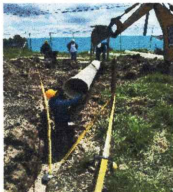
CANALIZACIÓN SUBTERRÁNEA CON 1 DUCTO DE 4" PVC TDP, ACCESORIOS, EXCAVACIÓN, RELLENOS Y ACABADO (INCLUYE SUMINISTRO E INSTALACIÓN) (ML)
