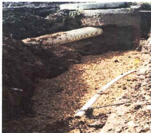
TUBERÍA PVC ALCANTARILLADO REFORZADO 20" (ML)
