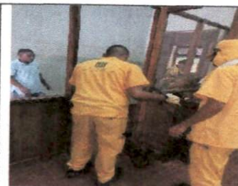
Evacuación y despeje de áreas a intervenir en casa bolívar
