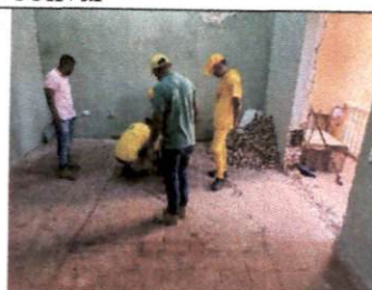
Ejercicio de replanteo en obra nueva, casa bolívar
