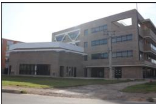
Figura 3. Vista externa edificio
