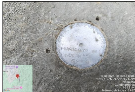
Imagen No. 2: Verificación de instalación de los GPS 3 y 4
