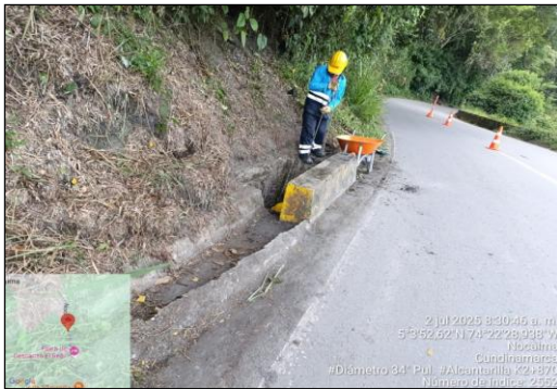
Imagen No. 3: Inspección labores de limpieza de alcantarilla Km 2+870, lado encole.
