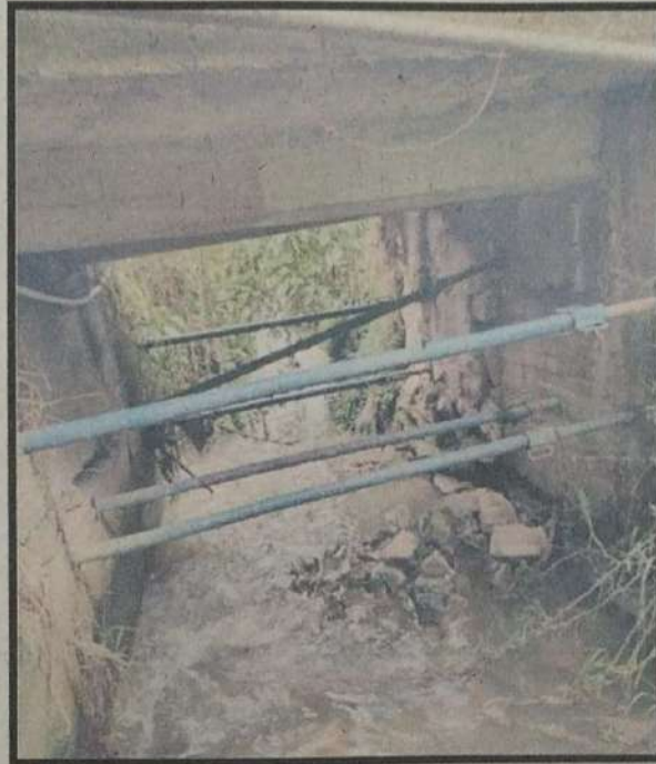
Puente Macondo Apoyos Temporal
