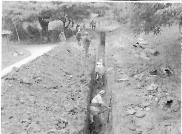
Relleno red alcantarillado
