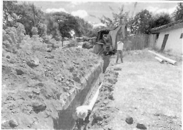
Instalación de tubería PVC sanitaria
