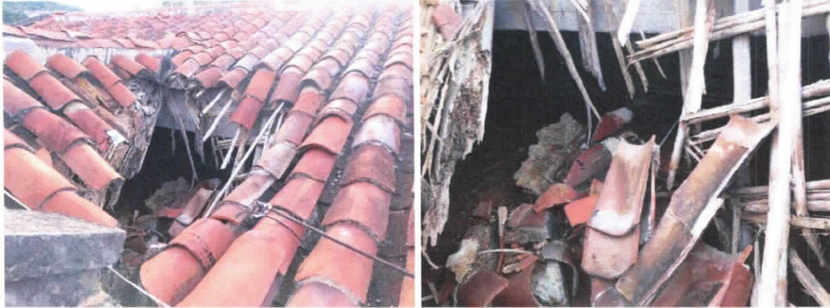
Localización inicio de adecuación Cobertura.
